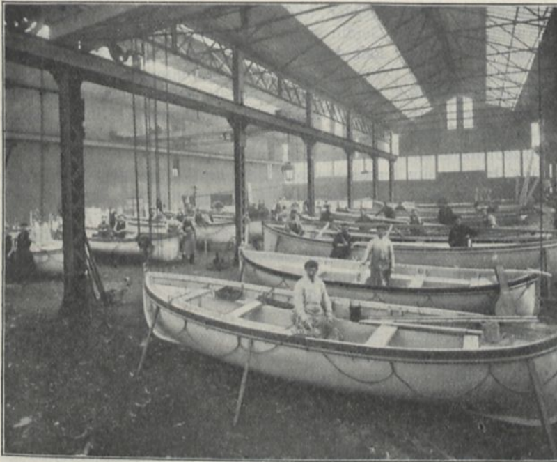
Montierhalle mit Rettungsbooten und anderen Fahrzeugen in verschiedenen Konstruktionsstadien.
