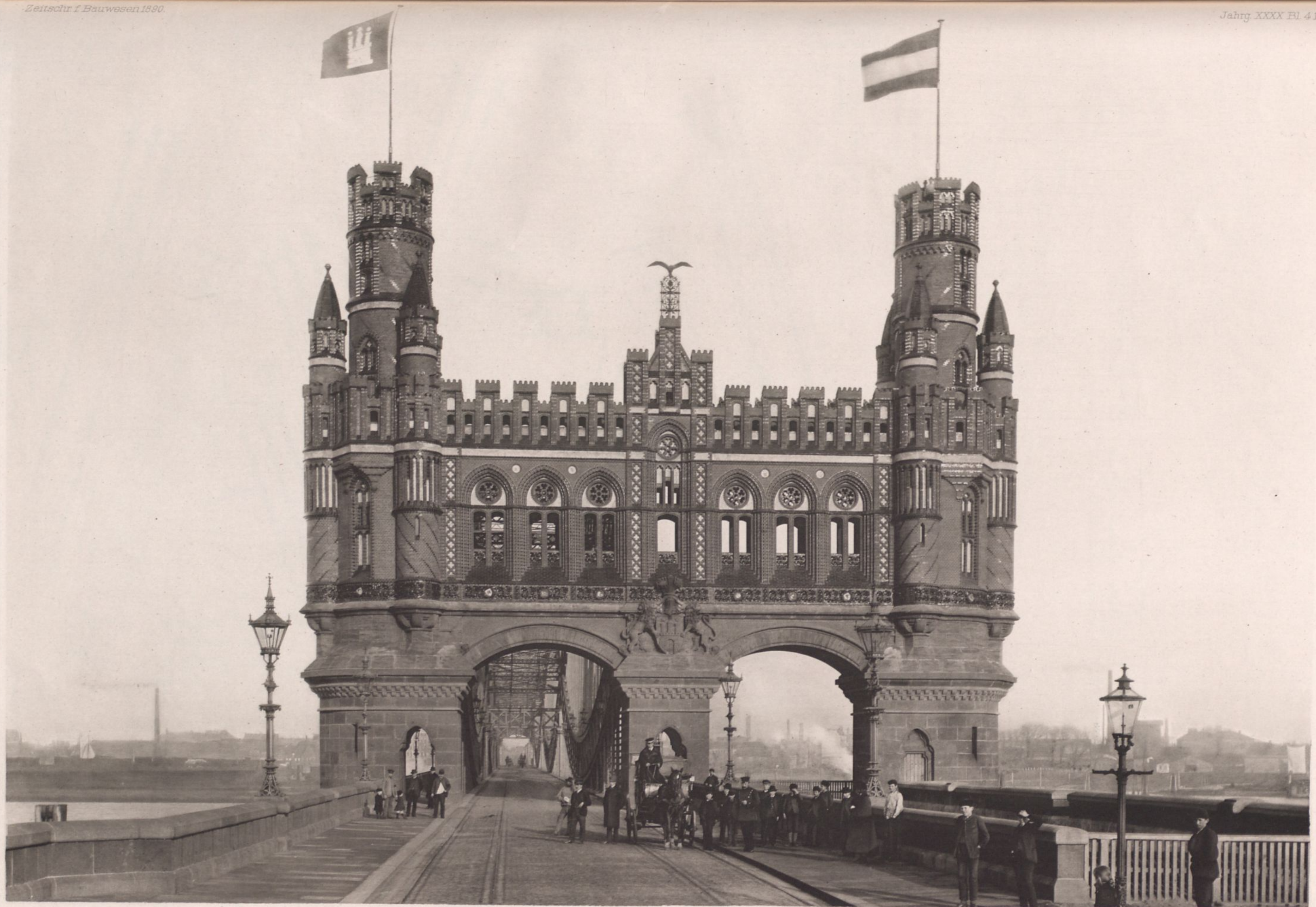
Portal der Strassenbrücke über die Norderelbe bei Hamburg.
