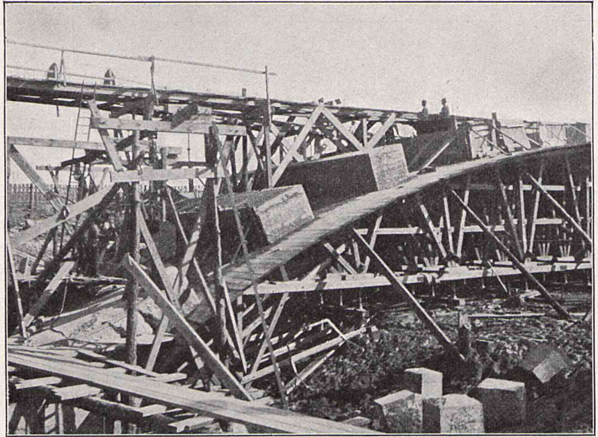
Abb. 28. Chausseestraßenbrücke in Britz. Ausführung des Betongewölbes.
