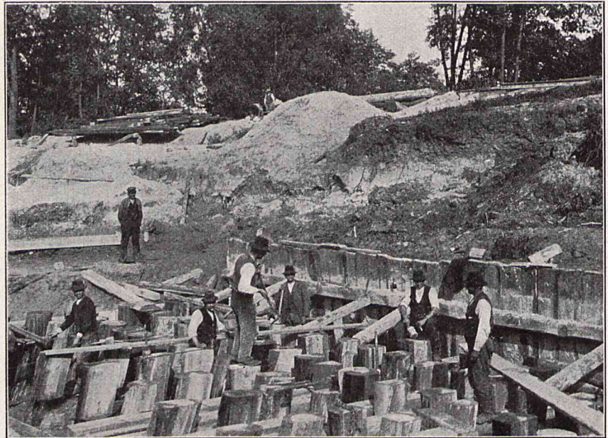
Abb. 29. Giesensdorfer Straßenbrücke. Anbringen der Zangen und Holme des Pfahlrostes.
