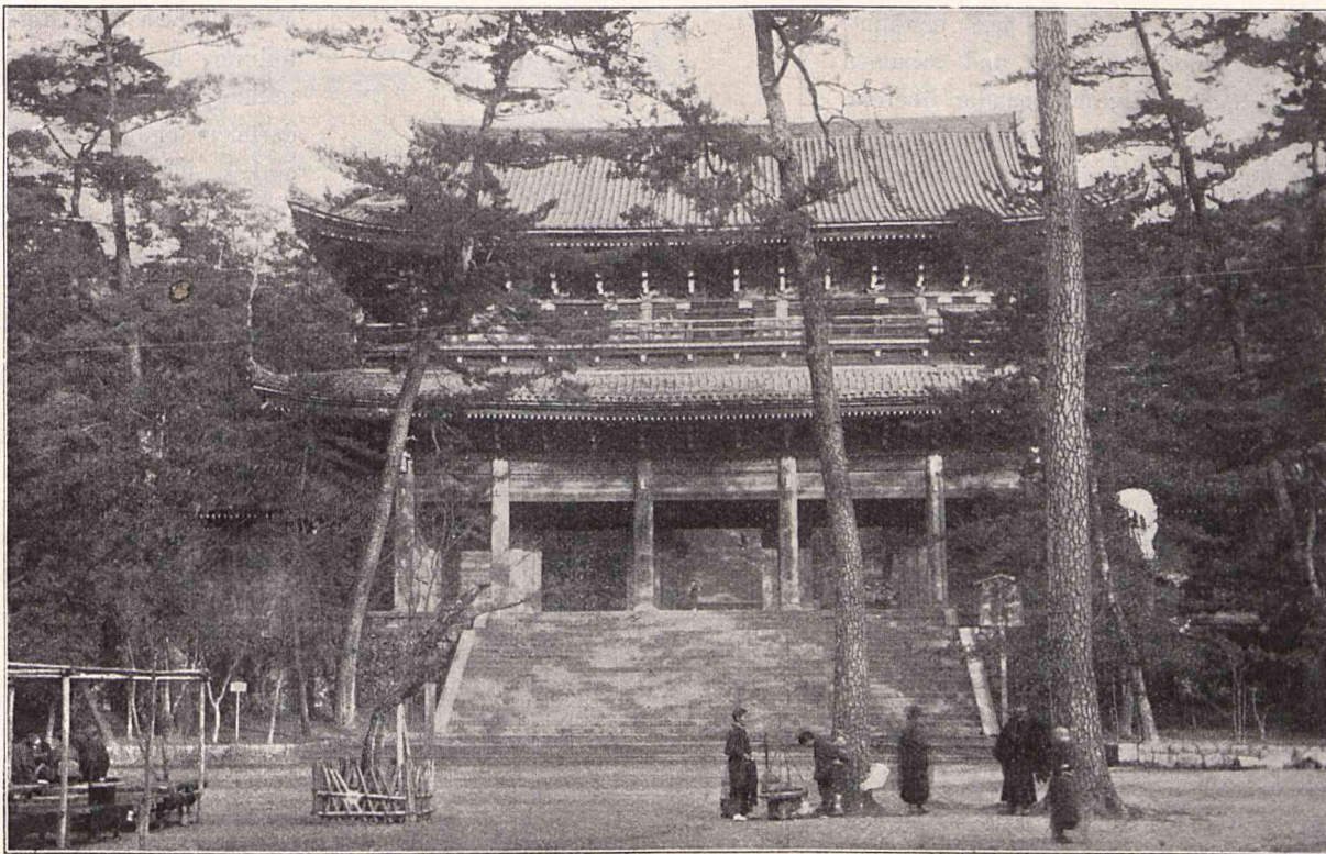
Abb. 197. Außentor von Chion-in in Kioto.
