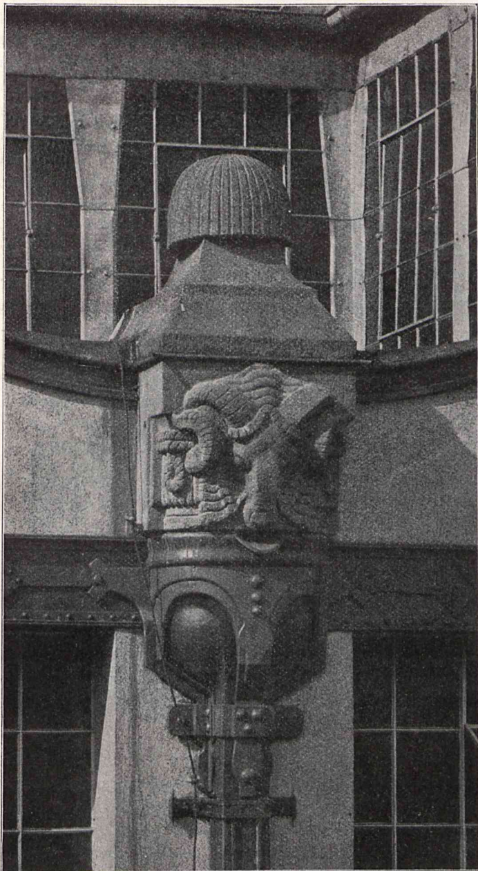
Abb. 16. Schlußstein über den Einlaufkästen der Regenabfallrohre.
