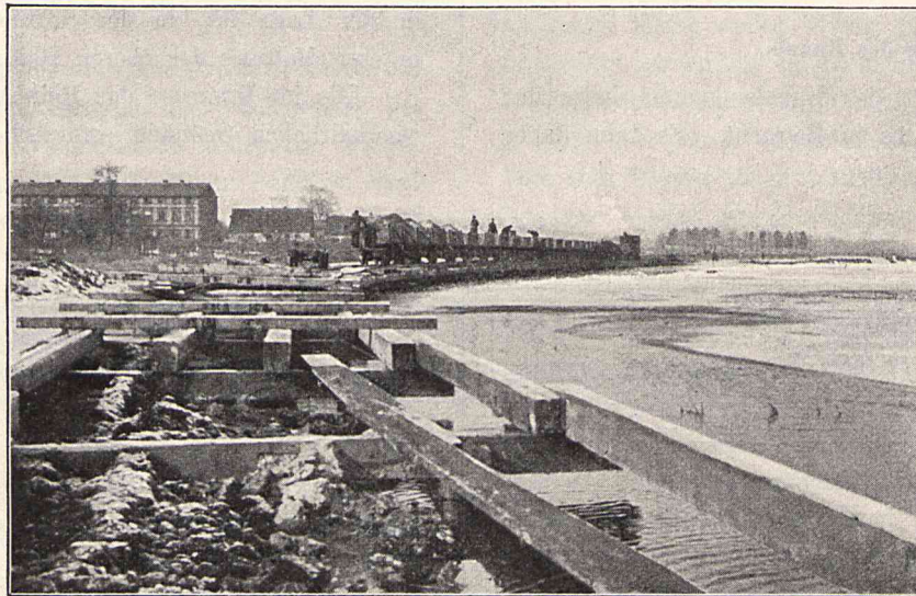
Abb. 6. Schüttgerüst im Schönowsee.
