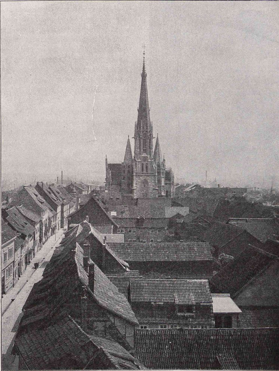
Abb. 2. Ansicht von Westen (vom Rabenturm) nach dem Umbau.
