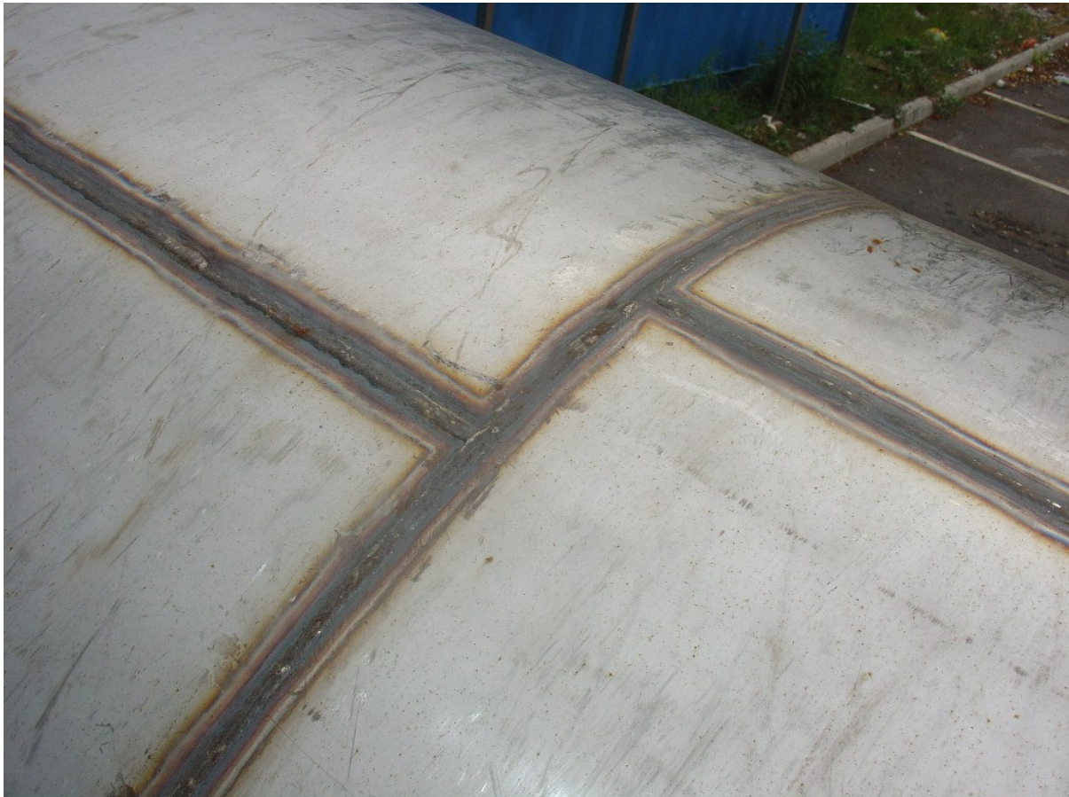
Rys. 3.1. Spoiny wzdłużne i obwodowe
