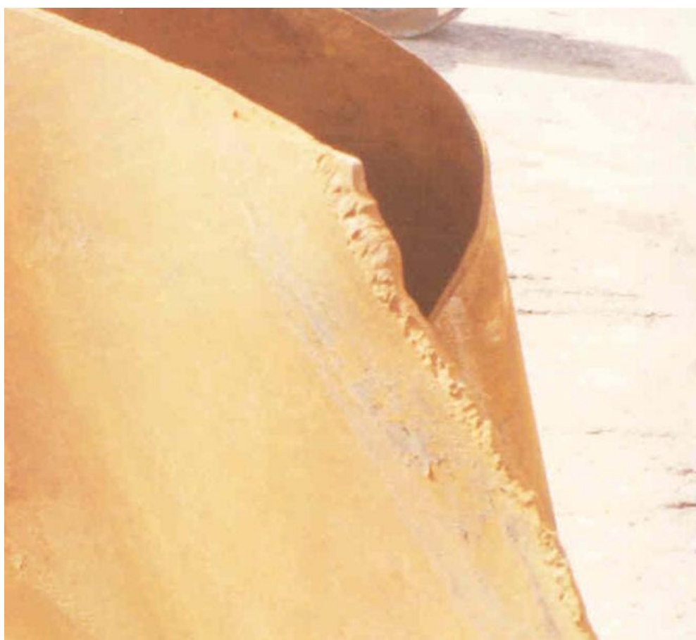
Rys. 3.6. Zerwana spoina po eksplozji gazociągu
