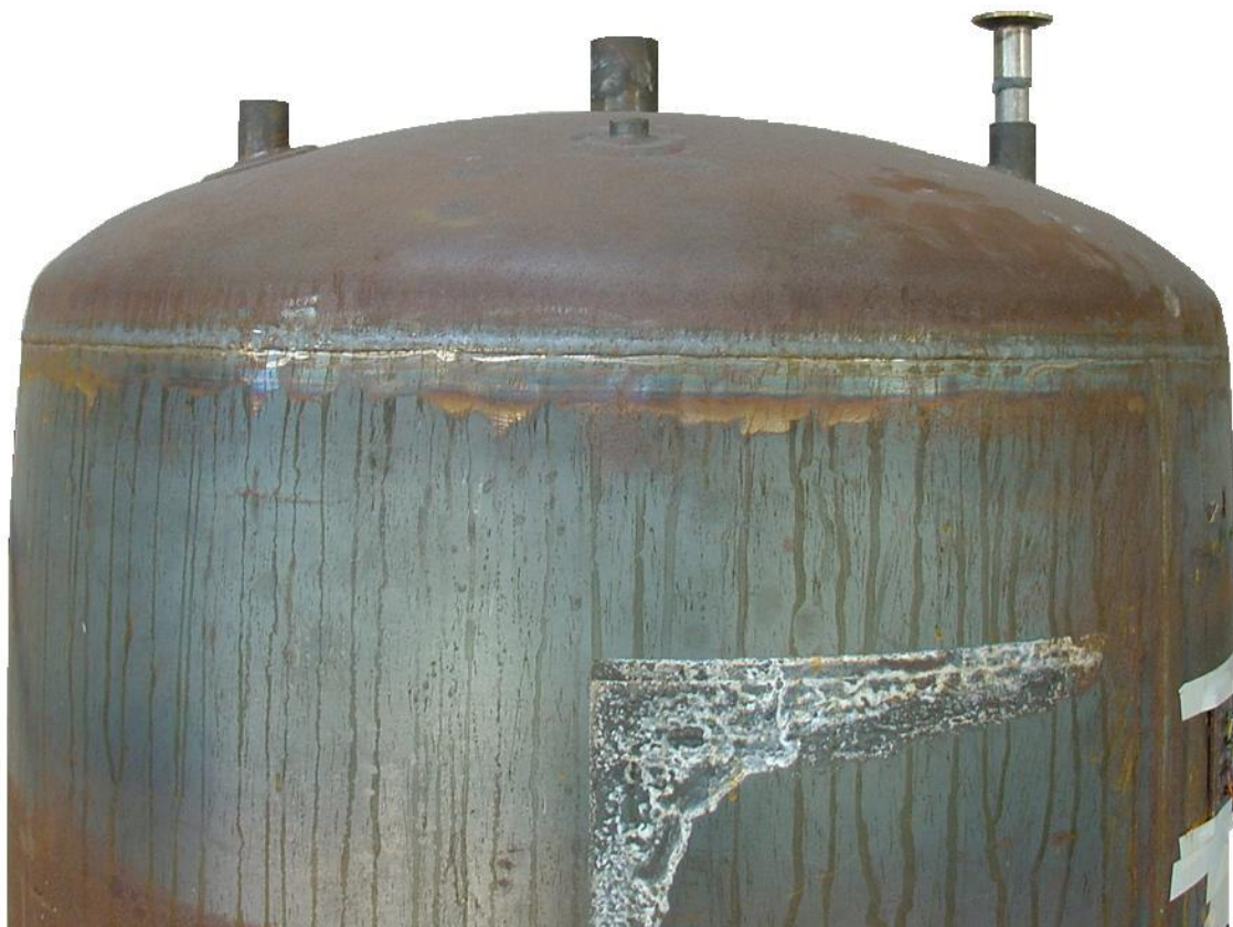
Rys. 7.9. Widok ogólny zbiornika przed i po przepiężaniu – dennica górna
