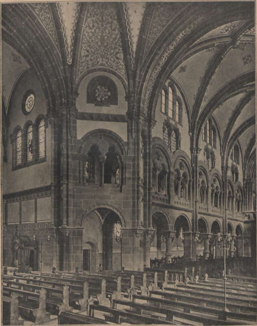
Abb. 97. Inneres der Wiehre-Kirche in Freiburg i. B. Architekt: JOSEF DURM.
