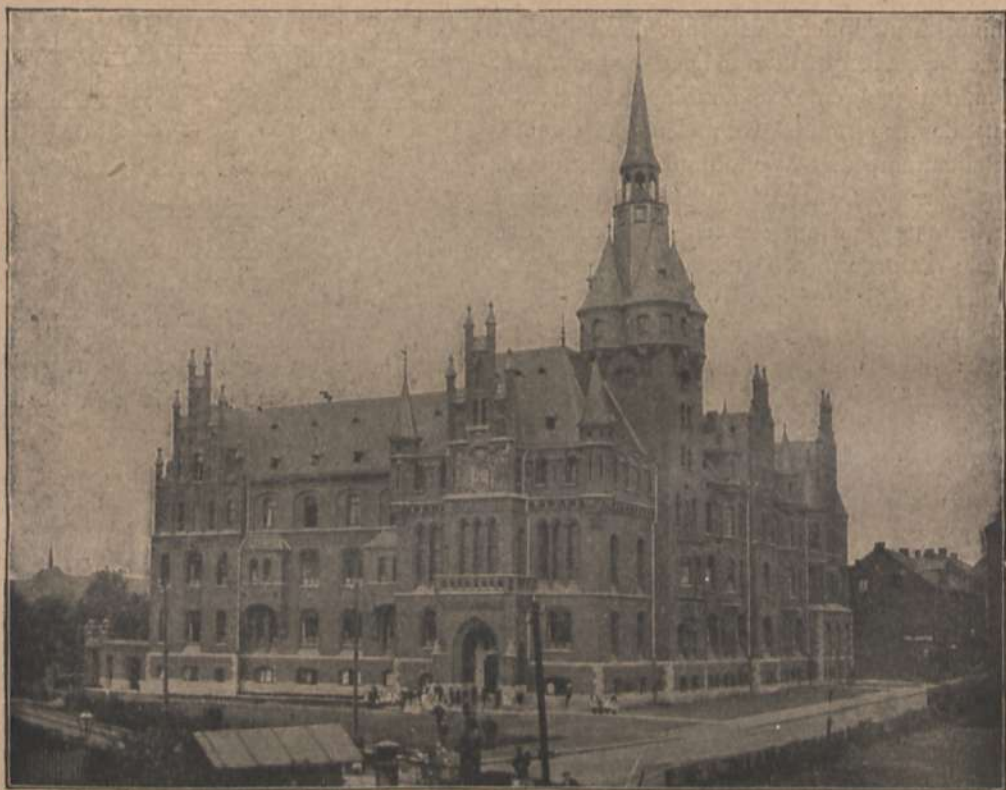
Abb. 135. Ansicht des Rathauses in Gelsenkirchen. Architekt: WIETHASE.
