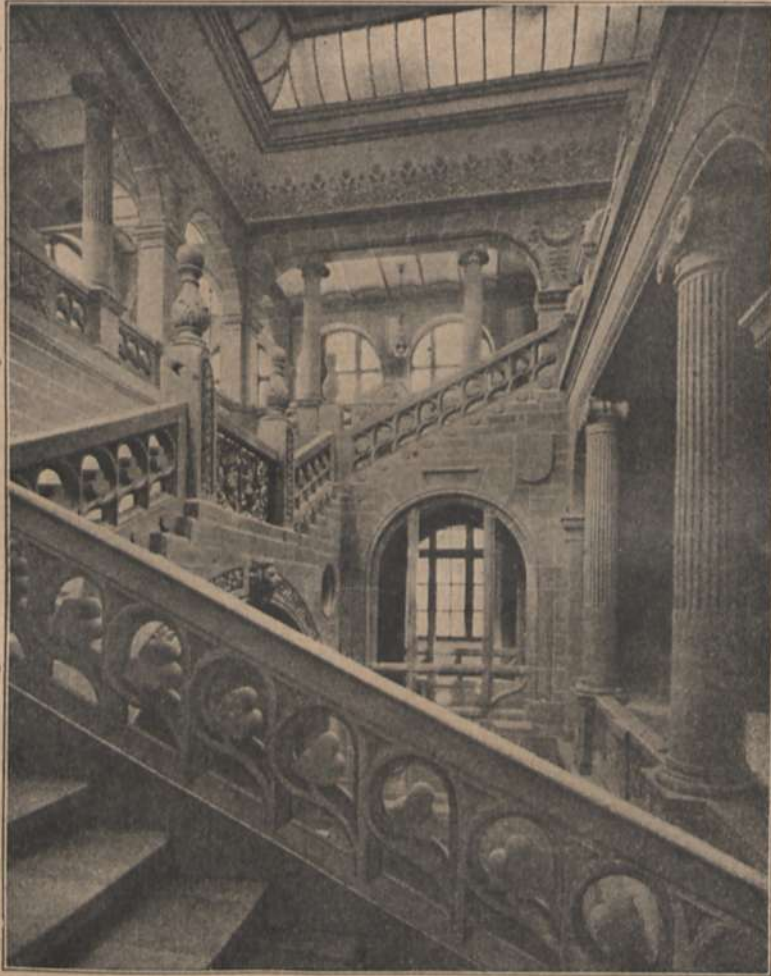
Abb. 114. Ansicht des Treppenhauses des Oberlandesgerichtsgebäudes zu Karlsruhe. Architekt: JOSEF DURM.
