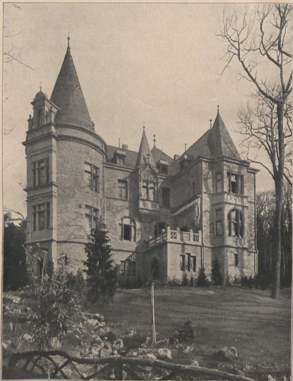
Abb. 54. Ansicht des Schloßchens der Gräfin Allcard-Konarska. Architekt: J. DURM.
