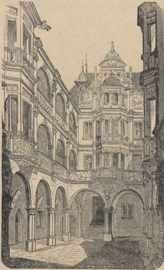
Abb. 62b. Pellerhaus zu Nürnberg. Hof.
