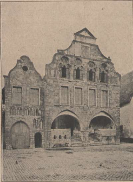
Abb. 115. Rathaus in Dortmund. (Ältestes erhaltenes Beispiel in Deutschland. 1240.) Nach einer Photographie der Meßbildanstalt in Berlin.
