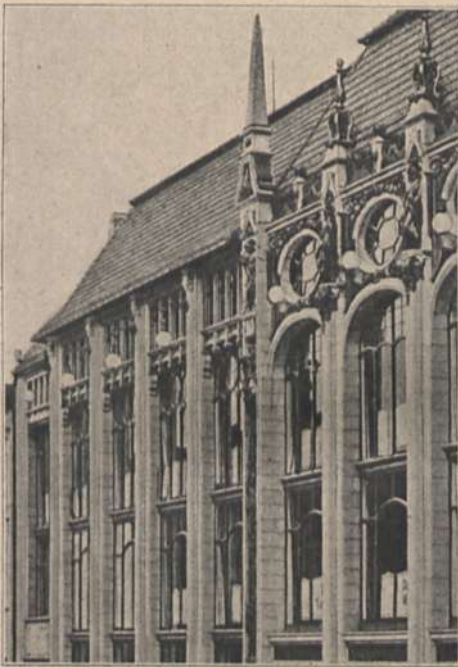
Abb. 21. Warenhaus Wertheim in Berlin. Architekt: MESSEL.
