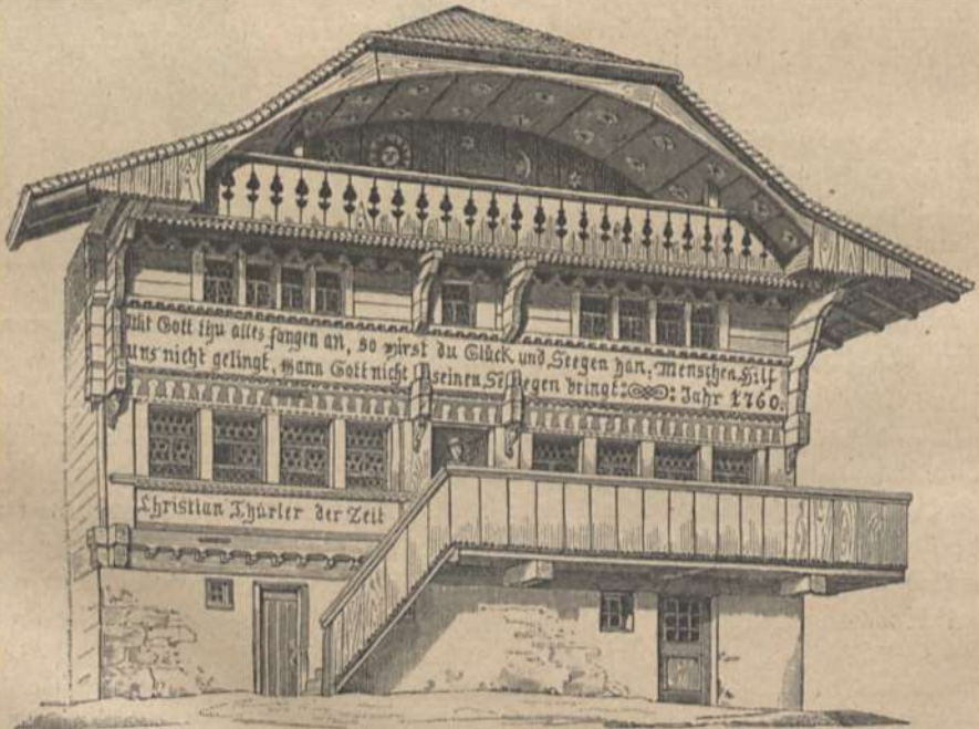
Abb. 32. Vereinigter Block- und Ständerbau.
