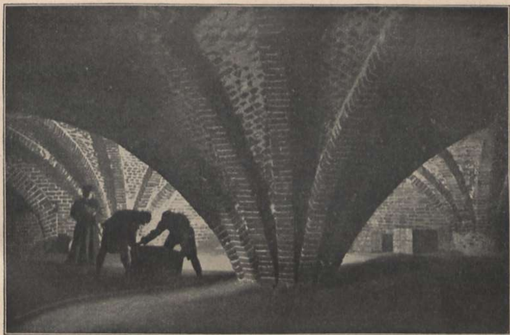
Abb. 3. Kellergewölbe in der Marienburg.
