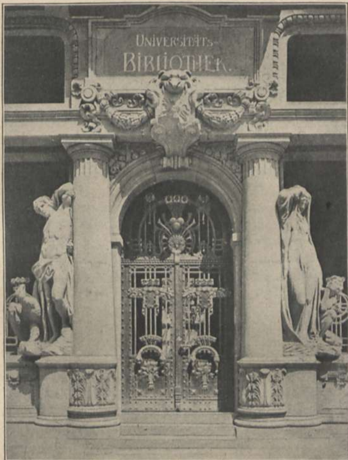
Abb. 9. Portal der Universitätsbibliothek in Heidelberg.
