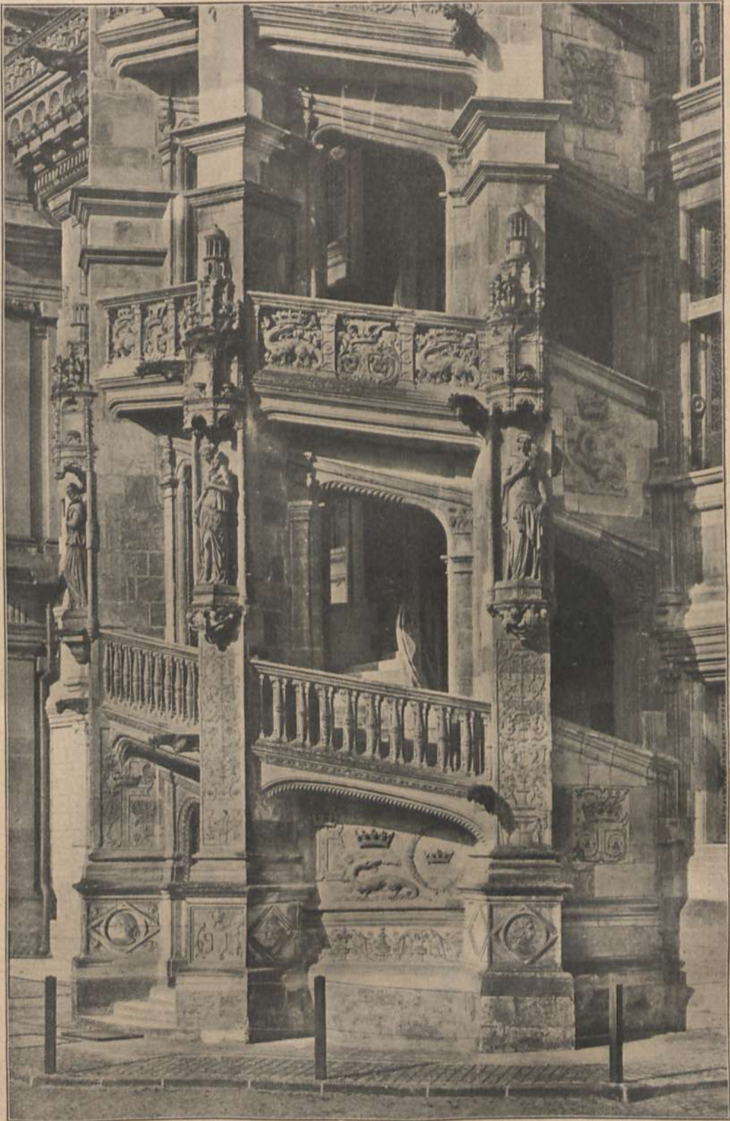
Abb. 29. Treppe aus dem Schloß zu Blois.
