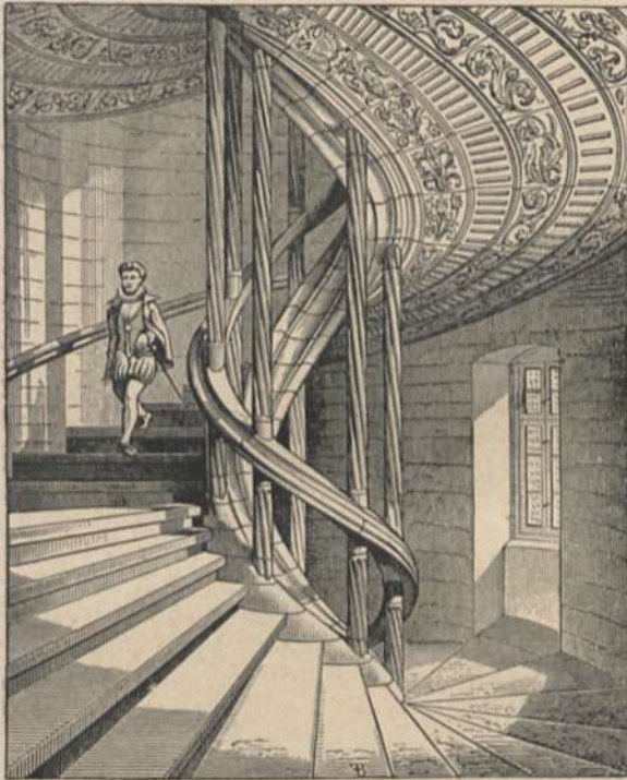
Abb. 30. Treppe in Mergentheim.
