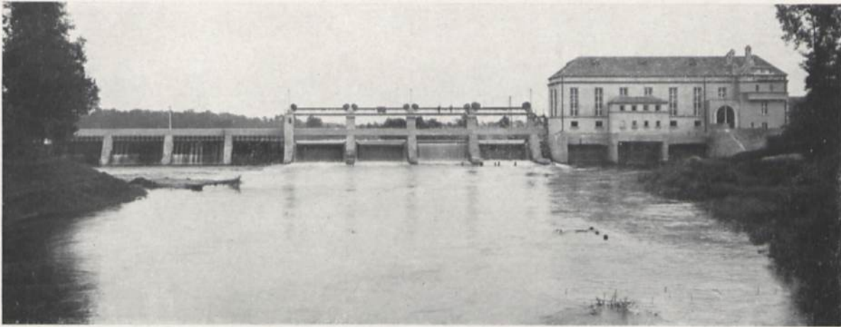
Boberkraftwerk Greisitz Kreis Sagan.
