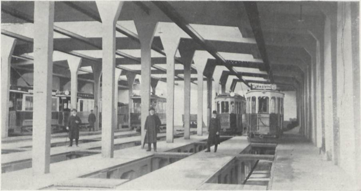
Straßenbahnwagenhalle Magistrat Breslau, Weißenburger Straße
