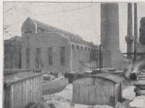
Kesselhaus-Erweiterungsanlage auf Preussengrube in Miechowitz bei Beuthen O.S.
