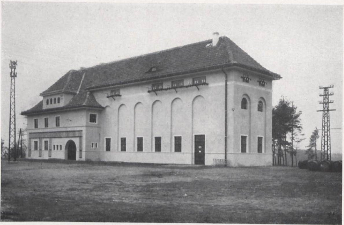
Haupt-Schaltstation Herderberg bei Sagan.
