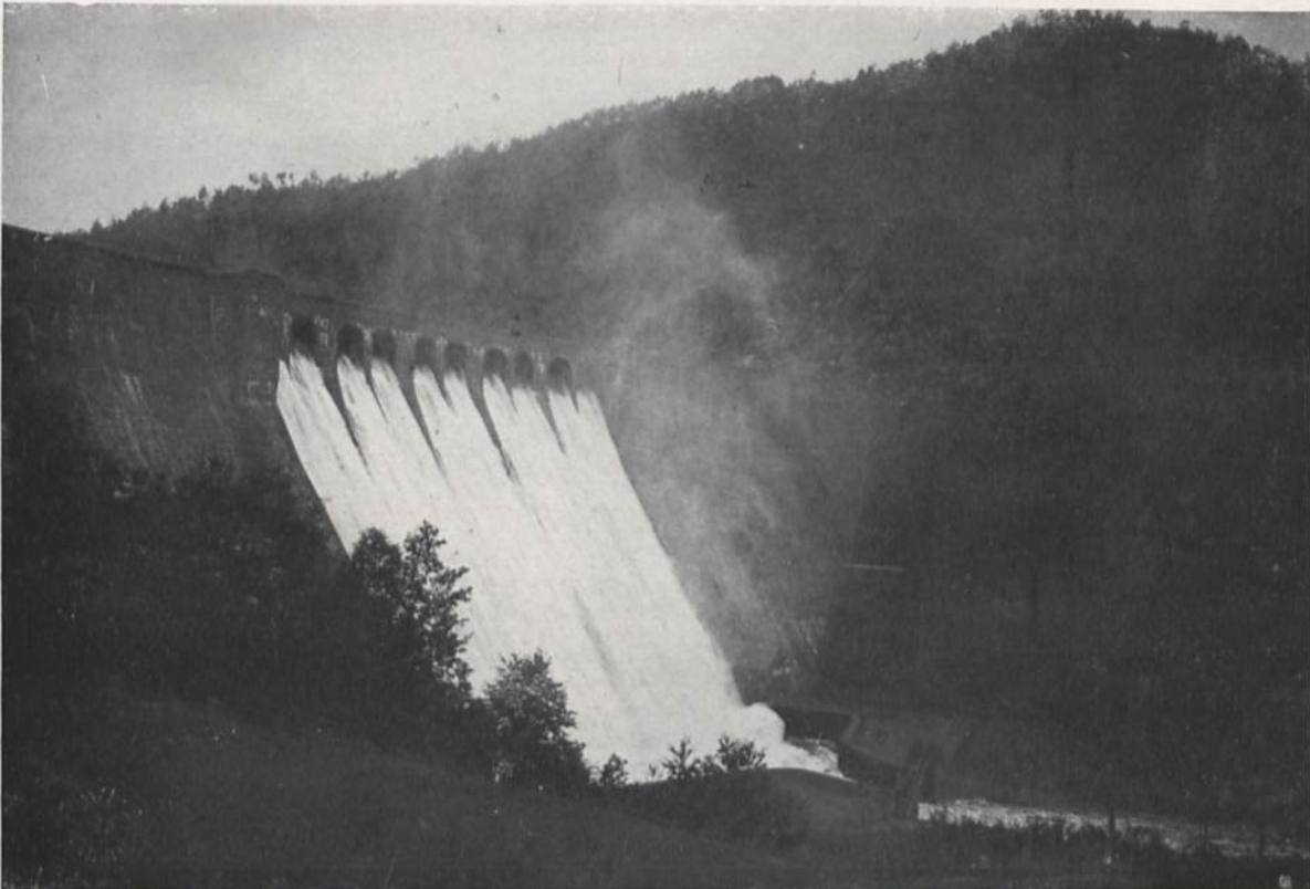
A b. 4b Talsperre bei Breitenhain. / Erbaut 1912—1917. / Stauraum 8 Millionen cbm. / Des Stausees Oberfläche 51 ha; Länge 3,3 km. Länge der Sperrmauer 230 m. / Höhe der Sperrmauer vom Felsgrunde 44 m. / Breite am Felsgrunde 29 m. Im Kraftwerk ca. 1000 m unterhalb der Sperrmauer; 3 Turbinen — 2 \times 720 + 290 PS = 1730 PS. / 3 Drehstrom-Erzeuger 2 \times 685 + 275 kVA = 1645 kVA. / Durchschnittliche Jahresleistung: 4 Millionen Kilowattstunden.
