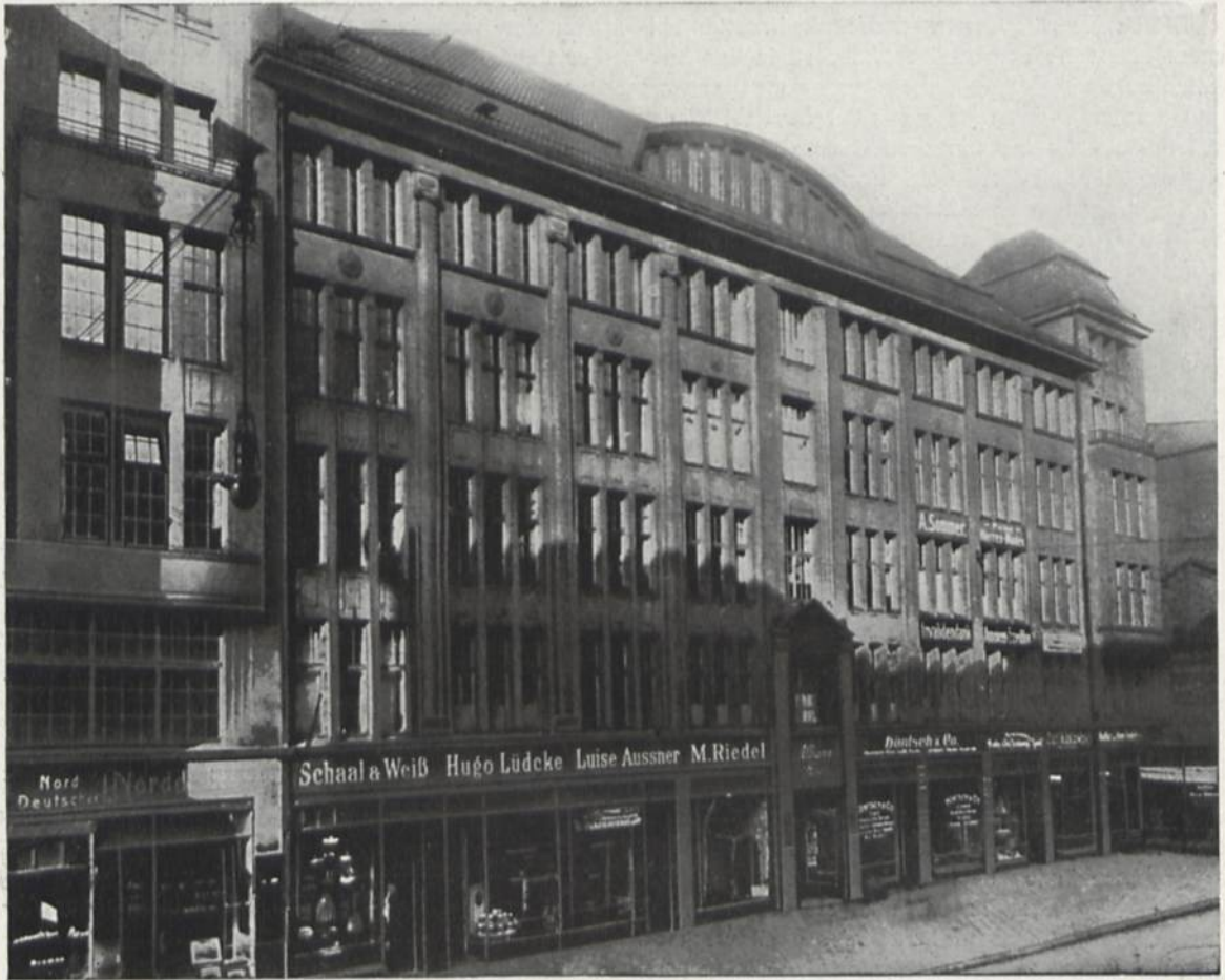
„Allianzhaus in Breslau, Neue Schweidnitzerstrasse 6“
