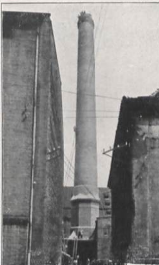
Schornsteinbau bei St. E. W. Breslau
