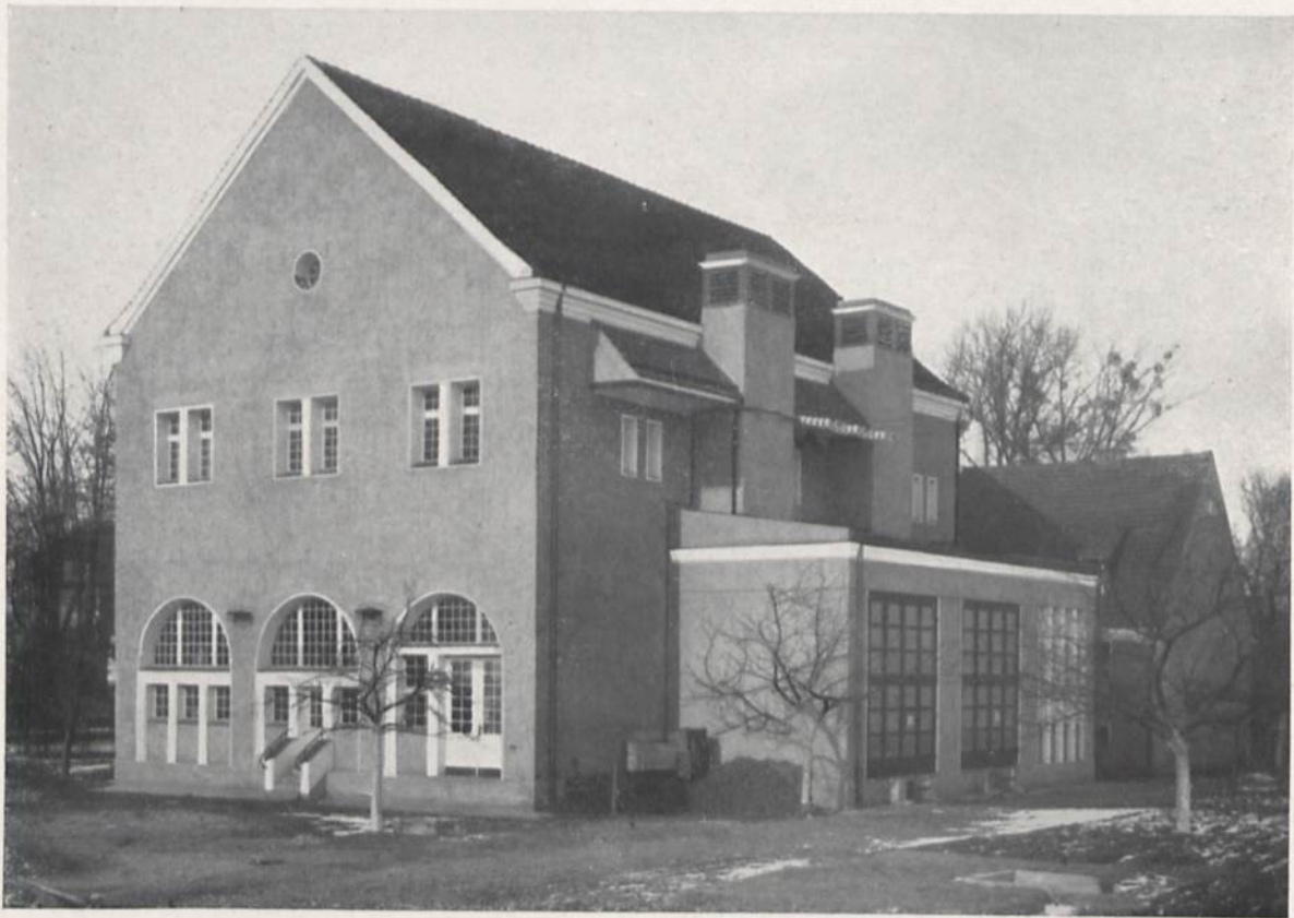
Umspannwerk Zawadzki für 60 000/15 000/6000 Volt
