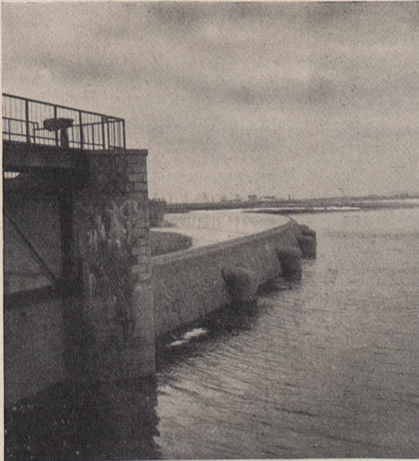
Stausee Ottmachau, am Hochwasserüberfall
