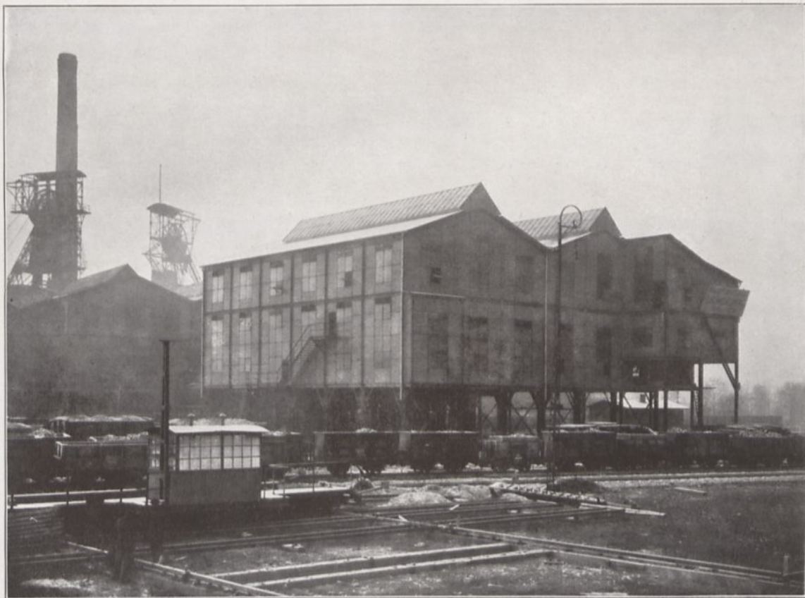
Bild 1 Separation und Schiebebühne Ludwigsglückgrube b. Vorfiswerk
