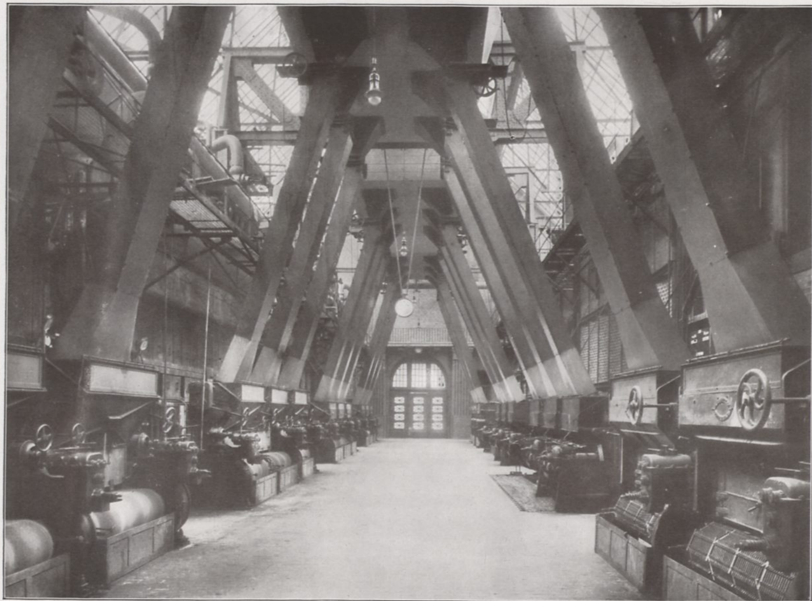
Elektrizitätswerk Zaborze. Moderne Kesselanlage
