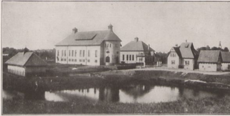
Städtisches Wasserwerk in Laband (Blick von der Bahn aus)
