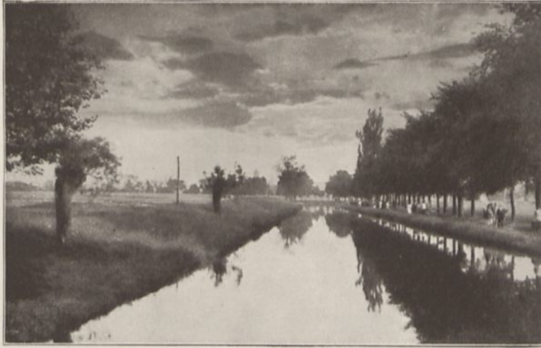
Der Klodnitzkanal (Blickrichtung auf die Stadt von Schleuse 17 aus)
