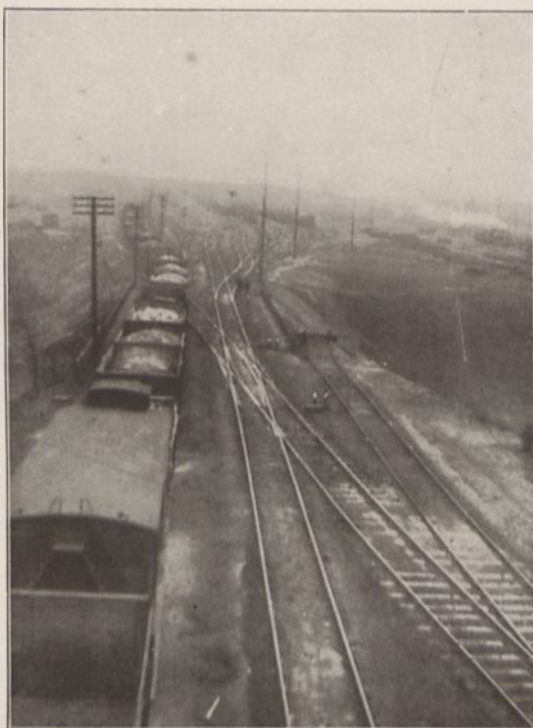
Abb. 1. Blick vom Stellwerk Ein Zug wird über den Ablaufberg gedrückt (im Hintergrunde die Gruppe der Einfahrgleise)
