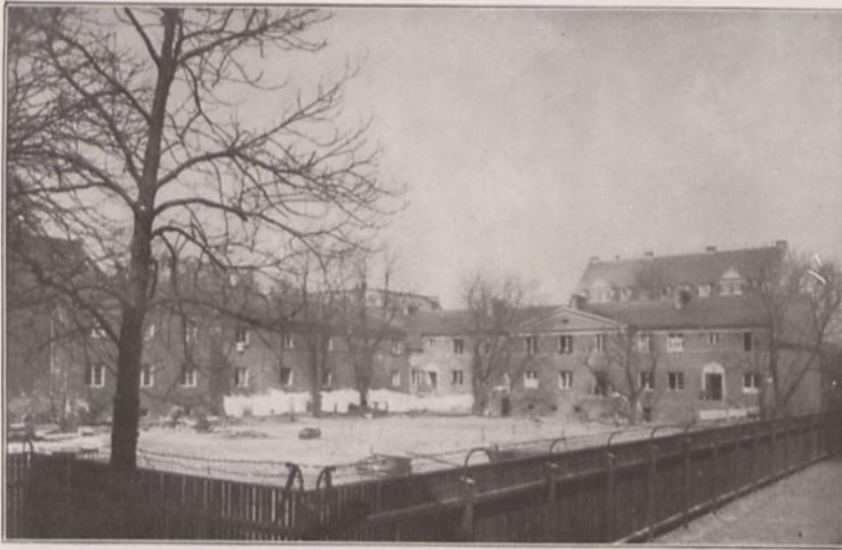
Abb. 18. Umbau der Ställe der alten Ulanenkaserne zu Flüchtlingswohnungen (Hofansicht)
