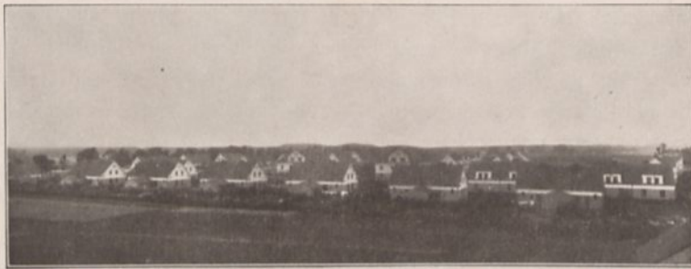
Wohnhausfiedelung des Bauvereins „Nord“ (an der Tarnowitzer Chaussee)
