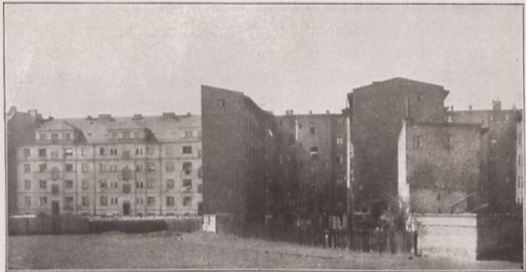
Abb. 3. Links städtische Wohnhäuser an der Löschstraße (Hofansicht), rechts daneben Mietkasernen der Vorkriegszeit
