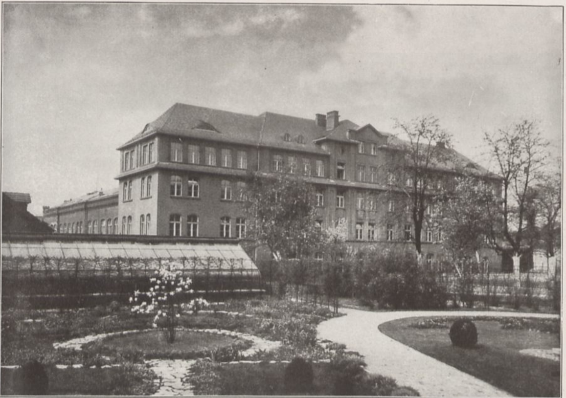
Das Hauptverwaltungsgebäude der Gesellschaft in Gleiwitz (Rückansicht)
