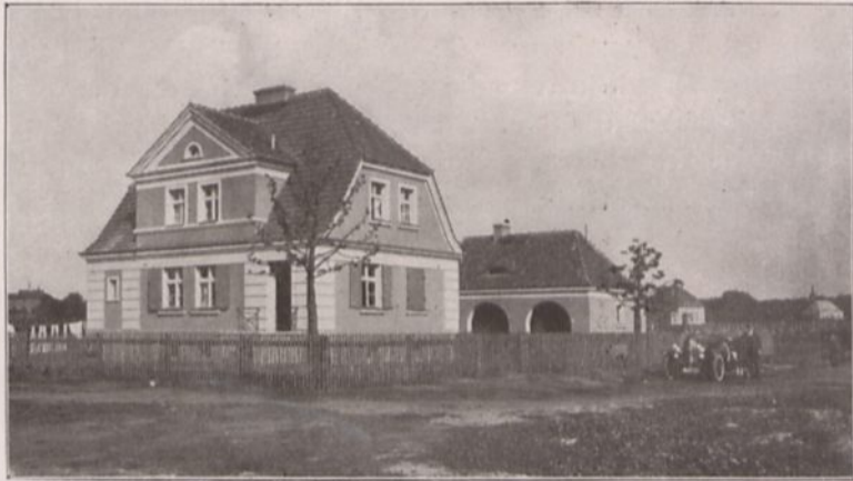
Abb. 8. Neue Stadtgärtnerei. Gärtner-Wohnhaus und Wirtschaftsgebäude
