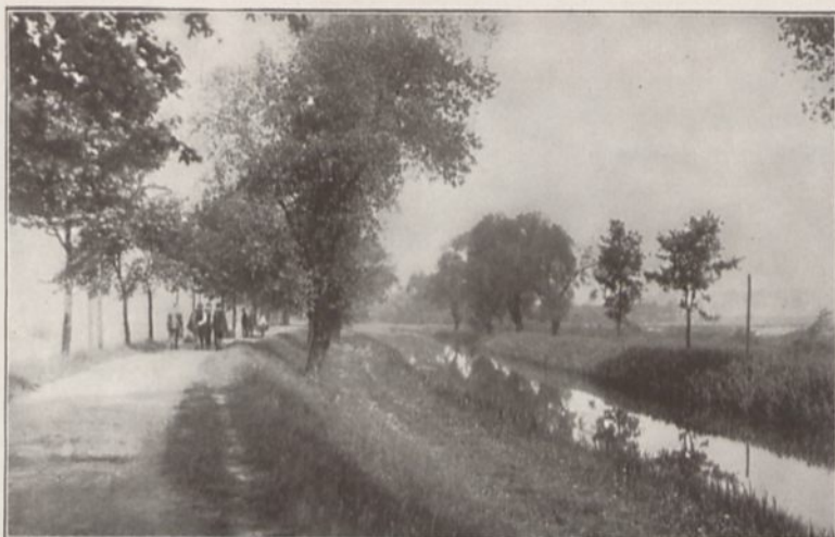
Promenadenweg am Klodnikkanal (Blickrichtung nach Schleuse 16, Pšahyšowka)
