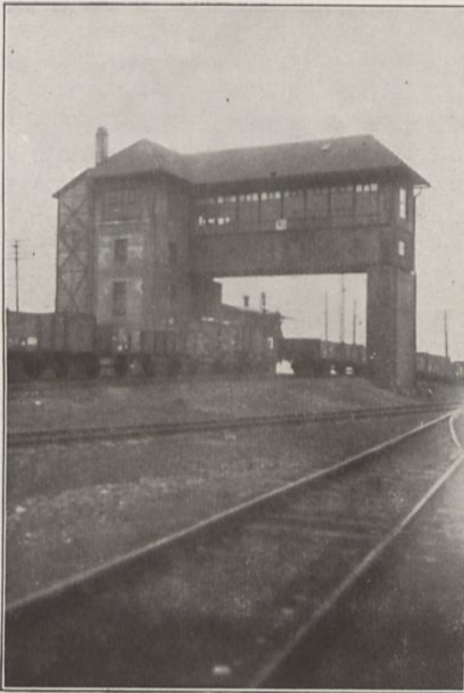
Abb. 2. Das über dem Scheitelpunkt des Ablauf- berges stehende Stellwerk 3 losgekuppelte Wagen rollen eben vom Berge ab
