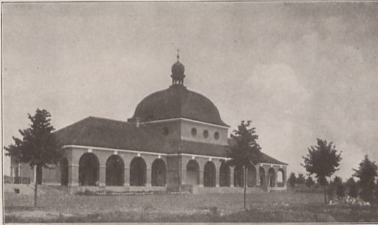
Abb. 8. Leichenhalle mit Einsegnungsraum auf dem Hauptfriedhofe
