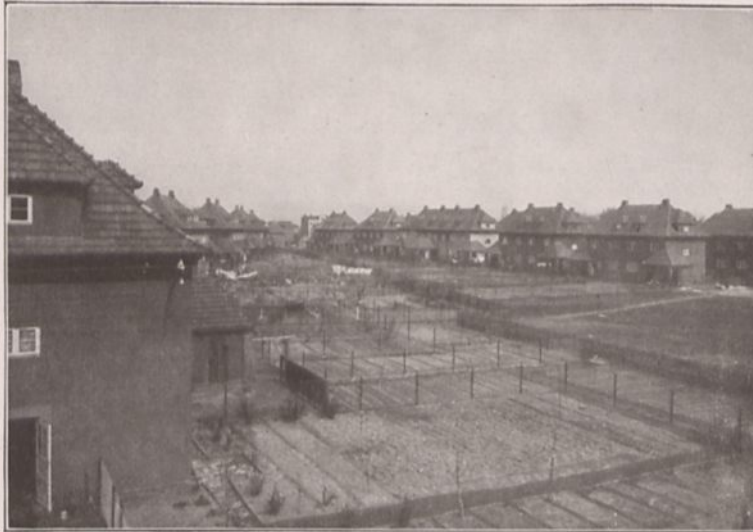
Abb. 11. Wohnhausiedelung der „Gagfab“ an der Kieferstädter Chaussee
