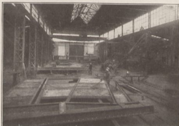
Teilansicht: Abt. Eisenkonstruktion
