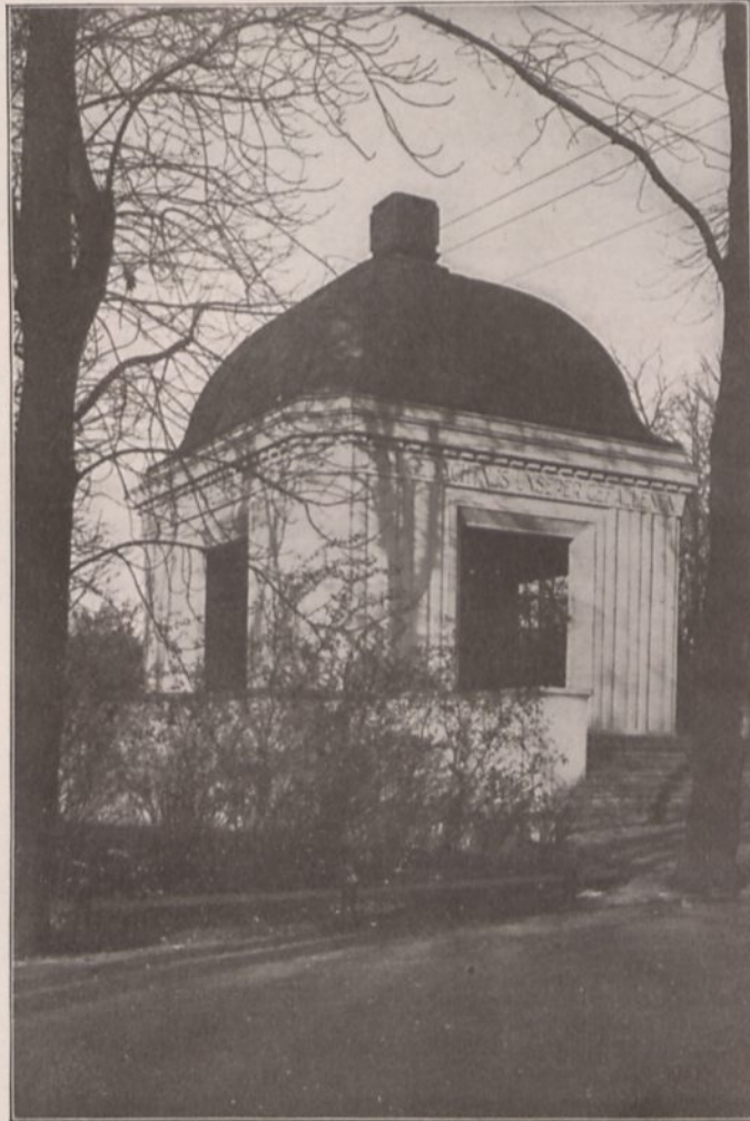
Abb. 5. Denkmal der Gefallenen des Inf.-Regts. „Reith“ im Stadtpark
