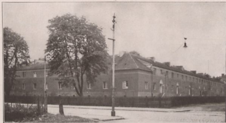
Abb. 17. Umbau der Ställe der alten Ulanenkaserne zu Flüchtlingswohnungen (Straßenansicht)
