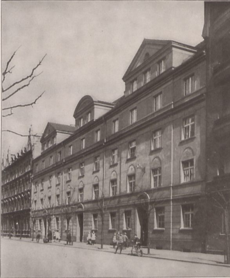
Abb. 15. Städtische Wohnhäuser an der Löschstraße
