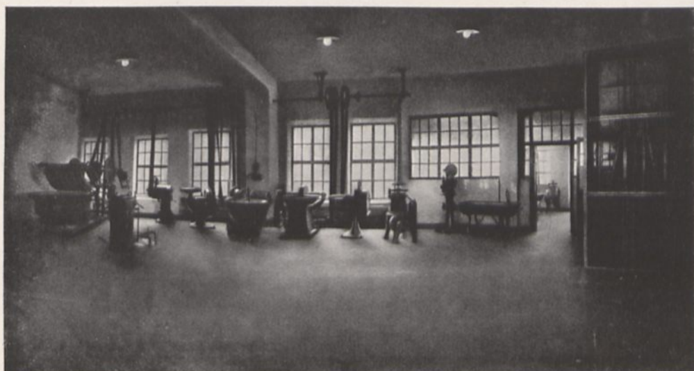
Maschinenraum der Rohwurstabteilung
