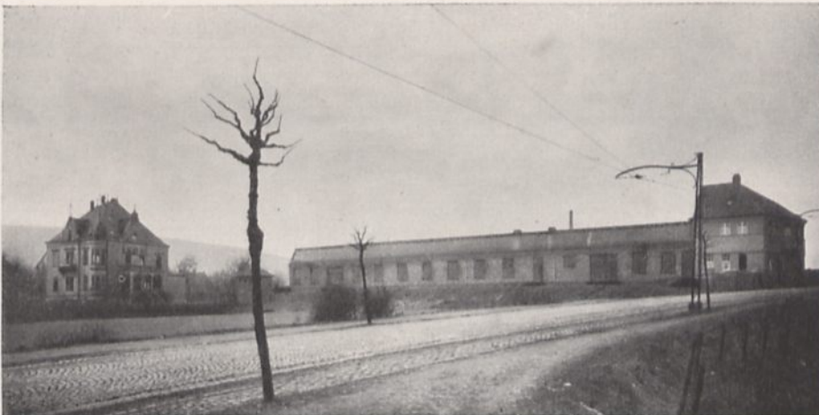
Werk Vorhalle i. W.
