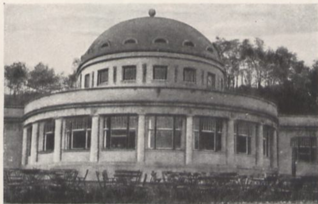
Parkhaus Hagen i. W.
