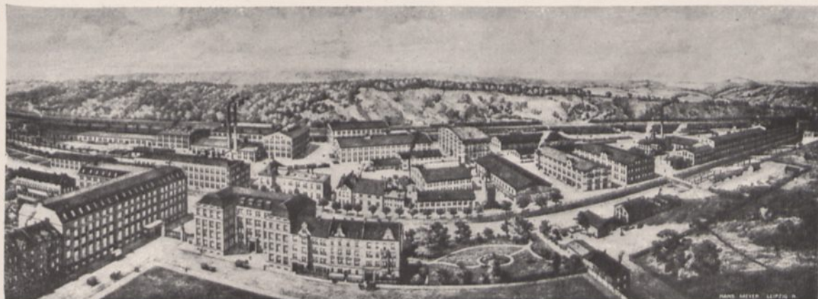
Gesamtübersicht über die Fabrik der Accumulatoren-Fabrik Aktiengesellschaft in Hagen i. W.
