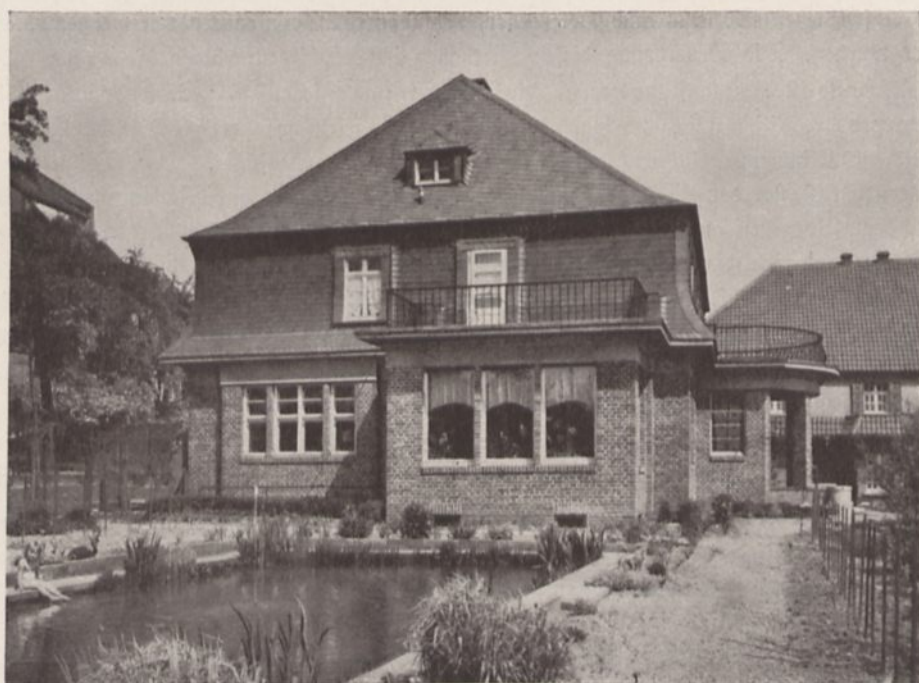
Wohnhaus Arch. Ernst Kohlhage (Gartenansicht)
