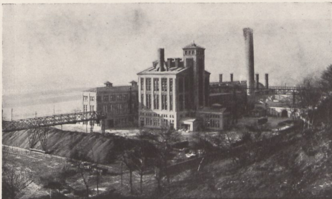
Hochdruck-Kraftwerk „Eunowert“, Herdecke
