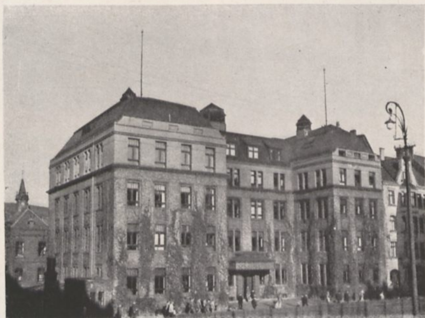
Verwaltungsgebäude der Accumulatoren-Fabrik Aktiengesellschaft in Hagen i. W.
