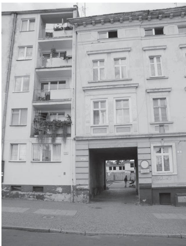
Ryc. 63. Sobótka. Styk nowego i starego budynku (fot. autora)
