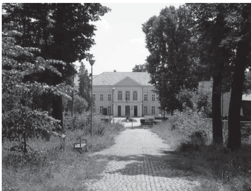
Ryc. 30. Brzeg Dolny. Pałac Hoymów (fot. autora)
