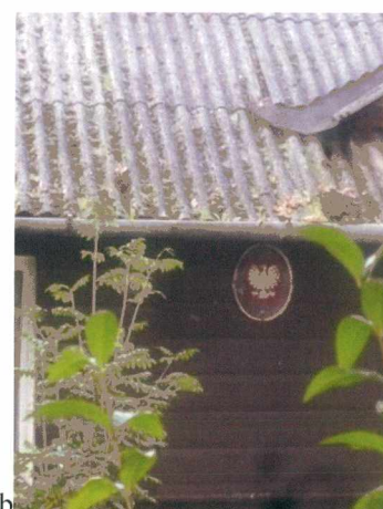
Ryc. 177. Szkoła powszechna w Hucie Tarnawackiej (powiat tomaszowski), a) elewacja od strony ogrodu, b) fragment szalowania drewnianej elewacji i zmienione poszycie dachu, stan obecny (fot. autor, sierpień 2009).
