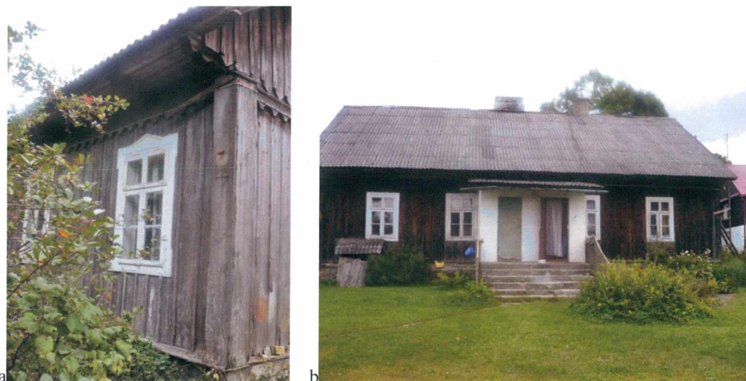
Ryc. 178. Szkoła powszechna w Majdanie Sopockim I (powiat tomaszowski), a) element drewnianego szalunku budynku, b) elewacja szkoły od strony podwórza, stan obecny (fot. autor, sierpień 2010).
