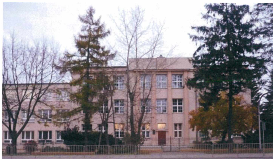
Ryc. 92. Szkoła powszechna 7 – klasowa w Jastkowie, projektu B. Kelles – Krauzego (fot. autor, październik 2009) – stan obecny.
