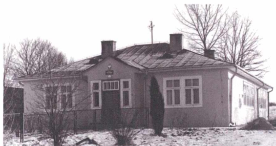
Ryc. 100. Szkoła powszechna w Wandalinie w 1938, za: http://spwandalin.pl/wandalin.html , 6. 04. 2009.
