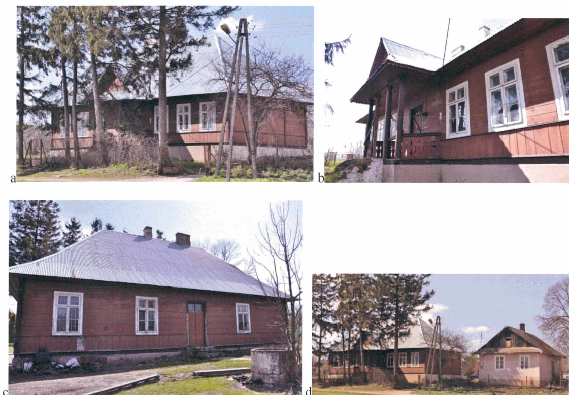
Ryc. 183. Szkoła powszechna w Moniatyczach, stan obecny (fot. autor, 2011), a, b) widok elewacji frontowej, c) widok elewacji od strony podwórza, d) widok dawnego domu dla nauczyciela.
