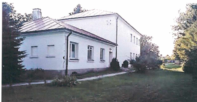
Ryc. 54. Szkoła powszechna w Leszczanach - stan obecny (fot. autor, czerwiec 2010).
