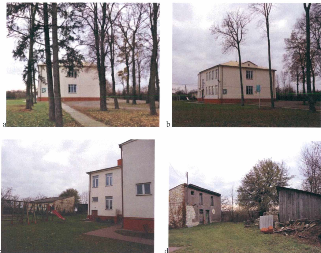
Ryc. 110. Szkoła powszechna w Komaszycach ( Starych) - stan obecny (fot. autor, 2012), a) widok od strony drogi, b) widok ogólny szkoły, c) elewacja od strony podwórza gospodarczego, d) pozostałości dawnych budynków gospodarczych.
