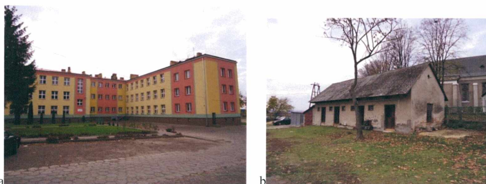
Ryc. 198. a) Szkoła powszechna w Annopolu, b) historyczne pozostałości budynków gospodarczych przy szkole w Annopolu (fot. E. Przesmycka, listopad 2012).
