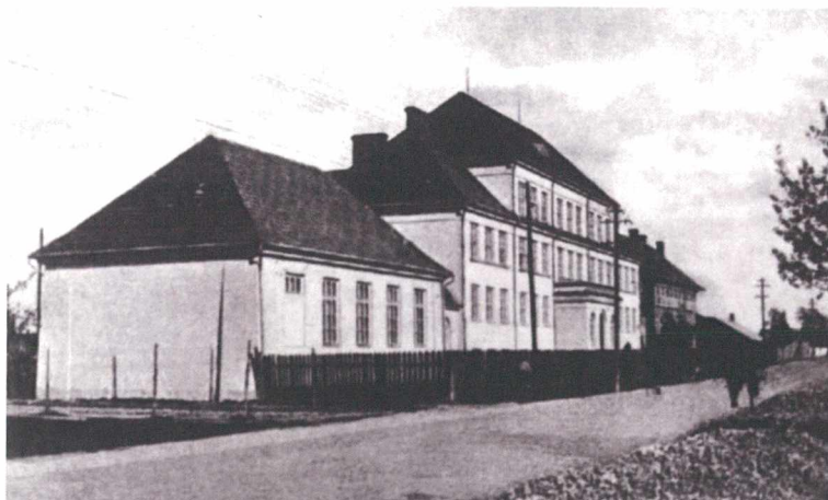
Ryc. 26. Szkoła powszechna w Międzyrzeczu Podlaskim, za: E. Przesmycka, Lubelszczyzna. Wielokulturowość osadnictwa, budownictwa i architektury , Lublin 2008, s. 162.
