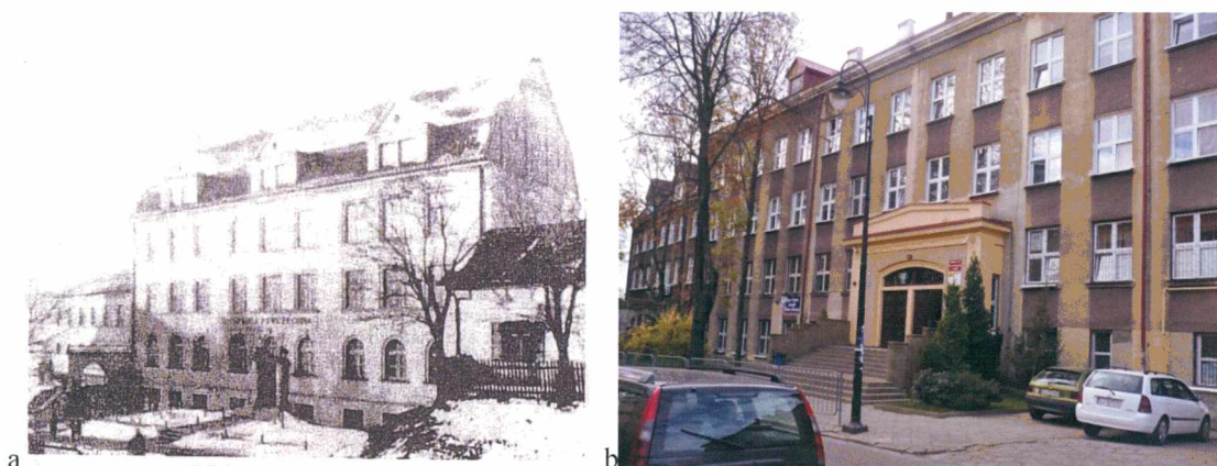
Ryc. 192. Szkoła powszechna w Lublinie na Czwartku a) fasada frontowa połowa lat 30 - tych, za: Monografia... , op. cit., s. 149, b) obecna fasada frontowa (fot. autor, październik 2008).
