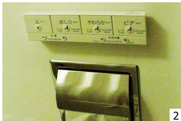
Tablica 11. Uniwersalny dostęp w przestrzeniach ogólnodostępnych hoteli: 1) winda z rozkładanym siedziskiem i przyciskami oznaczonymi kolorami oraz pismem Braille'a w Yasmin, Praga (Czechy), 2) przyciski do obsługi urządzeń sanitarnych z piktogramami i z Braille'em w Ueno First City Hotel, Tokio (Japonia), 3) umywalki i toaletka do obsługi w pozycji stojącej i siedzącej w sanitariatach w Creta Maris Beach Resort, Hersonissos (Grecja), 4) toaletka dostępna dla osoby na wózku w Imperial Hotel w Tokio (Japonia) 5) półtransparentne drzwi szklane w Hotelu New York, Rotterdam (Holandia), 6) drzwi szklane z piktogramem i poziomymi pasami w Hotelu Cordoba Centro, Kordoba (Hiszpania). [Fot. J.J.]
