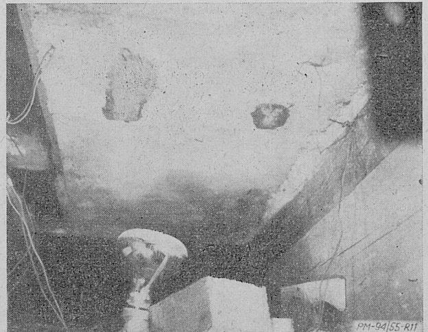
Rys. 11. Badanie naprężeń w elementach mostu ze sprężonego betonu kablowego.
