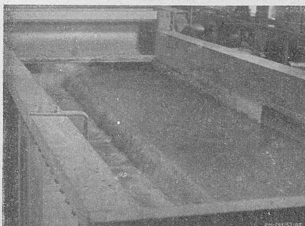
Rys. 5. Przewal odprowadzający nadmiar wody.
