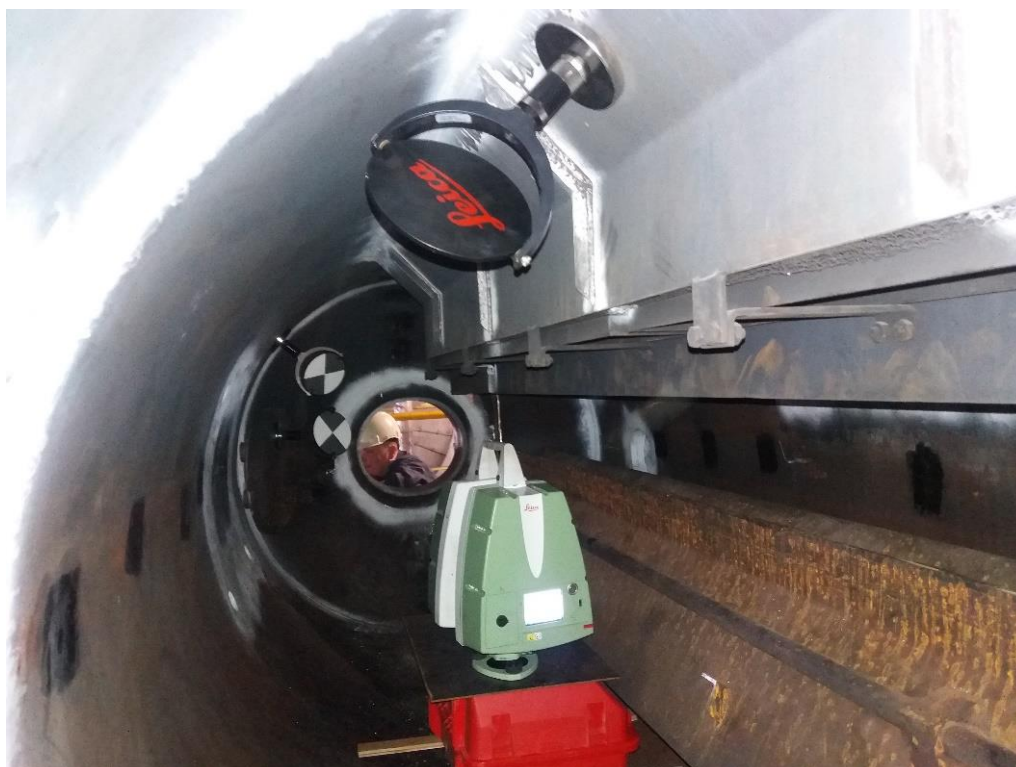
Rys. 3. Imperfekcje występujące na wewnętrznej stronie płaszcza walczaka- obszar łączenia króćca rury opadowej z płaszczem walczaka
