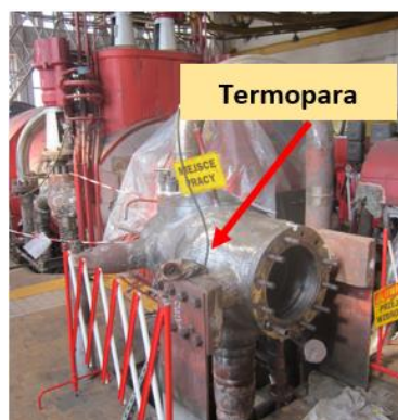
Rys. 6. Widok instalacji czujnika temperaturowego na strukturze zaworu
