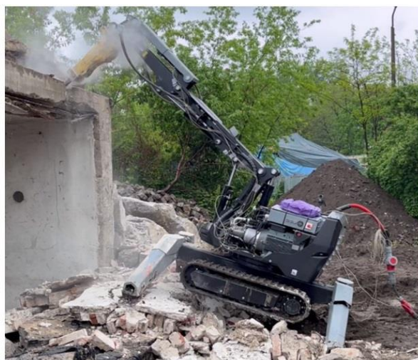
Rys. 10. Robot wyburzeniowy ARE 2.0 wyposażony w system pomiarowy do kalibracji laboratoryjnej oraz robot w terenie podczas prac wyburzeniowych
