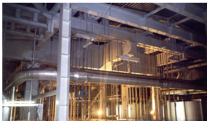
Rys. 10. Zawieszenie komory paleniskowej bloku energetycznego
