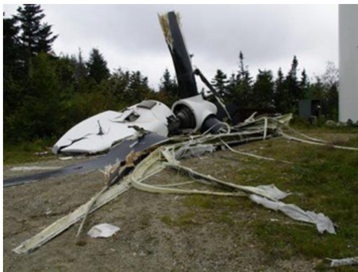
Rys. 6. Zawalenie się turbiny wiatrowej z powodu awarii łopat [3]
