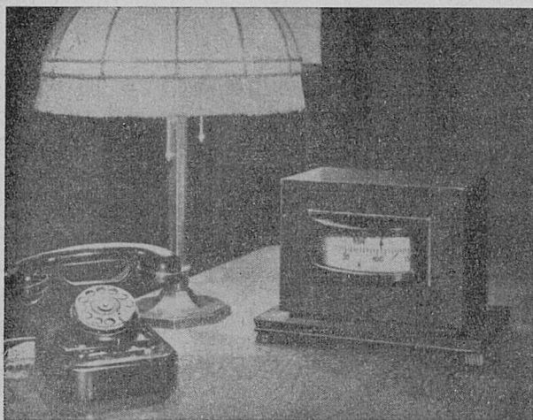
Rys. 26. Telemetryczny przyrząd odbiorczy w biurze rozrządcy
