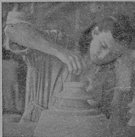
Formowanie izolatora stojącego (15 kV)
