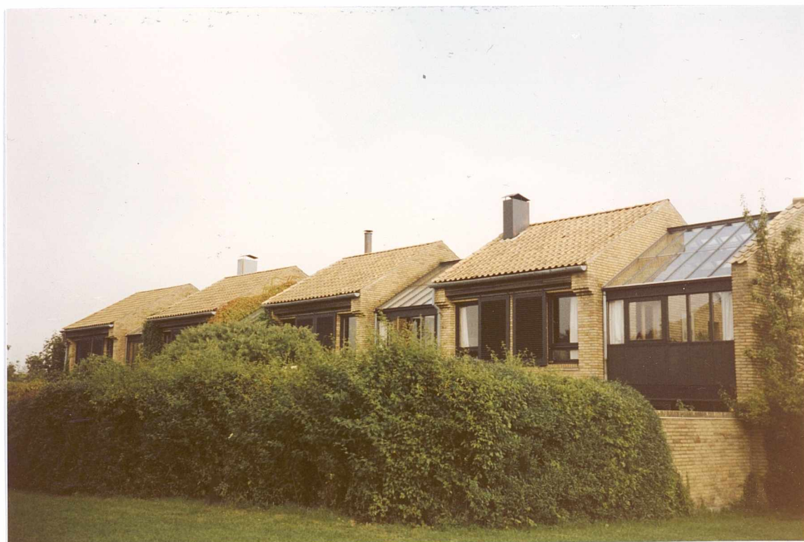
Rys.5.30. Jasne przeszklone łączniki-zielona izba między domami o ceglanych murach nadają swoisty wyraz całej kompozycji. Osiedle Gasschaven, Holte, Dania [fot. własna]
