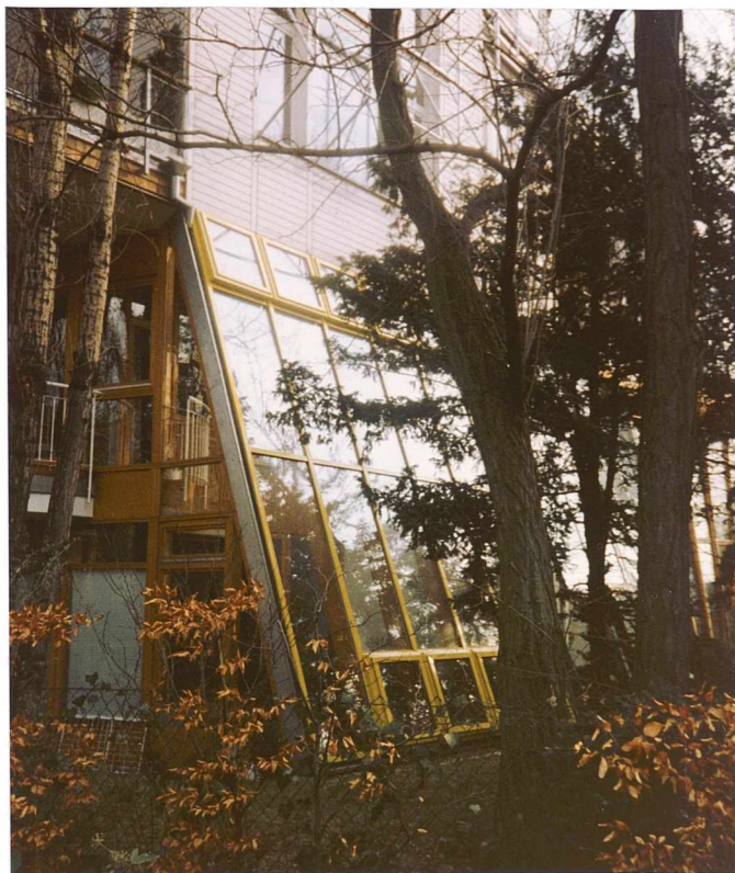
Rys.5.34. Dwukondygnacyjna zielona izba, Berlin - Tiergarten [fot. własna]
