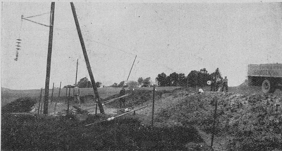
Rys. 4. Podciąganie przewodu po zdjęciu uziemienia.
