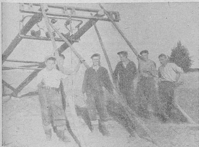
Rys. 16. Ustawianie bramki stacji
