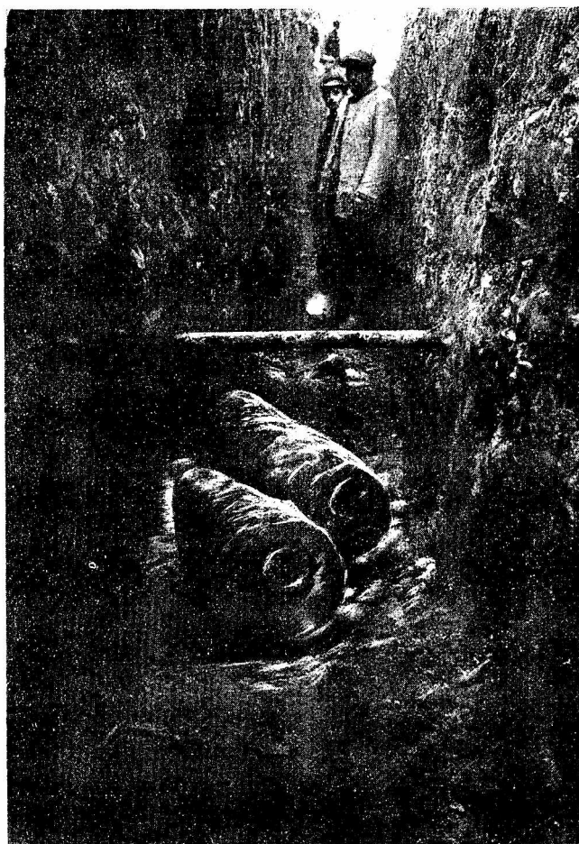
Rys. 3 — Trzy pokolenia rur wodociągowych w Lublinie.
