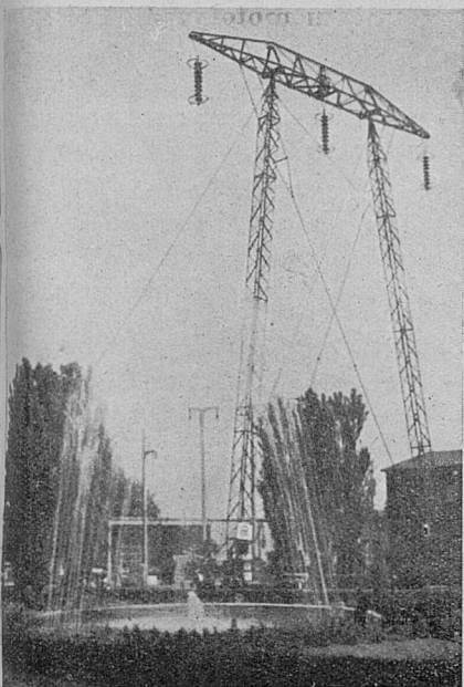
Wodotrysk napędzany elektropompą na tle słupa linii o napięciu 150000 woltów.
