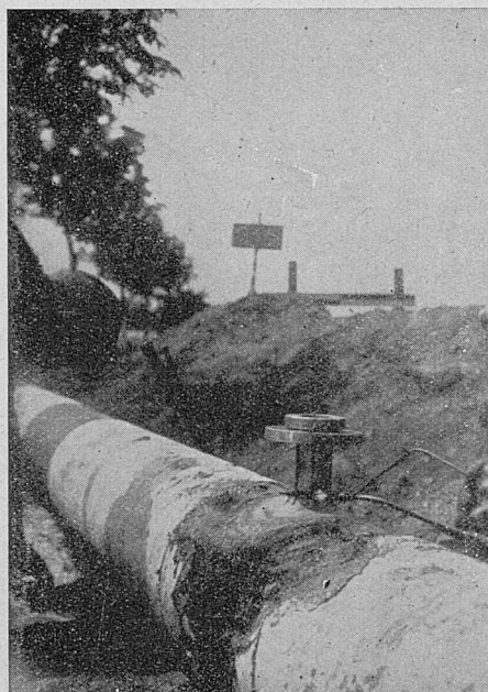
Rys. 3. Spawanie króćca przy budowie rurociągu.
