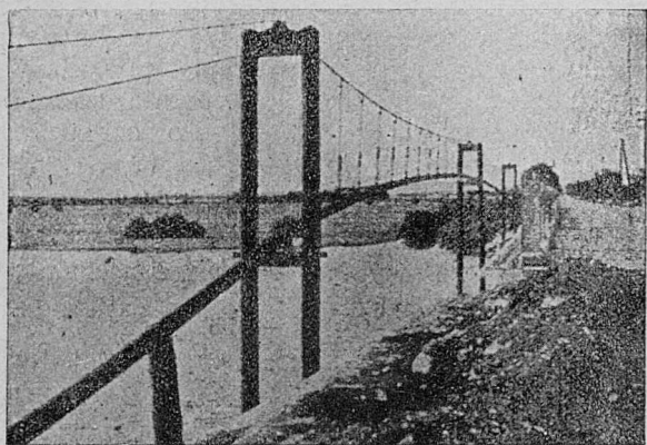
Rys. 5. Spawany gazociąg wysokopięny.
