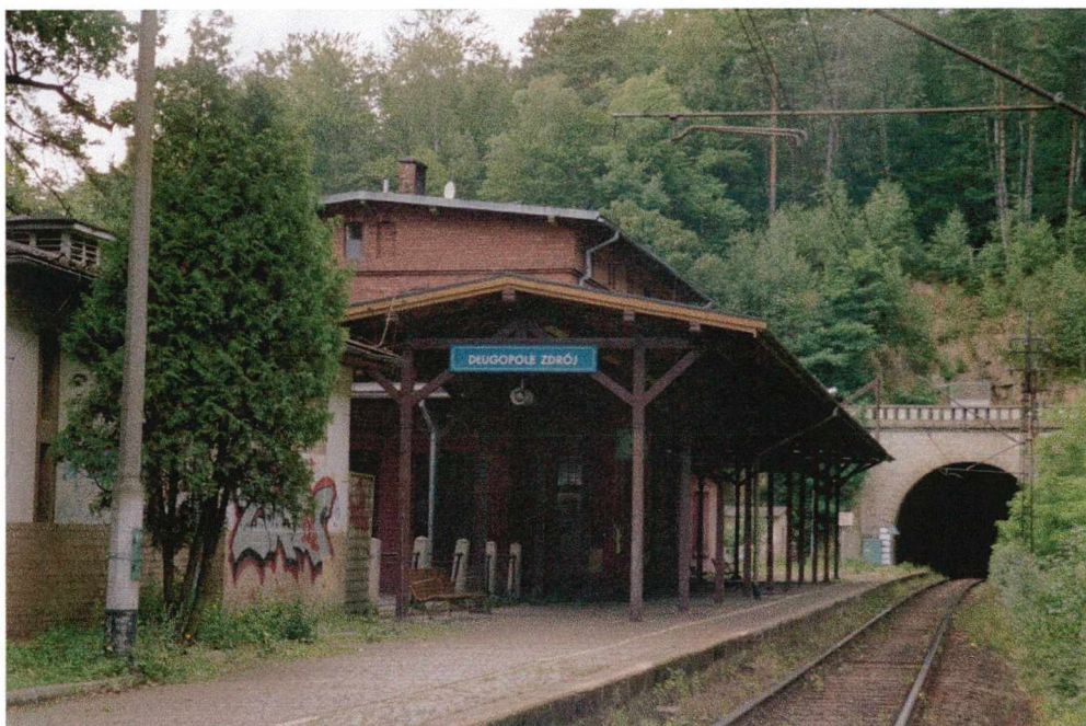
Fot. 62 Długopole Zdrój. Widok na wylot z tunelu, tuż przy peronie. Panującą wokół Ciszę rzadko przerywa przybycie pociągu. Dworzec czynny.
