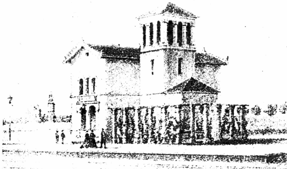
Ryc.74 Jakubowice budynek dworcowy zbudowany w duchu klasycyzmu XIX - wiecznego. W pobliżu wzniesiony został dworzec w 1904r. Świdnica Kraszowice.
