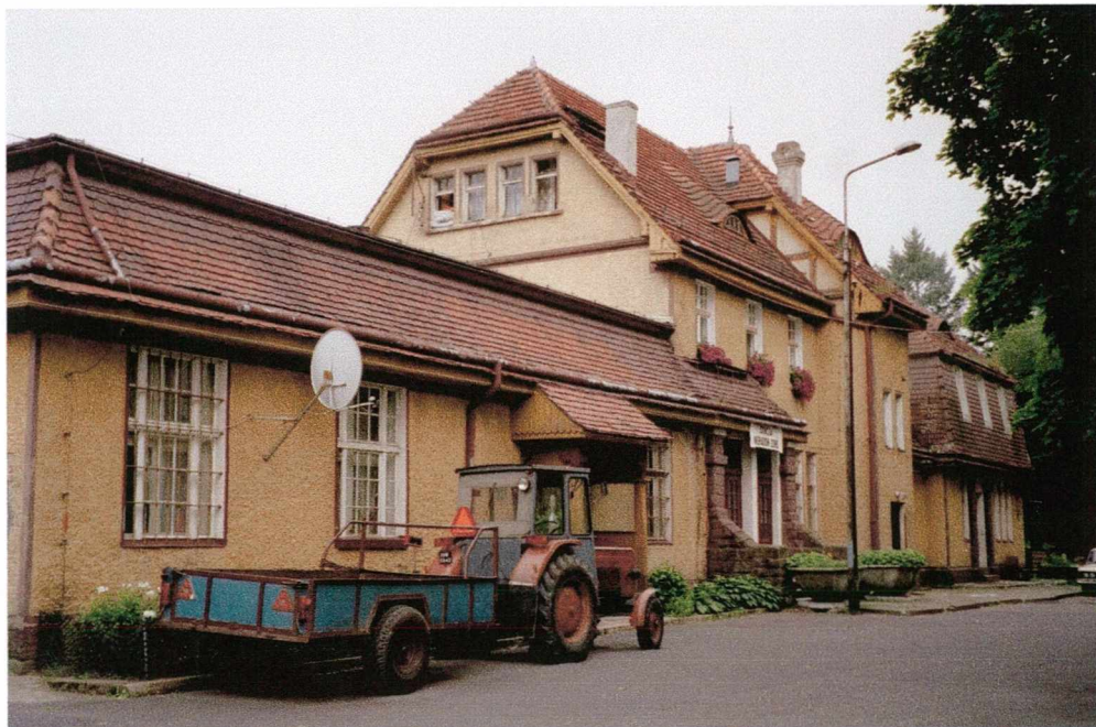
Fot. 52 Świeradów Zdrój. Nieczynny dworzec dawnej prywatnej kolejki Schafgotschów. Mansardowy dach należy do rzadko spotykanych zadaszeń takich budynków.
