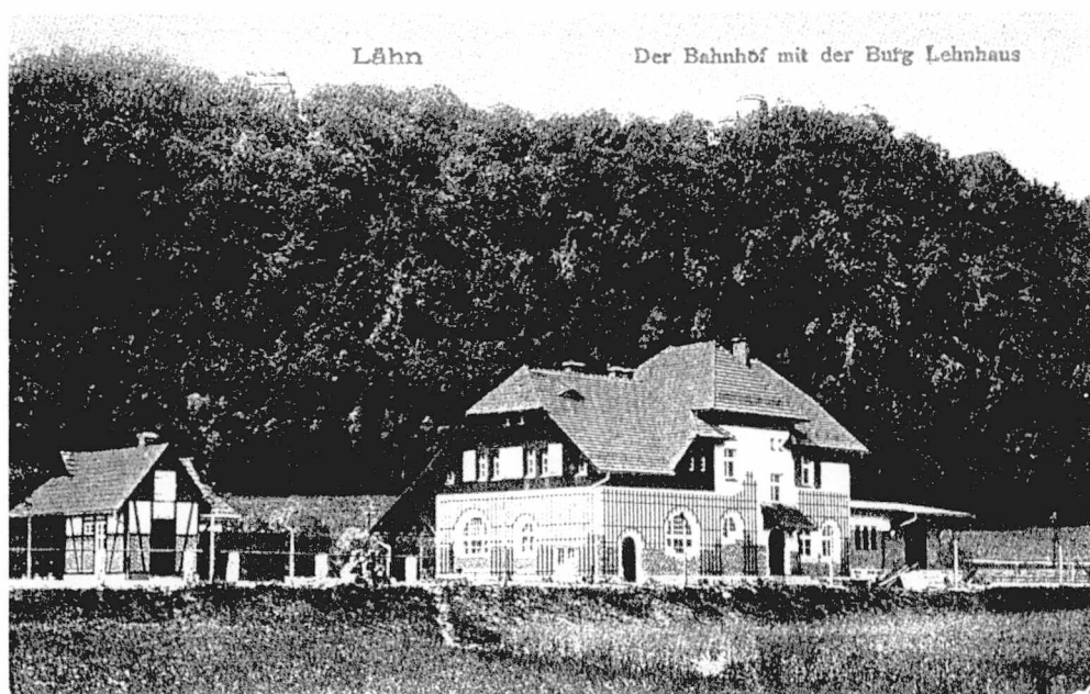
Ryc.33 Wleń na trasie Jelenia Góra - Lwówek Śl. Architektura dworca czerpie wzorce z miejscowych tradycji w budownictwie.
