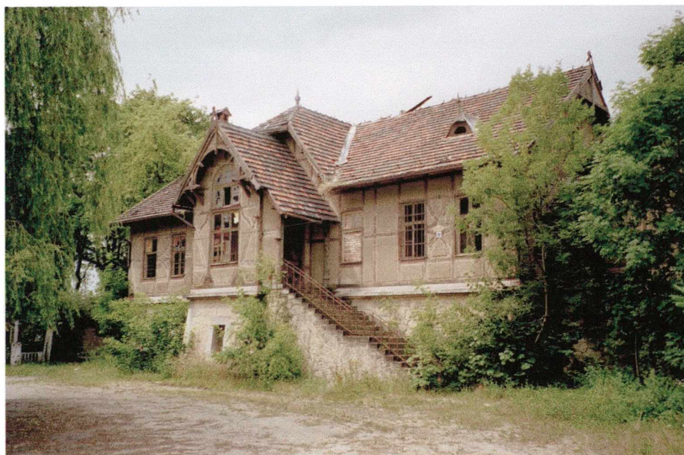
Fot. 6 Strzegom Grabina. Dworzec na linii Strzegom - Rożtoka - Bolków z 1890r. Widok od strony podjazdu na opuszczony budynek. Stylistyka, detal, proporcje analogiczne do rozwiązania z Marcinowic. Różnica poziomów między podjazdem i peronami wymusiła wprowadzenie schodów, co zindywidualizowało charakter obiektu.
