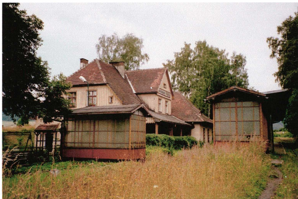
Fot. 78 Ludwikowice Kłodzkie. Widok do strony peronu. Widoczne zadaszenie przejść podziemnych wykonano w stalowej konstrukcji. Część magazynowa zespolona z głównym budynkiem i ustawiona prostopadle do osi torów. Wiata przylega do Dworca i ma zmieniony w stosunku do jego dachu kąt nachylenia połaci.
