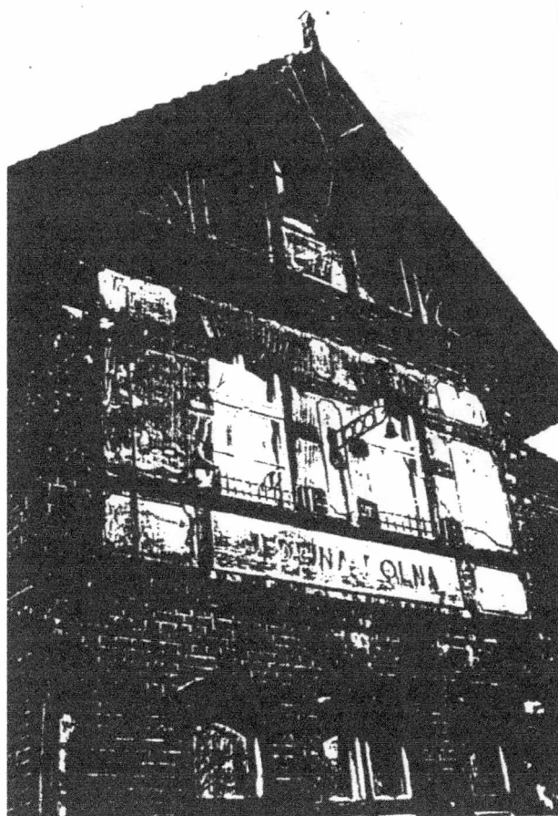
Ryc. 85 Jedlina Dolna. Szachulcowa konstrukcja szczytu. Uwagę zwraca zachowana lampa.
