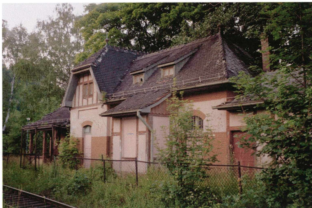
Fot. 9 i 10 Jedlina Górna. Widok od strony peronów na nieczynny już dworzec. Zróżnicowany dach z naczółkiem w części centralnej nadaje tej architekturze indywidualny charakter. Widoczną wiatę, podpierając nietypowe masywne słupy.
