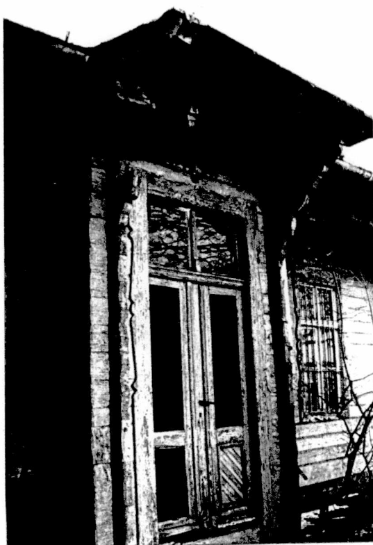
Ryc.93 Leszczyniec. Przedsiónek dworca: konstrukcja i detal. Widok z zewnątrz. Stan aktualny.
