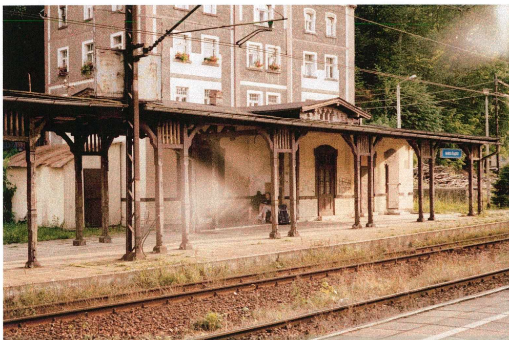
Fot. 99 Bardo Śląskie Przylęk. Drewniany szkielet budynków, oraz konstrukcja wiat to cechy charakterystyczne stacji.
