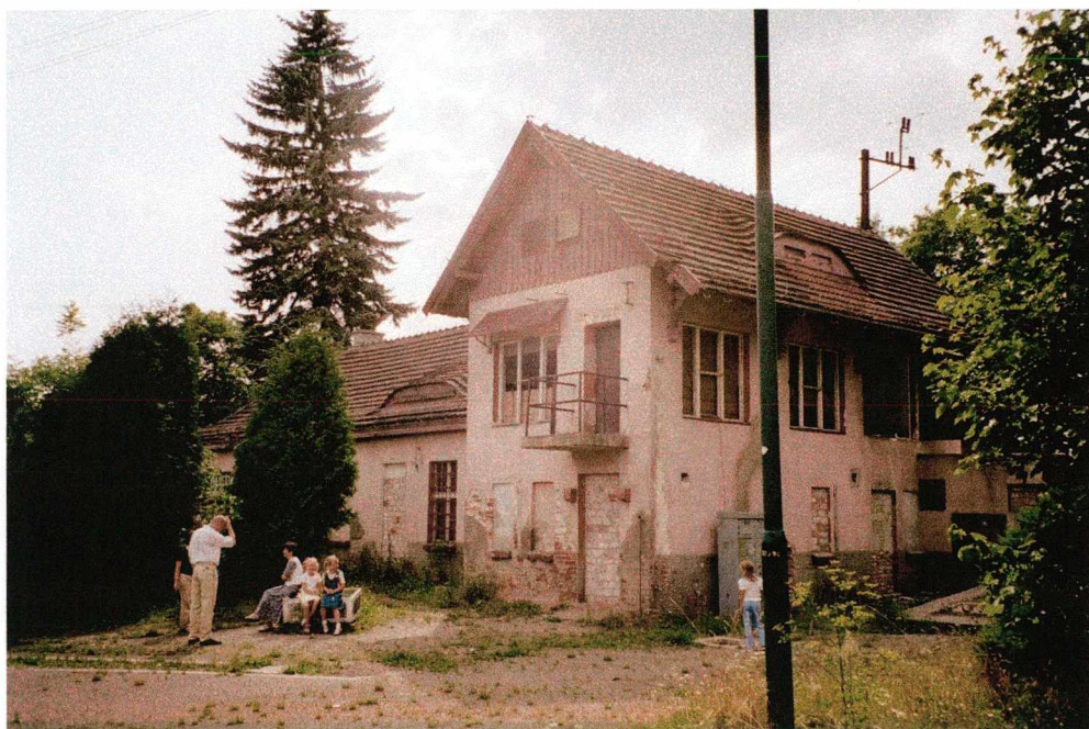
Fot. 97 Krosnowice. Widok na dworzec od strony linii do Stronia Śl. Obiekt opuszczony.
