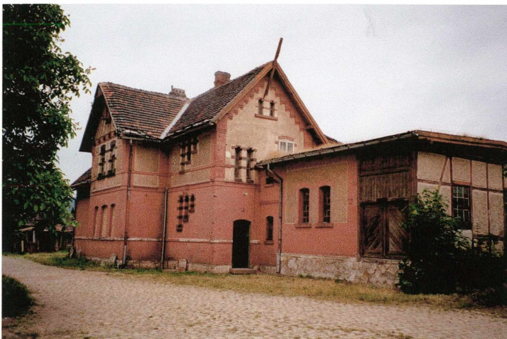
Fot. 31 Stare Rakowice. Dworzec z 1899r. na trasie Marciszów - Bolków wzniesiony w tym samym stylu co obiekt w Bolkowie, Jugowicach, itp. Nieczynny obiekt adoptowano na cele mieszkalne.
