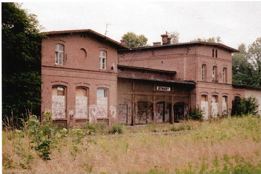
Fot. 90 Kowary. Widok od strony peronu na dworzec. Uwagę zwraca ozdobna snycerka wiaty zespolonej z główną bryłą, oraz znaczne podobieństwo w kształtowaniu fasad np. z dworcem w Mirsku.
