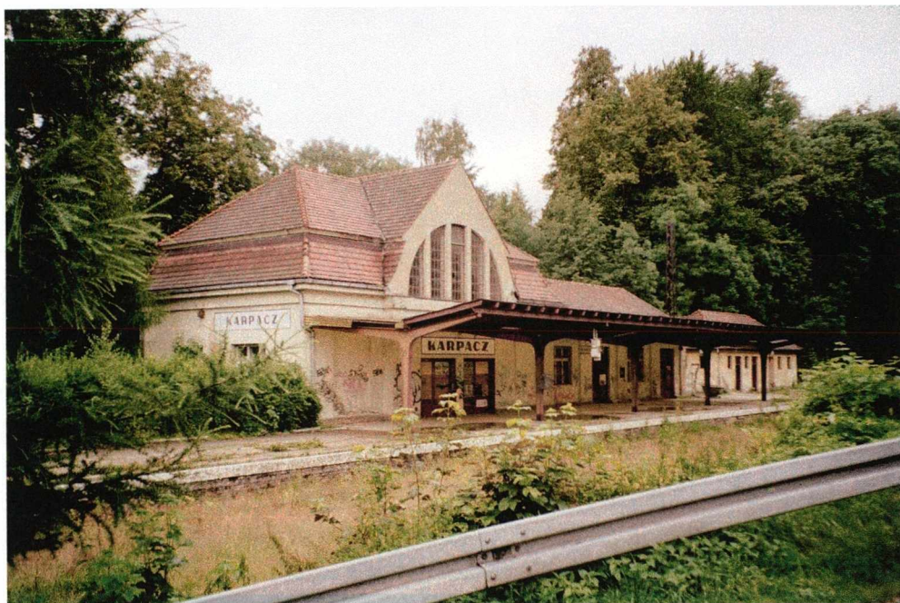
Fot. 89 Karpacz. Widok od strony peronu. Wiata przylega do budynku. Z tyłu widoczne szalety.
