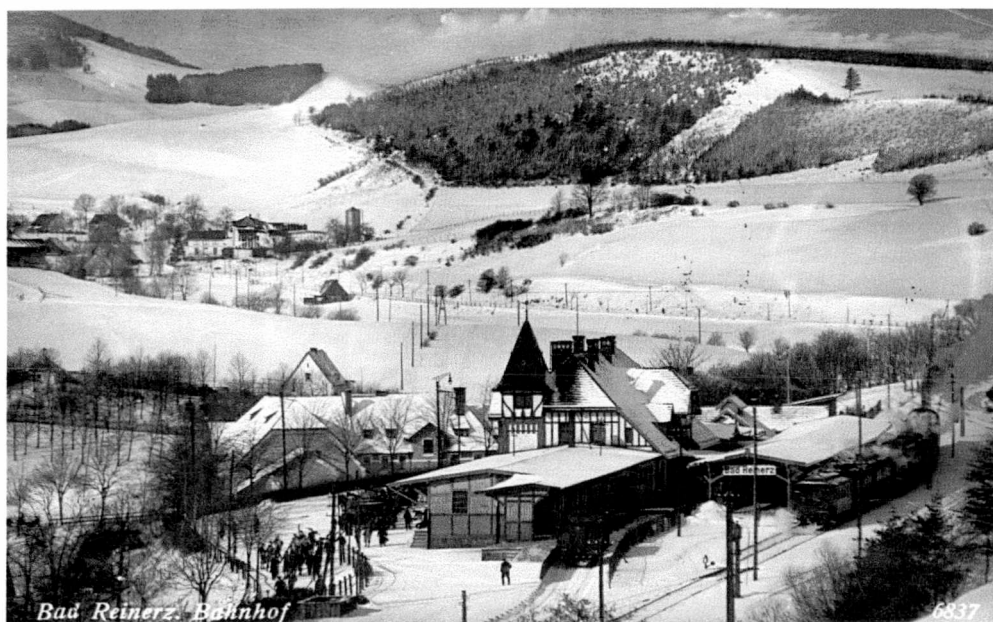
Ryc.39 Duszniki Zdrój w zimowej szacie w 1930r. Architektura dworca nawiązuje do zabudowy pensjonatowej.
