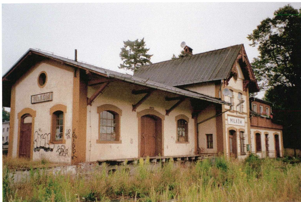
Fot. 37 Miłków. Widok od strony peronu. Mocno nadwieszony dach magazynu nad rampą wspiera konstrukcja drewniana.
