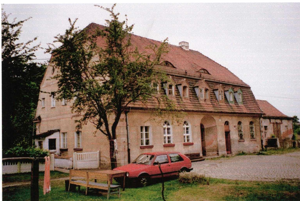
Fot. 82 Roztoka. Dworzec kolejowy z 1890r. na trasie Strzegom - Bolków. Mansardowy dach należy do rzadkich rozwiązań zadaszenia obiektów dworcowych.
