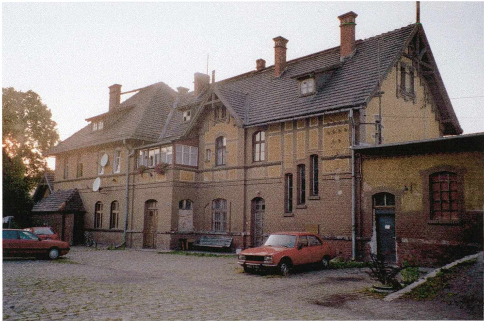
Fot. 23 Głuszyca Górna. Czynny dworzec na linii Wałbrzych Kłodzko. Stację na uboczu miasta i powyżej niego wzniesiono ok. 1880r. Stację cechuje różnorodność detalu na elewacjach. Widok od podjazdu na częściowo zamieszkiwany obiekt.
