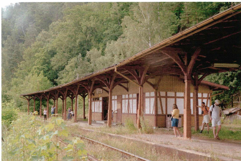
Fot. 79 Pilchowice Zaporą. Mały dworzec z 1906r., nad jeziorem Pilchowickim. Peron założony został na łuku, na specjalnej platformie nadwieszanej ok. 9m nad lustrem zbiornika wodnego.
