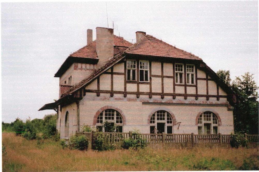
Fot. 85 Krobica. Elewacja od strony peronu. Widoczna konstrukcja stropu I piętra jest nieznacznie nadwieszona nad parterem.
