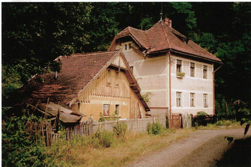
Fot. 80 Widok od strony peronu na budynek mieszkalny oraz gospodarczy, które należą do zespołu zabudowań stacyjnych.
