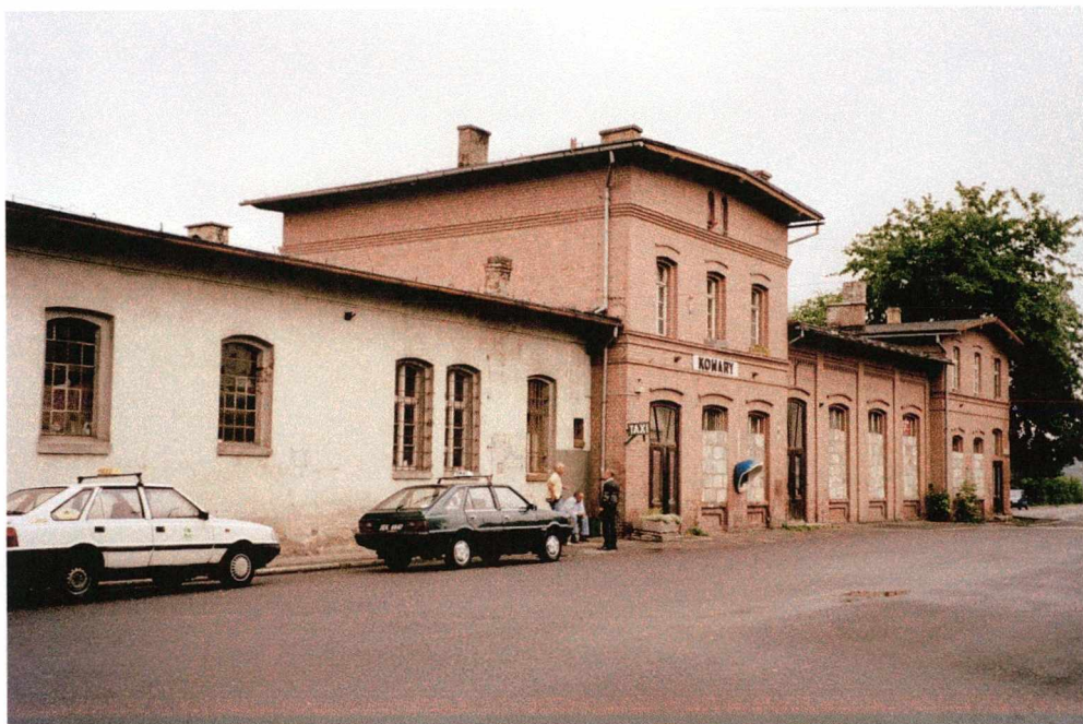
Fot. 91 Kowary. Drugi dworzec z 1910r. wzniesiono w konstrukcji murowej. Centralna część niższa. Szczyty flankujące front posiadają różne rozwiązania. Widok od strony podjazdu.
