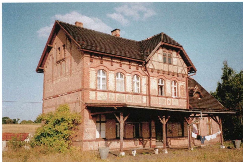
Fot. 18 Świdnica Kraszowice. Widok od strony peronu. Wiata peronowa przyległa do dworca. Kondygnacja poddasze użytkowego podkreślona jest konstrukcją stropu widoczną w elewacji.
