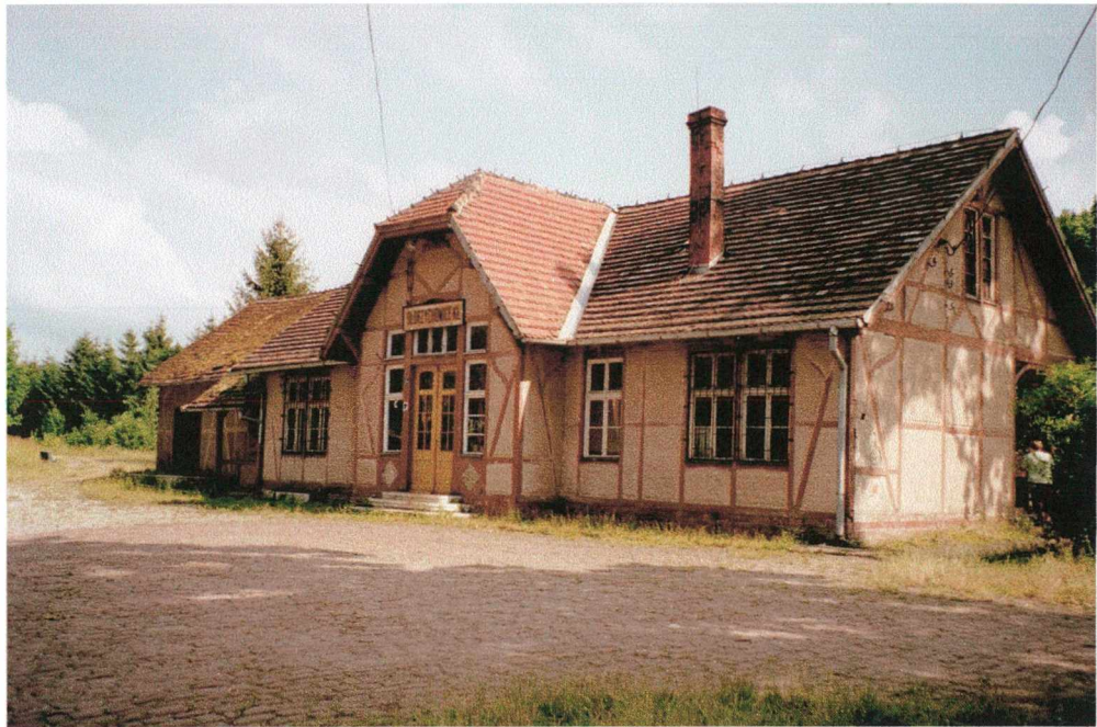
Fot. 13 Odrzychowice Kłodzkie. Detal skromniejszy niż w Żelaźnie. Nieczynny dworzec widoczny od strony podjazdu, stoi w otoczeniu innych zabudowań mieszkalnych i dla tego nie uległ zniszczeniu w takim stopniu jak inne opuszczone obiekty.
