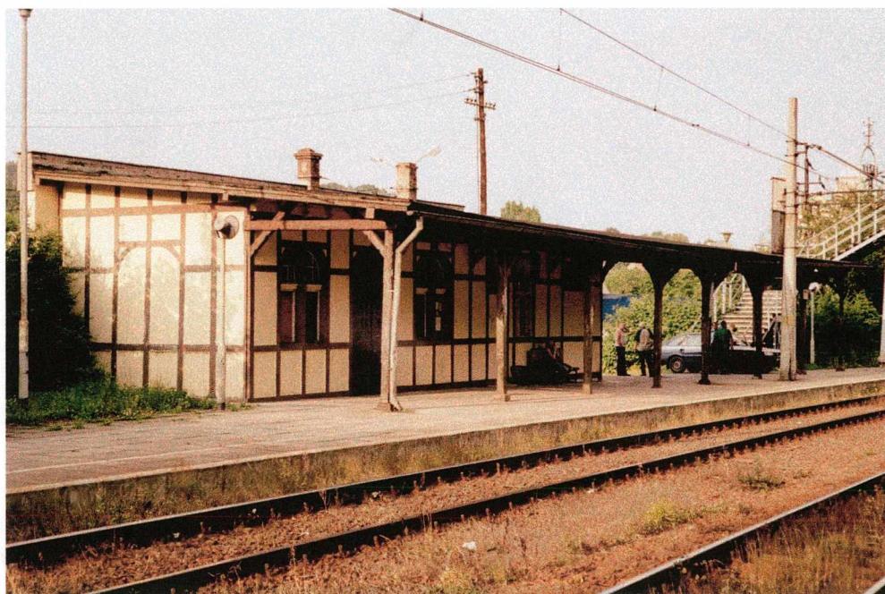
Fot. 98 Bardo Śląskie Przylék. Szachulcowa konstrukcja budynków, oraz konstrukcja Wiat decydują o charakterze stacji, który dobrze korespondował z otaczającym krajobrazem.
