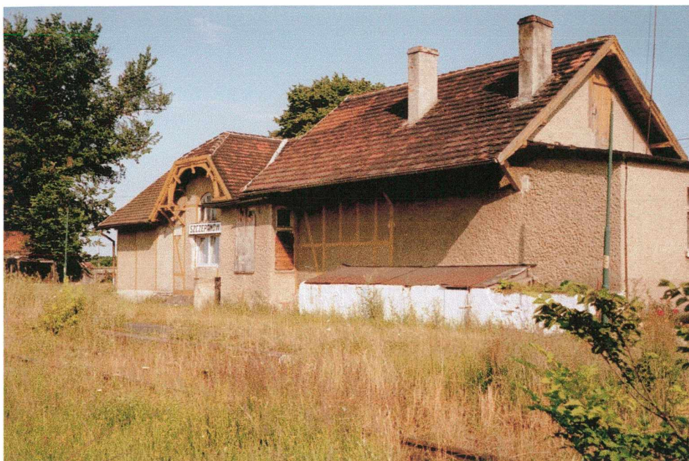
Fot. 1 Szczepanów. Stacja na linii Wrocław-Świdnica. Rok powstania 1898. Reprezentant najpopularniejszego układu funkcjonalno-przstrzennego dla małych dworców kolejowych na obszarze Sudetów i Pogórza Sudeckiego, z charakterystyczną częścią centralną krytą dachem naczółkowym. Widok od strony dawnego peronu.
