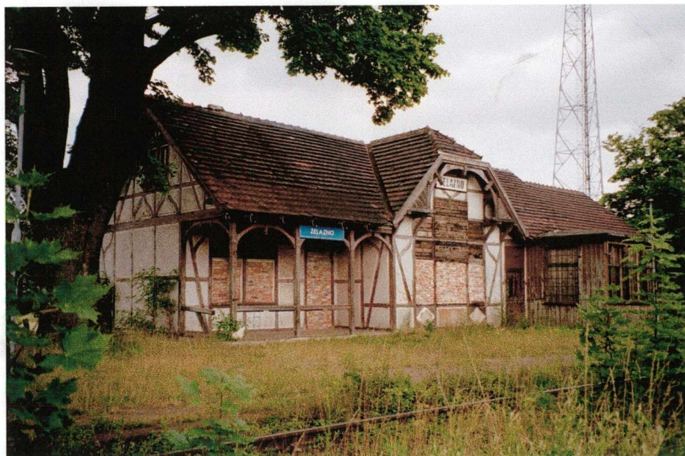
Fot. 12 Żelazno na trasie do Stronia Śląskiego. Charakterystyczny szachulcowy budynek dworca z 1897r. ma swoje liczne analogie na całym obszarze Sudetów. Widok od strony peronu. Na pierwszym planie wiata peronowa.
