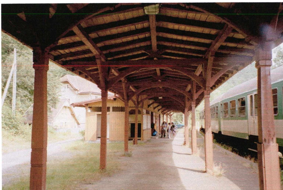
Fot. 81 Widok z peronu na konstrukcję zadaszenia i budynek czynnego dworca.
