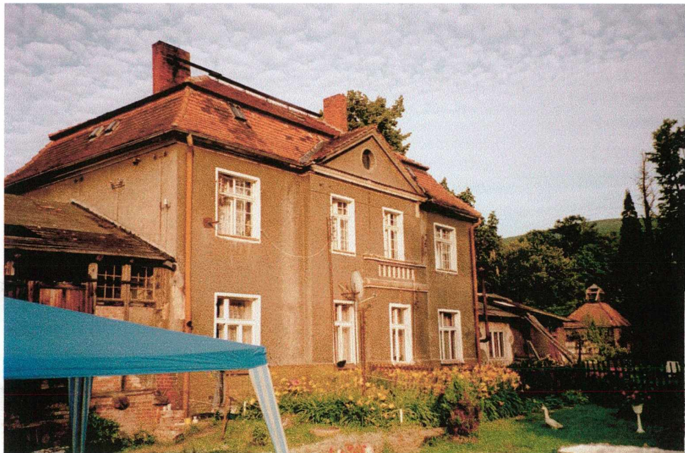
Fot. 76 Walim. Widok od strony peronu. Nietypowy dla dworców dach mansardowy nadaje budynkowi "miejskiego" charakteru. W głębi widoczny budynek szaletu.
