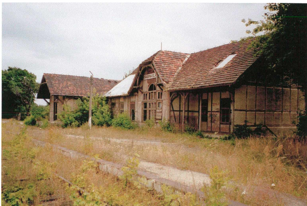
Fot. 7 Strzegom Grabina. Widok od peronów. Widoczny magazyn spedycji ustawiony poprzecznie do osi torowisk. Jest to rzadziej spotykane rozwiązanie. Na pierwszym planie zespolona z bryłą dworu – wieża
