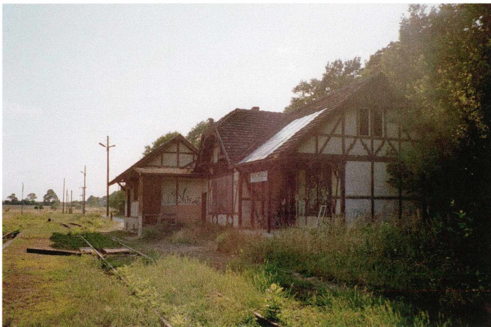
Fot. 4 Marcinowice Świdnickie. Widok od strony peronów. Charakterystyczna wiata podcieniona, zespolona z główną bryłą. Zwraca uwagę bogata sznycerka słupów i elementów konstrukcji wiaty, więźby oraz opasek okiennych.
