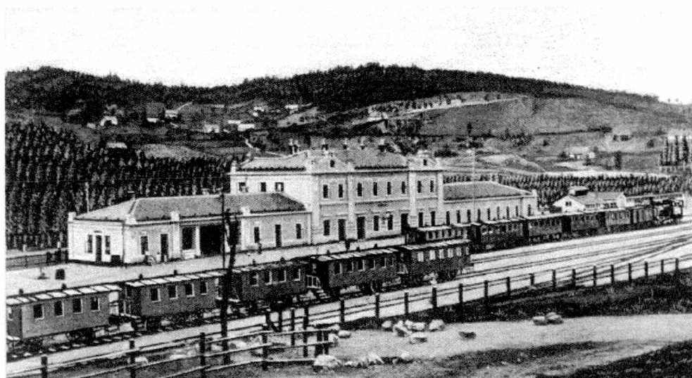
Ryc. 103 Grünthal. Widok ogólny dworca granicznego kolei pruskich na trasie Kolejki Izerskiej.
