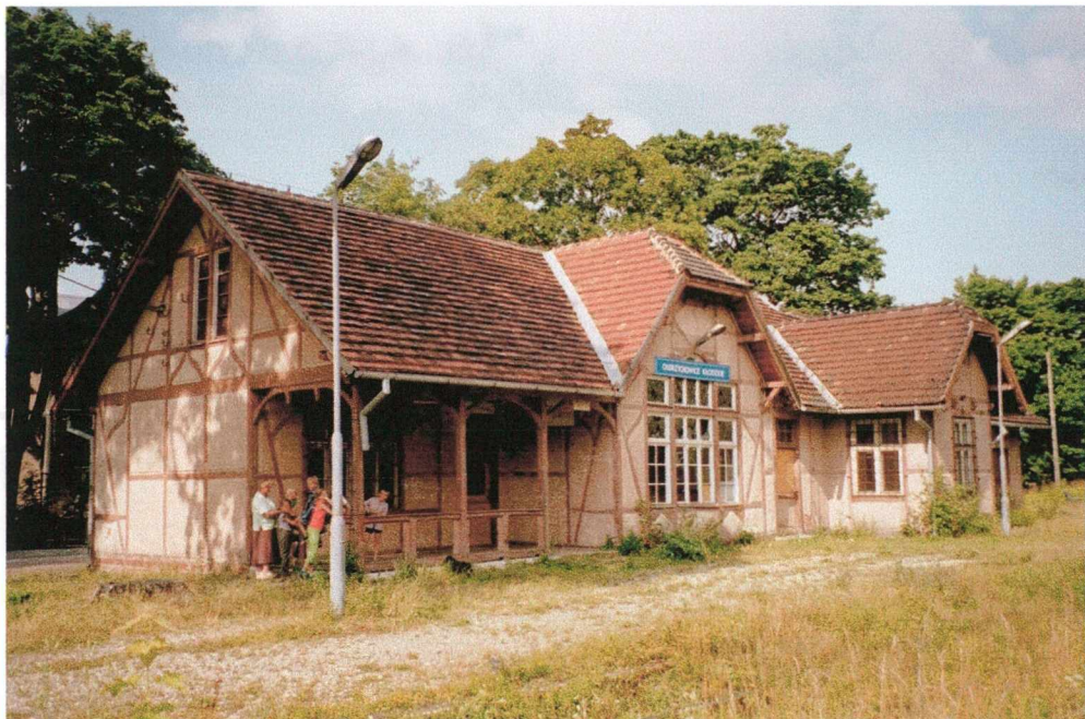
Fot. 14 Odrzychowice Kłodzkie. Widok od peronu na opuszczony obiekt. W odróżnieniu od dworca w Żelaźnie nastawnia przykryta jest dachem z naczółkiem.
