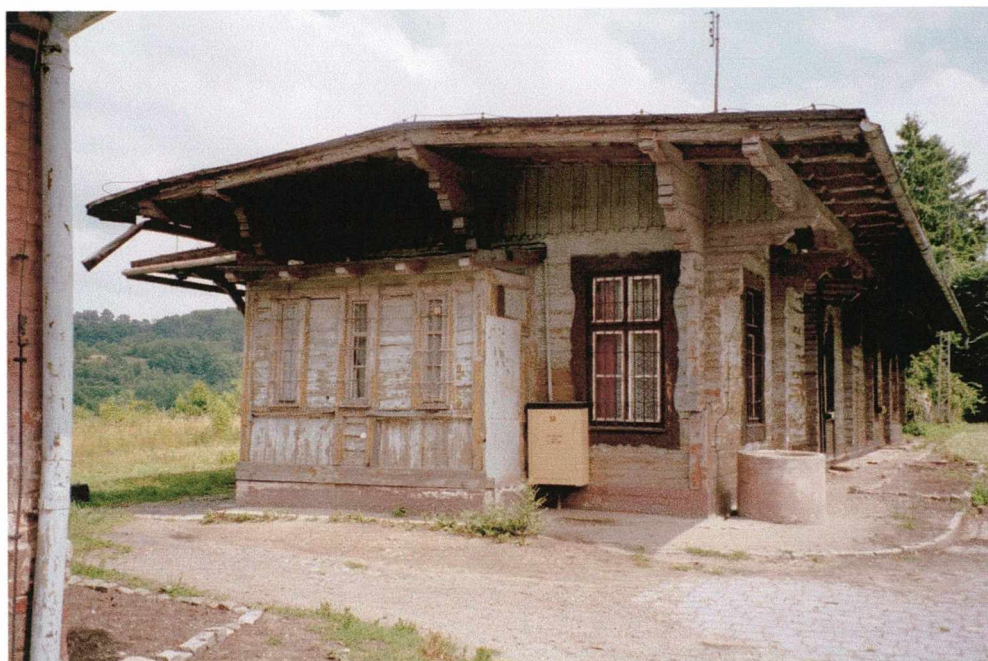
Fot. 70 Lewin Kłodzki. Trasa Kłodzko - Kudowa Zdrój. Całkowicie drewniany obiekt z 1900r., zbliżony stylistycznie do obiektów w Leszczyni i Szklarskiej Porębie Średniej. Widok od strony podjazdu ukazuje bogato profilowane elementy konstrukcji budynku.
