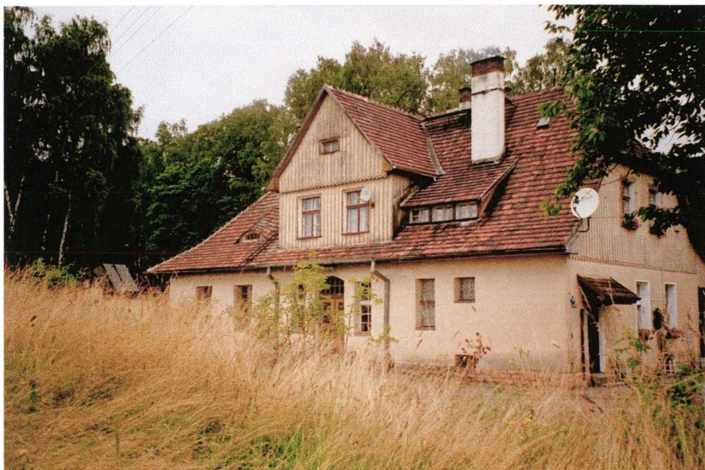
Fot. 77 Ludwikowice Kłodzkie. Dworzec z 1900r. na linii Wałbrzych - Kłodzko zlokalizowano na uboczu miejscowości kilkadziesiąt metrów przed jednotorowym wiaduktem założonym na łuku. Architektura dworca nawiązuje materiałami i detalem otworów okiennych i lukarn do miejscowego typu zabudowy. Widok od strony podjazdu na czynny dworzec.
