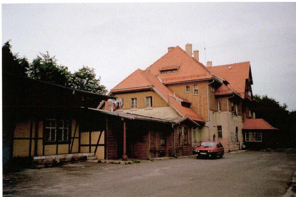
Fot. 53 Szklarska Poręba Górna. Widok od strony podjazdu. Różnorodność detalu wpływa na uatrakcyjnienie architektury dworca.
