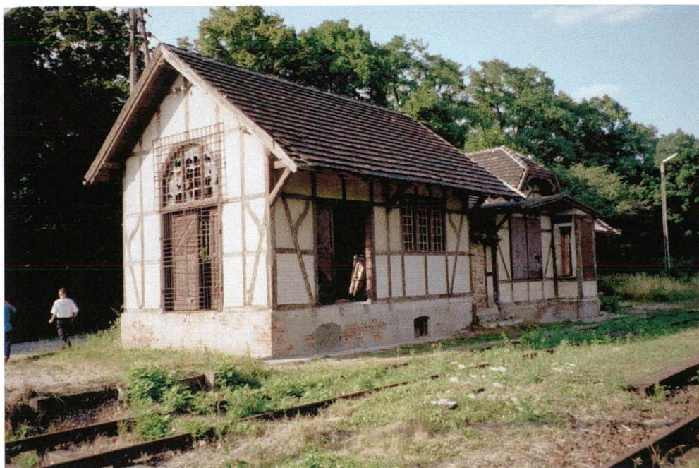
Fot. 5 Marcinowice Świdnickie. Widok od strony magazynu spedycji kolejowej. Zdecydowane przesunięcie poszczególnych partii budynku urozmaica sylwetę dworca.
