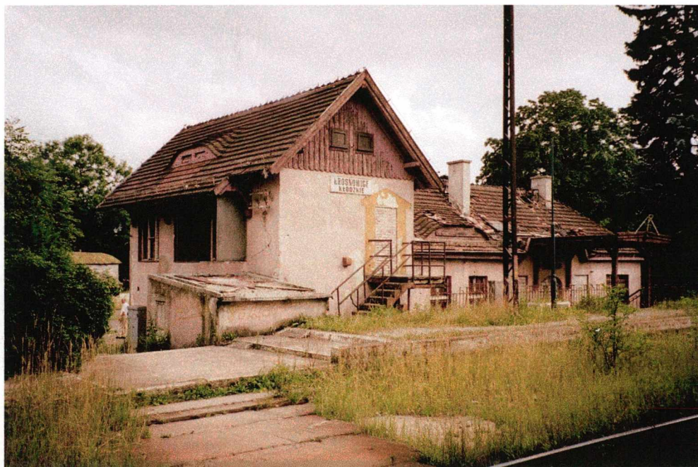
Fot. 96 Krosnowice. Stacja z dwoma poziomami torowisk. Wyższa prowadzi z Kłodzka do Międzylesia, niższa do Stronia Śląskiego. Urozmaicona bryła obiektu opiera się o skarpe z torowiskiem.
