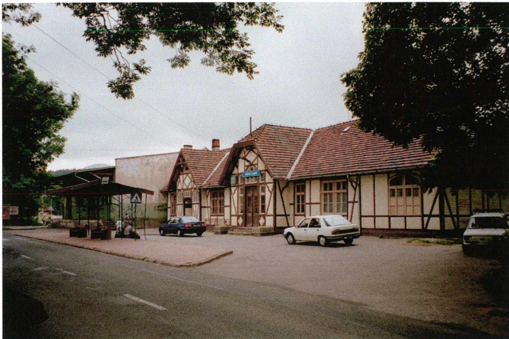
Fot. 15 Stronie Śląskie. Dobrze zachowany dworzec, wzniesiony w 1897r. w konstrukcji szachulcowej należy do grupy dworców sudeckich, które powstały w oparciu o projekt typowy.
