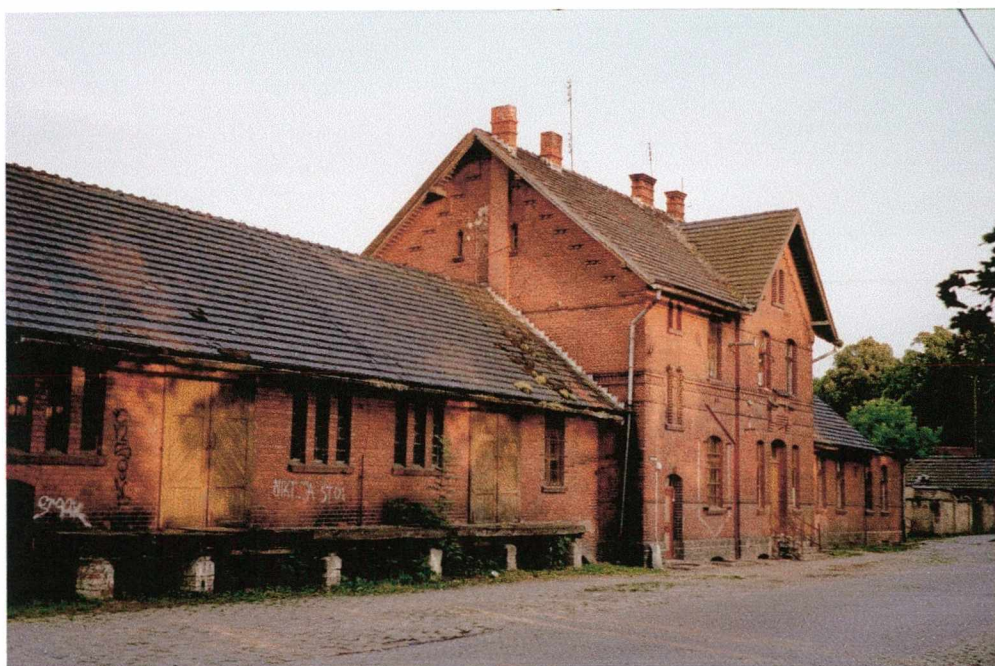
Fot. 59 Niemcza. Typowy budynek dworców na Pogórzu Sudeckim z dużą częścią magazynową na pierwszym planie.
