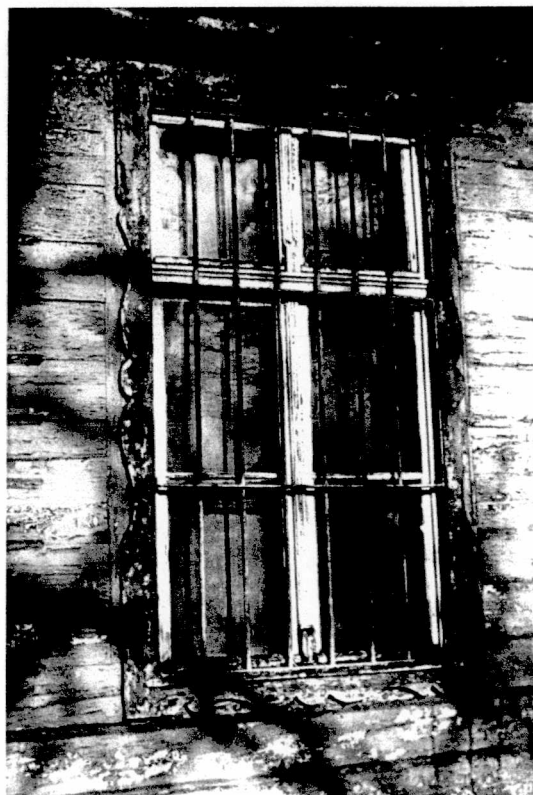
Ryc.92 Leszczyniec. Detal okna Stan obecny
