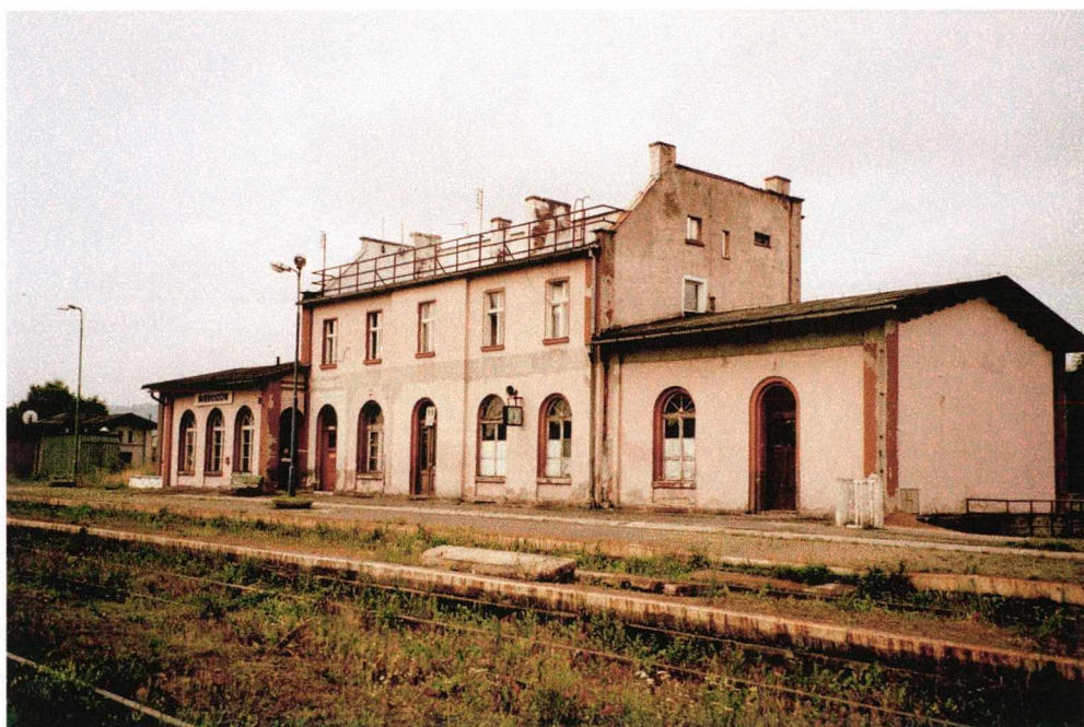
Fot. 95 Mieroszów. Dworzec (obecnie opuszczony) usytuowany na ważnym szlaku do Mezimesti (dworzec odpraw celnych), ważnego węzła kolejowego. Posiadał skromny wystrój fasad. Wyższa, centralna część uległa przebudowie.
