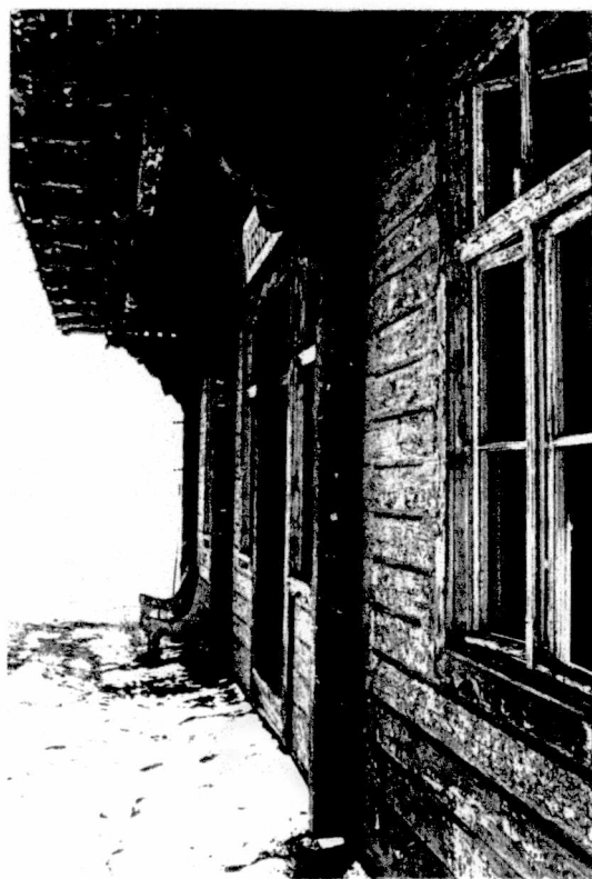
Ryc.94 Leszczyniec. Detal konstrukcji w spierającej dach. Stan obecny
