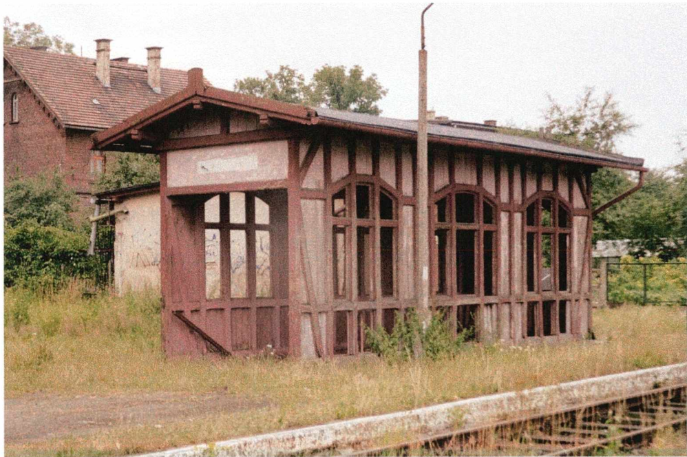
Fot. 93 Mysłakowice. Na perony prowadziły przejścia podziemne, zadaszone wejścia posiadały konstrukcję szkieletową drewnianą.
