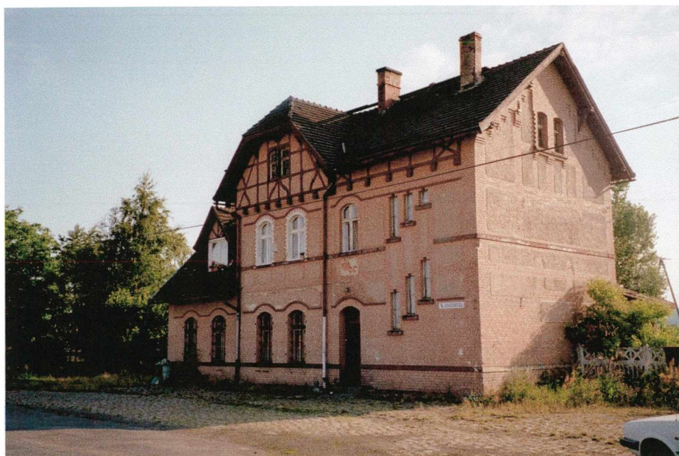
Fot. 17 Świdnica Kraszowice. Nieczynny dworzec kolejowy na linii Świdnica-Jedlina Zdrój z 19..r. Widok od strony podjazdu. Budynek rozplanowany na rzucie prostokąta. Bryłę urozmaicono stosując zmiennaliczbę kondygnacji i wprowadzenie szczytu z dachem naczółkowym.
