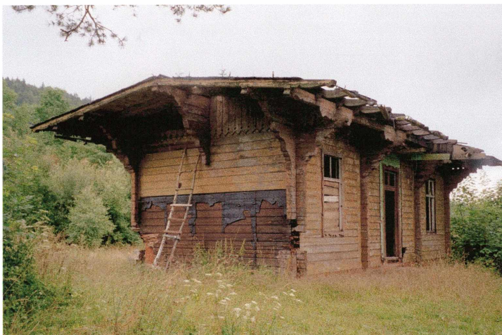
Fot. 68 Leszczyniec. Obiekt na trasie Kamienna Góra Kowary z 1905r. nawiązuje do architektury tyrolskiej. Dach o małym kącie nachylenia połaci i drewniana konstrukcja ozdobnie profilowana to charakterystyczne elementy tego typu dworca sudeckiego. Widok od strony obecnego podjazdu stacji na nieczynny budynek dworca.
