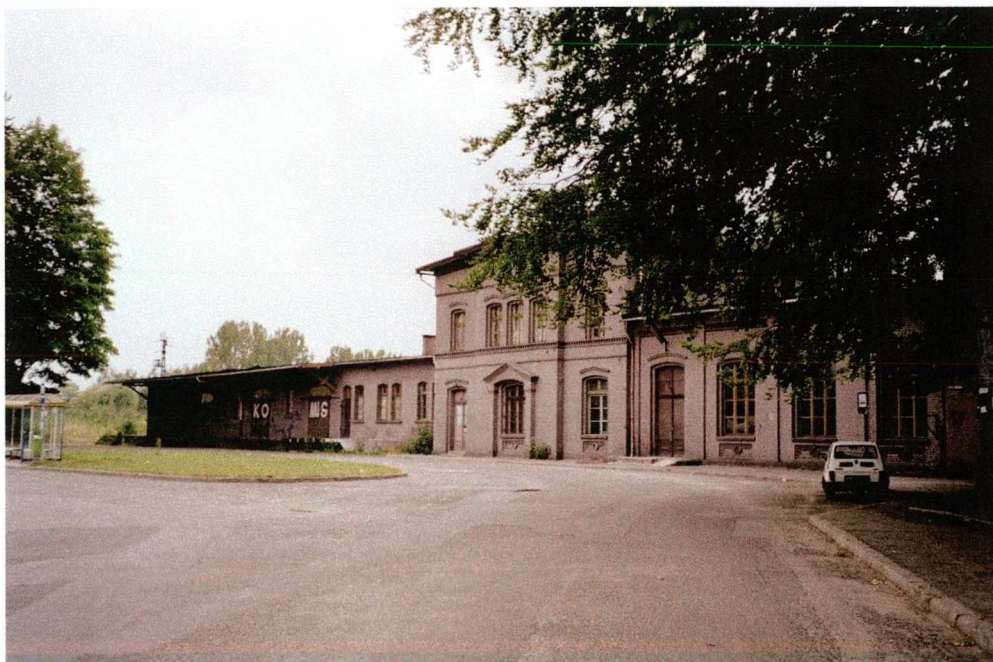
Fot. 87 Mirsk. Dworzec wzniesiony po 1884r. Widok od strony podjazdu.
