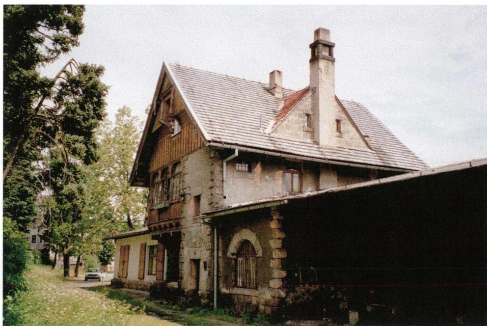
Fot. 28 Radków. Widok od strony podjazdu. Na pierwszym planie magazyn spedycji kolejowej.
