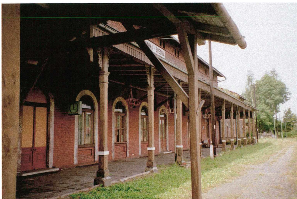
Fot. 67 Ścinawka Śr. Architektura dworca jest urozmaicona przez przylegającą do niego konstrukcję wiaty pokrytą nycerką. Proste, ceglane elewacje obiektu, w skład którego wchodzi również magazyn i część zaplecza, zdominował rytm otworów okiennych i drzwiowych.
