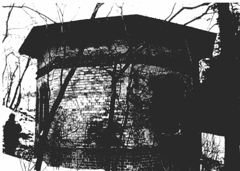
Ryc.97 Mała wieża ciśnienia w Ogorzelcu. Niezwykle rzadkie rozwiązanie wieży typu "kolumna" z trzonem ukrytym w skarpie (zboczu) z 1905r.
