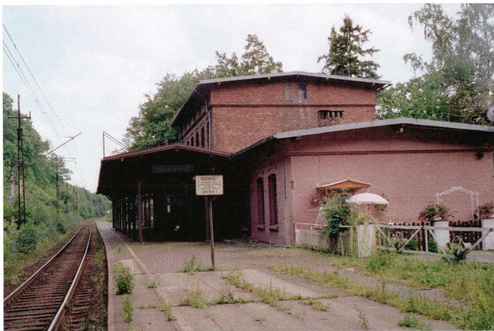
Fot. 63 Długopole Zdrój. Ciągłe czynny dworzec znajduje się w dużym oddaleniu od uzdrowiska i znacznie powyżej niego, w otoczeniu skał i lasów. Prosty, ceglany budynek powstał w 1875r. Wiaty zostały zbudowane później.
