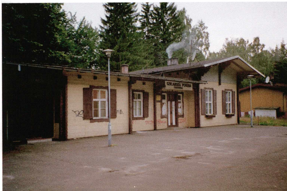
Fot. 74 Szklarska Poręba Średnia. Urozmaicona bryła budynku który wybudowano w 1902r. "ożywia" elewację. Jest to największy obiekt z grupy dworców wzniesionych w stylu tyrolskim.
