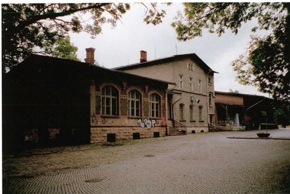
Fot. 55 Polanica Zdrój uzyskała połączenie kolejowe z Kłodzkiem dopiero w 1902r. Pierwszy drewniany dworzec został zaadoptowany jako część nowego murowanego obiektu. Widok od strony podjazdu.
