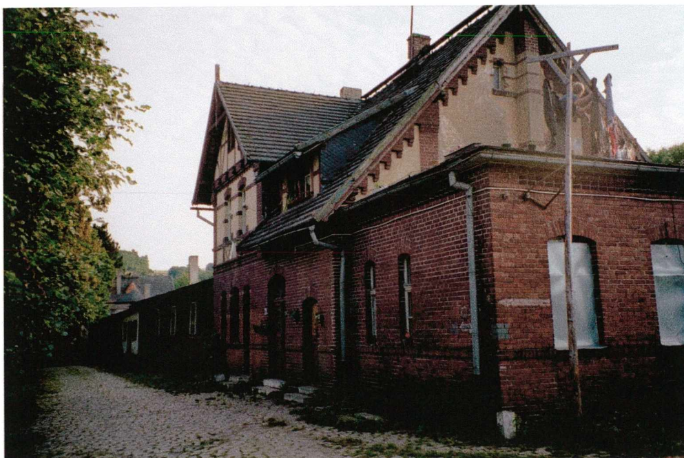
Fot. 19 i 20 Zagórze Śląskie. Widok dworca od strony podjazdu i peronu. Charakterystyczny szczyt budynku wzniesionego w 1904r, cechuje zastosowanie łukowej belki konstrukcji muru; nadwieszenie nad niższą kondygnacją z uwidocznieniem czoła belek stropowych.
