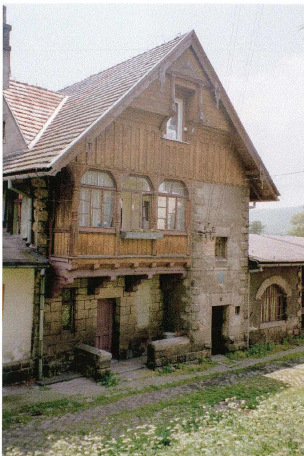
Fot. 27 Radków. Szczyt od strony podjazdu. Widoczna drewniana Weranda na pierwszym piętrze.
