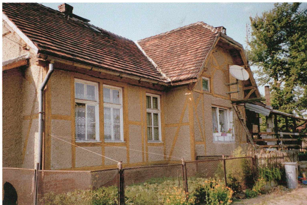
Fot. 2 Szczepanów. Widok od strony dawnego podjazdu. Obecnie budynek zaadaptowano na cele mieszkalne; wtórna stolarka drzwiowa i okienna.
