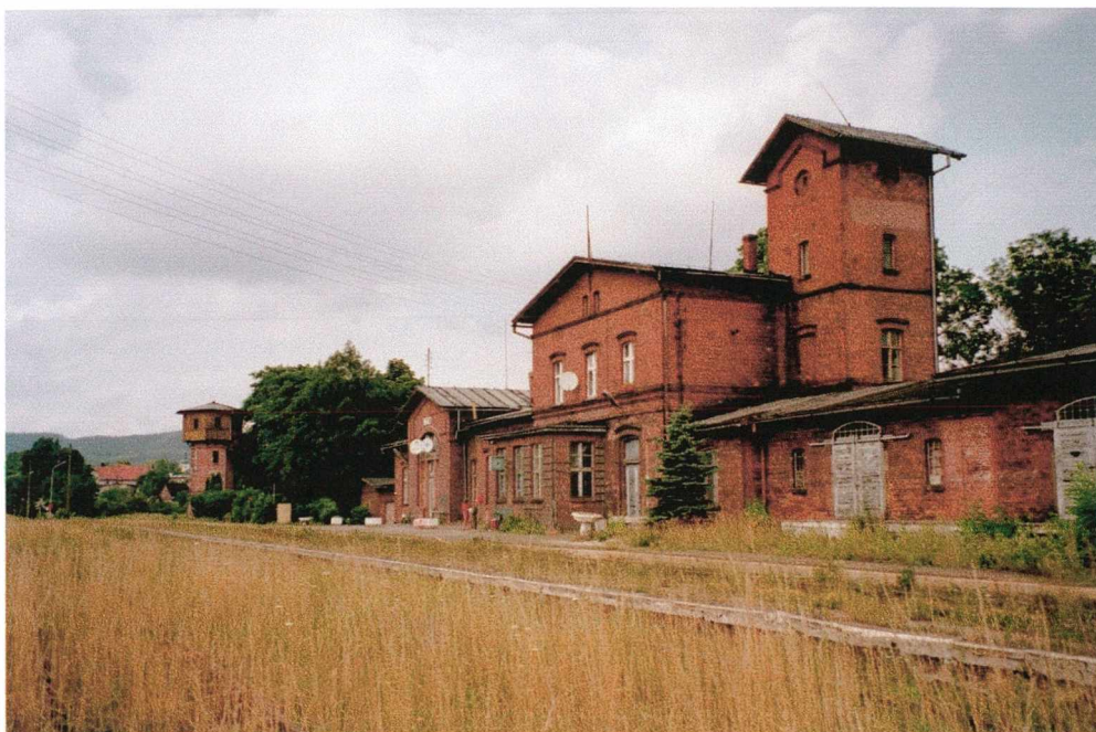
Fot. 61 Szczytna. Widok od strony peronów ma urozmaiconą bryłę dworca kolejowego. W tle wieża ciśnień wzniesiona w tym samym czasie co pozostałe budynki stacji.
