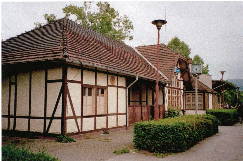
Fot. 16 Stronie Śląskie. Widok od strony peronu. Dworzec ciągle jeszcze pełni swą rolę stacji końcowej linii Kłodzko-Stronie Śl.
