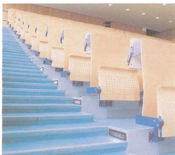
Nawiewniki laminarne typ Q - SL Technical College, Cottbus
