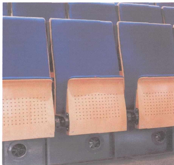
Nawiewniki wirowe typ Q - DS - DD Audytorium, Uniwersytet w Amsterdamie
