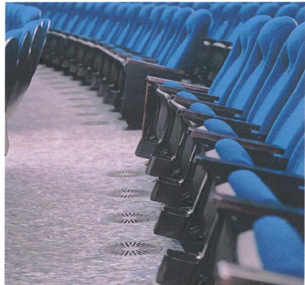
Nawiewniki wirowe typ Q - DB - E Kino „Kosmos UFA-Palast”, Berlin
