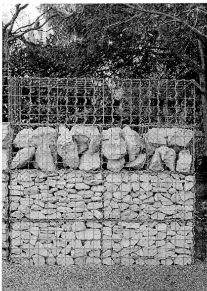
Rys. 4.4.11. Winnica Dominus. Makieta 1:1 kamiennej otuliny budynku. [Dominus 1997, s.190]
