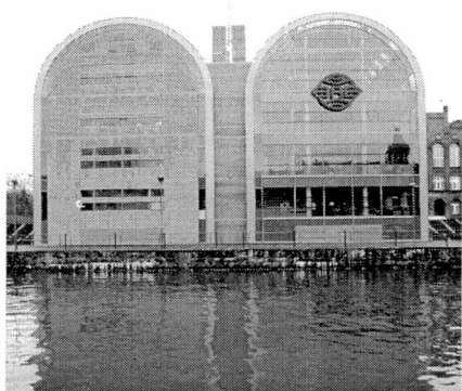
Rys. 2.12. Bulanda Mucha – Architekci. Budynek BRE Banku w Bydgoszczy. [fot. Bartosz Narożny]
