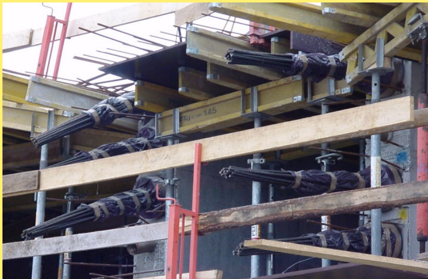
Rys. 2.90 – wiązki nieosłoniętych splotów sprężających 7-drutowych, ułożone jako kable sprężające konstrukcję żelbetową mostu podwieszanego: Most Milenijny we Wrocławiu, sploty firmy BBR (stan przed naprężeniem). 1)
