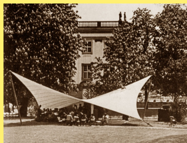
Rys. 3.11 – powłoka siodłowa, o czterech punktach podparcia
