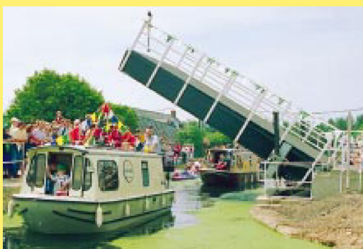
Rys. 2.114 – kompozytowy most zwodzony Bonds Mill, k. Gloucester w Wielkiej Brytanii. Fotografia za [72].
