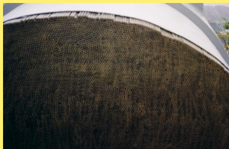
b). przekrój przez linę kablową
