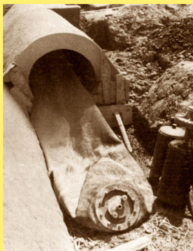
Rys. 2.98 – pneumatyczny element deskowania rurociągów betonowych, wykonywanych in situ, stosowany współcześnie. Produkt firmy Noe (Francja).
