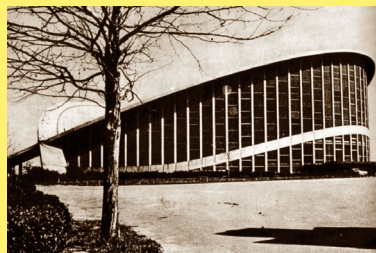
Rys. 3.15 – powierzchnia siodłowa rozpięta pomiędzy dwoma stykającymi się łukami
