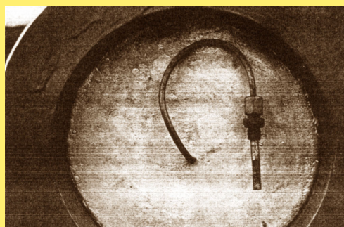
Rys. 2.92 – widok zakotwienia liny w rurze osłonowej, po iniekcji zaczynem cementowym. Widoczna jest końcówka rurki do iniekcji [178]
