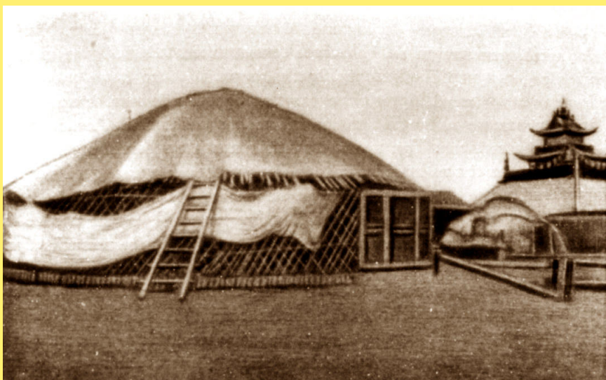
Rys. 2.46 – wielki, pochodzący z XVI w., namiot szkieletowy o konstrukcji kratkowej, wybudowany dla Abadaj Chana. Obecnie nie istniejący. Fotografia została wykonana w 1960 r.
