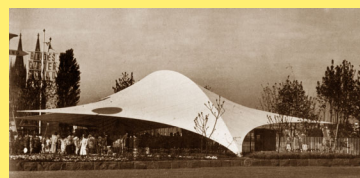
Rys. 3.30 – schemat powierzchni membranowej podparciej łukiem
