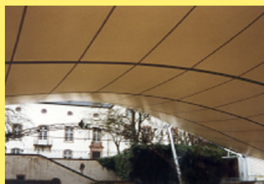
Rys. 3.13 – powierzchnia siodłowa o wielu punktach podparcia
