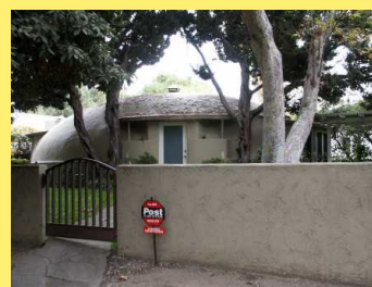
Rys. 2.97 – eksperymentalny budynek żelbetowy (Experimental Dome House) wg projektu W. Neffa, wykonany na deskowaniu pneumatycznym, w 1946 r., w Pasadenie. Stan obecny.
