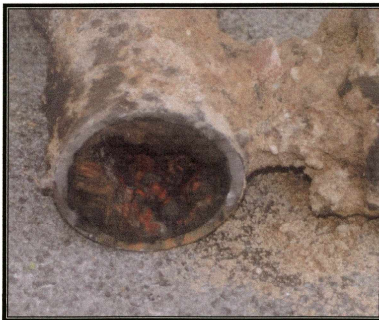
FOTOGRAFIA 5.5. Wymieniony hydrant z punktu 13
