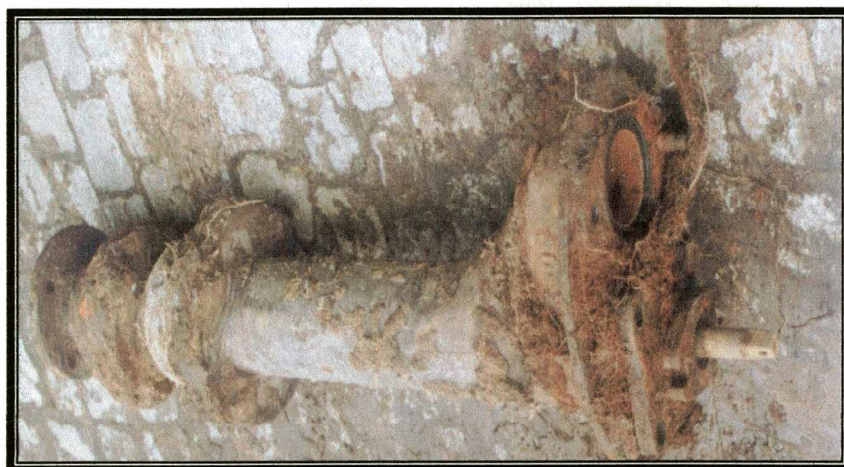
Fotografia 5.4. Wymieniony hydrant (punkt 12)
