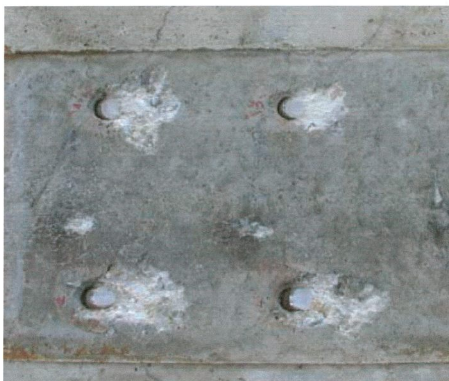
Rys. 5.16. Zniszczona próbka ścinana – łączniki zerwane (próbka Z1)
