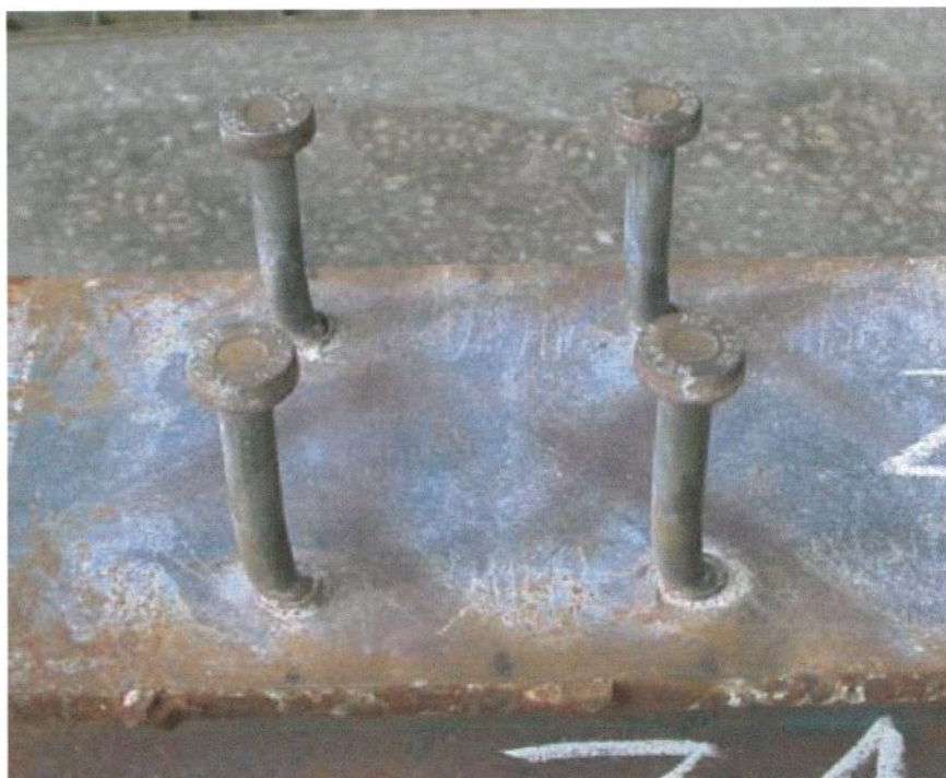
Rys. 5.13. Zniszczona próbka ścinana – łączniki uplastycznione (próbka Z1)
