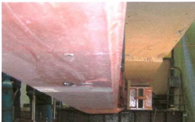
Rys. 6.43. Mechanizm zniszczenia – lewa strona belki
