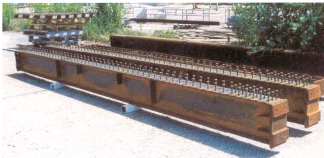
Rys. 6.2. Belki stalowe ze sworzniami przed wykonaniem płyty betonowej
