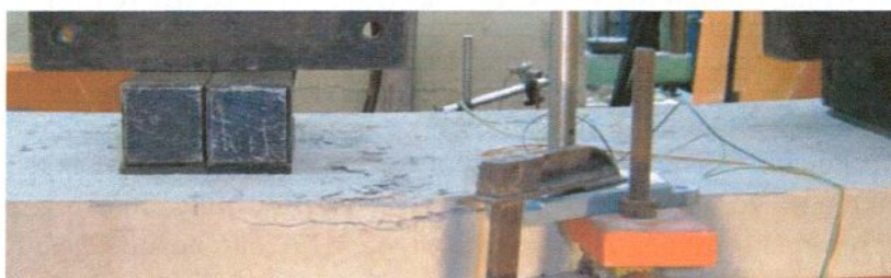
Rys. 6.31. Przesło belki po zniszczeniu – zmiażdżony beton płyty
