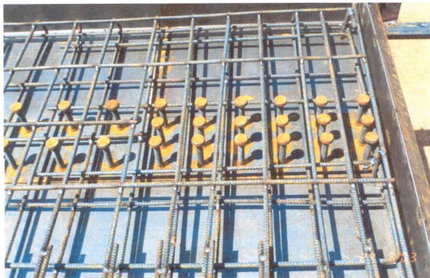
Rys. 6.3. Sworznie zespolenia i zbrojenie belki
