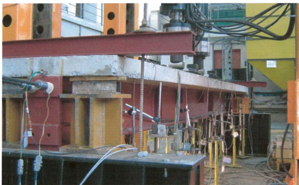
Rys. 6.7. Widok ogólny belki
