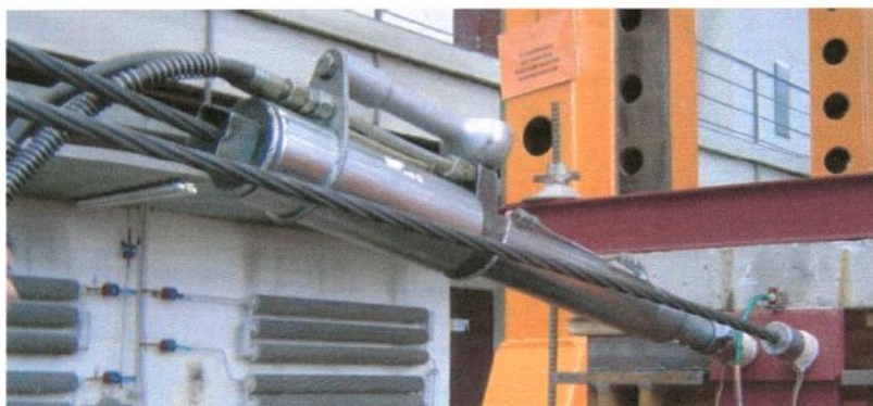
Rys. 6.23. Prasa na splocie podczas sprężania
