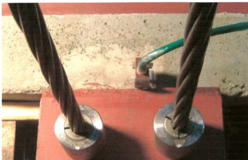
Rys. 6.36. Rysa nad zespoleniem na końcu belki
