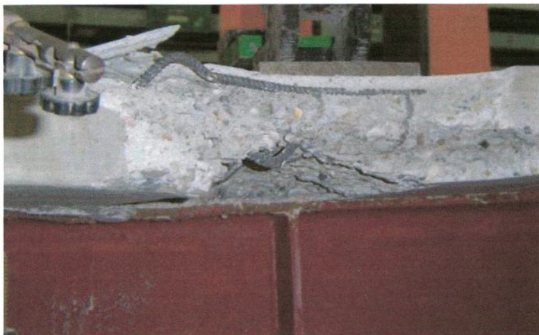
Rys. 6.46. Mechanizm zniszczenia – płyta z lewej strony belki
