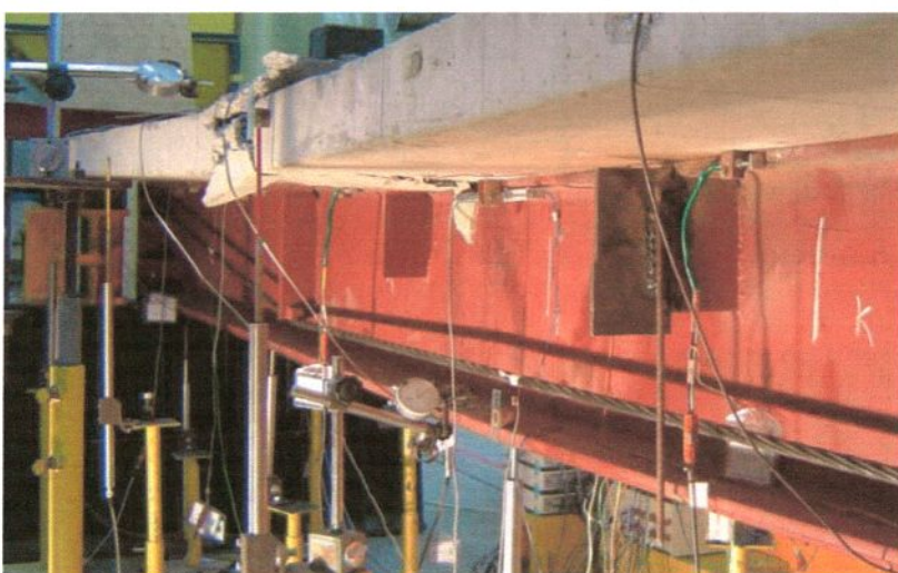
Rys. 6.53. Belka po zniszczeniu
