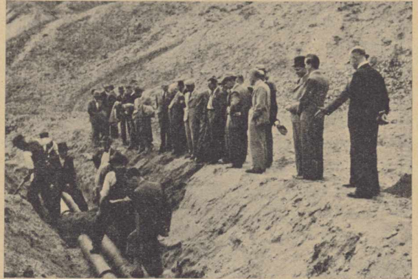
Z wycieczki do Zakładów W. I. Układanie rur w wykopie.
