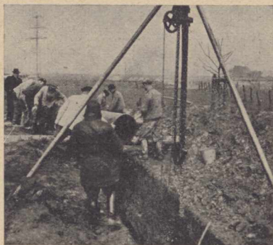
Rys. 3. Układanie przewodu z rur żeliwnych \varnothing 500 mm z elastycznymi połączeniami „Union” w Unna.
