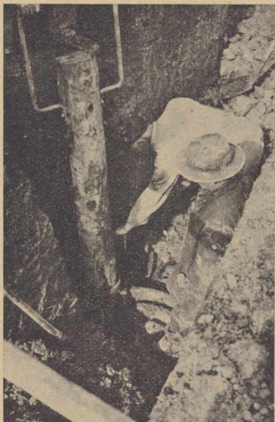
Rys. 6. Układanie przewodu z rur żeliwnych \varnothing 500 mm z elastycznymi połączeniami „Union” w Unna.
