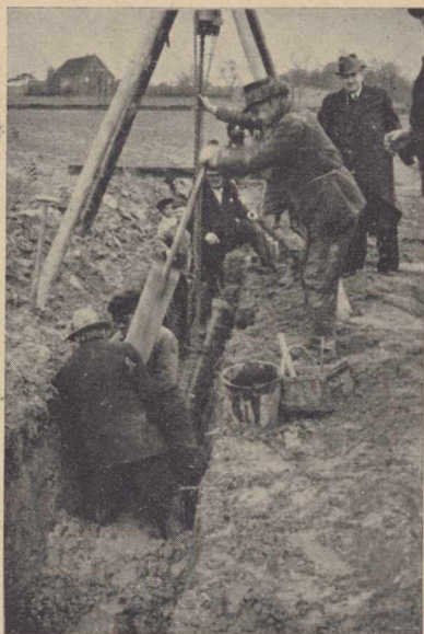
Rys. 8. Układanie przewodu z rur żeliwnych \varnothing 400 mm z elastycznymi połączeniami „Union” w Hamm.
