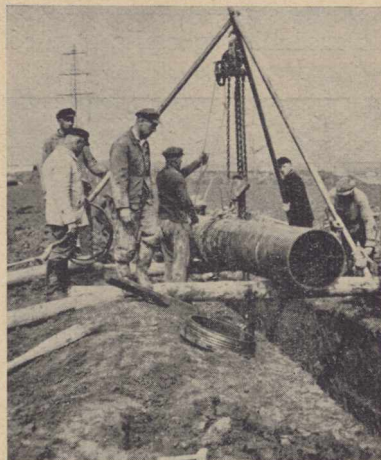
Rys. 4. Układanie przewodu z rur żeliwnych \varnothing 500 mm z elastycznymi połączeniami „Union” w Unna.
