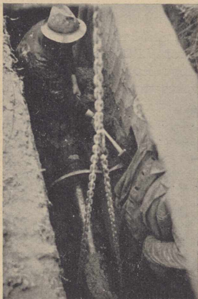
Rys. 2. Układanie przewodu z rur żeliwnych \varnothing 250 mm z elastycznymi połączeniami „Union” w Düsseldorf.
