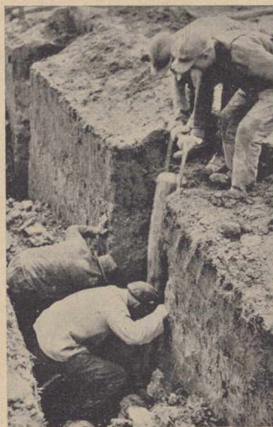
Rys. 5. Układanie przewodu z rur żeliwnych \varnothing 500 mm z elastycznymi połączeniami „Union” w Unna.
