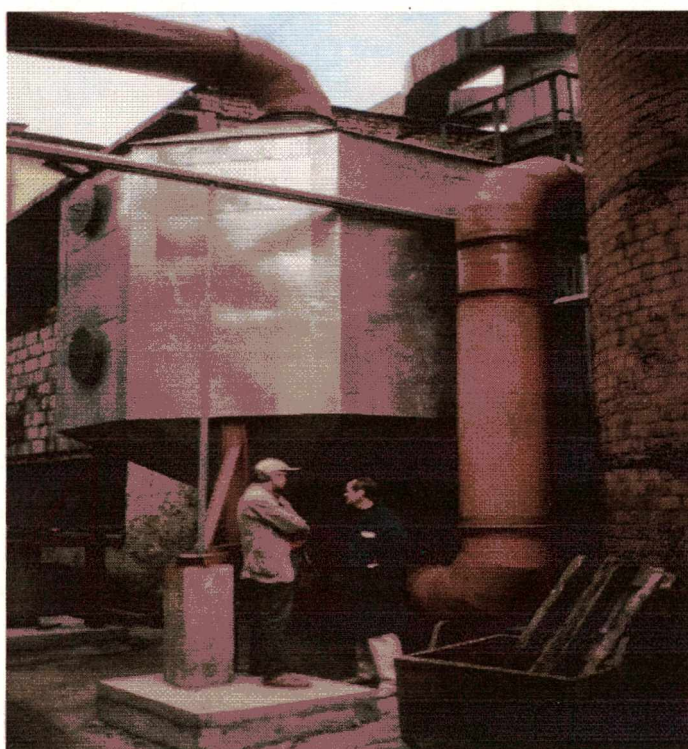
Rysunek 10.3. Adsorber ze złożem buforującym Instalacji biofiltracji w FAP ZETKAMA w Kłodzku.
