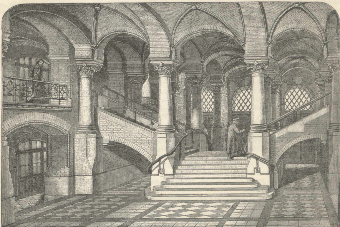
Fig. 802. Treppenhalle des Johannis-Stiftes in Leipzig (Architekt C. Lipsius).
