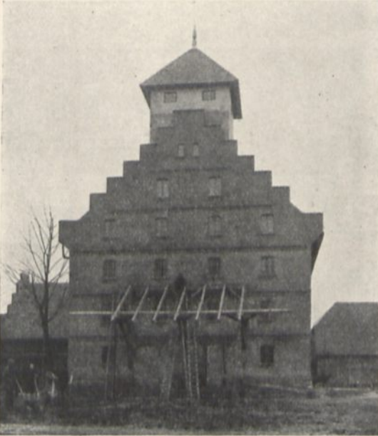
Abb. 278. Getreidespeicher Gutzeit in Groß-Gnie. Giebelansicht.
