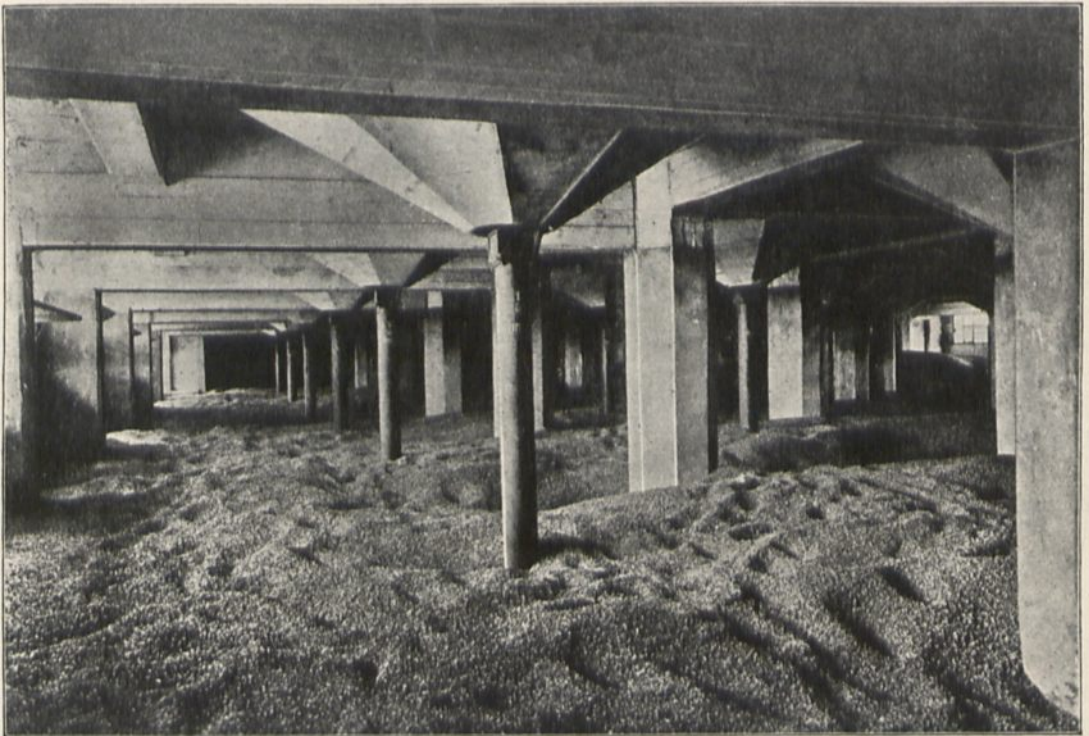
Abb. 273. Getreidespeicher Danzig. Ungeteilter Trichterboden.
