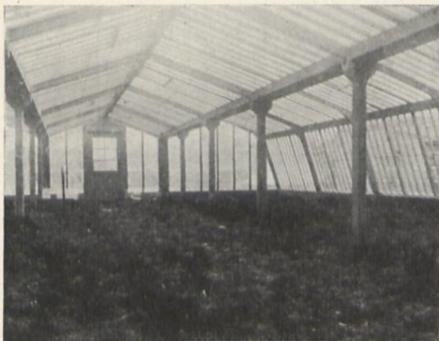
Abb. 387. Stadtgärtnerei Charlottenburg. Tomatenhaus. Innenansicht gegen den Westgiebel.
