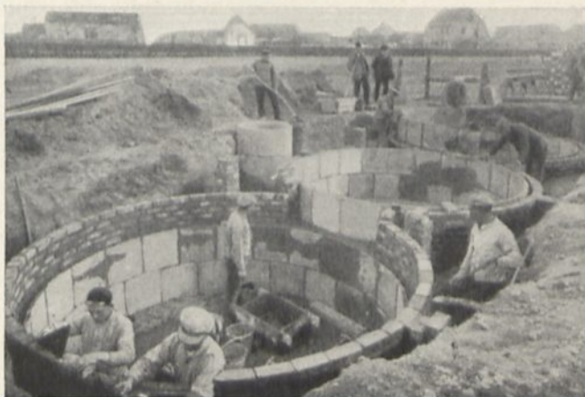
Abb. 343. Ausführung einer Siloanlage nach Bauweise Pfister.
