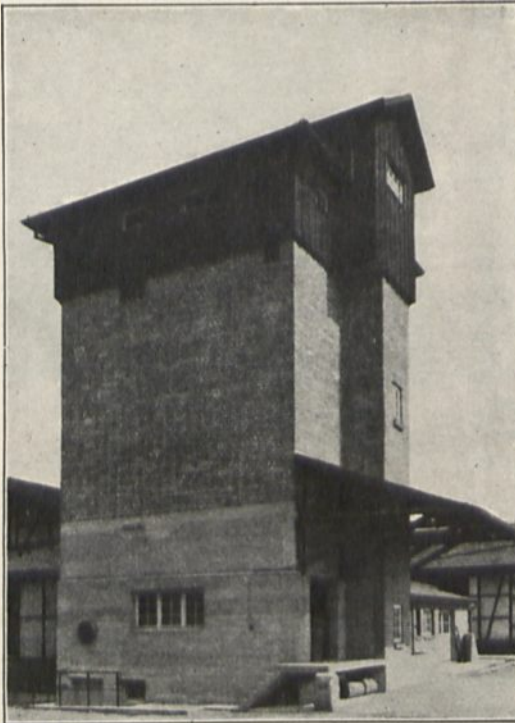
Abb. 291. Ranksches Lüftsilo der Zuckerfabrik Böblingen, Württemberg.
