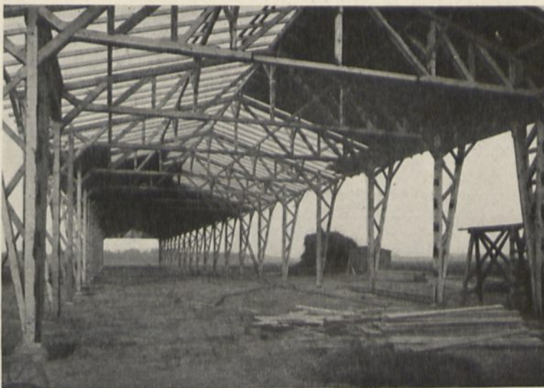
Abb. 246. Feldscheune Nürnberg-Altenfurth während der Ausführung.
