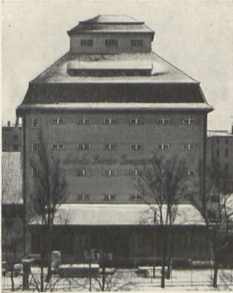
Abb. 304. Getreidespeicher Allenstein. Ansicht von der Straßenseite.
