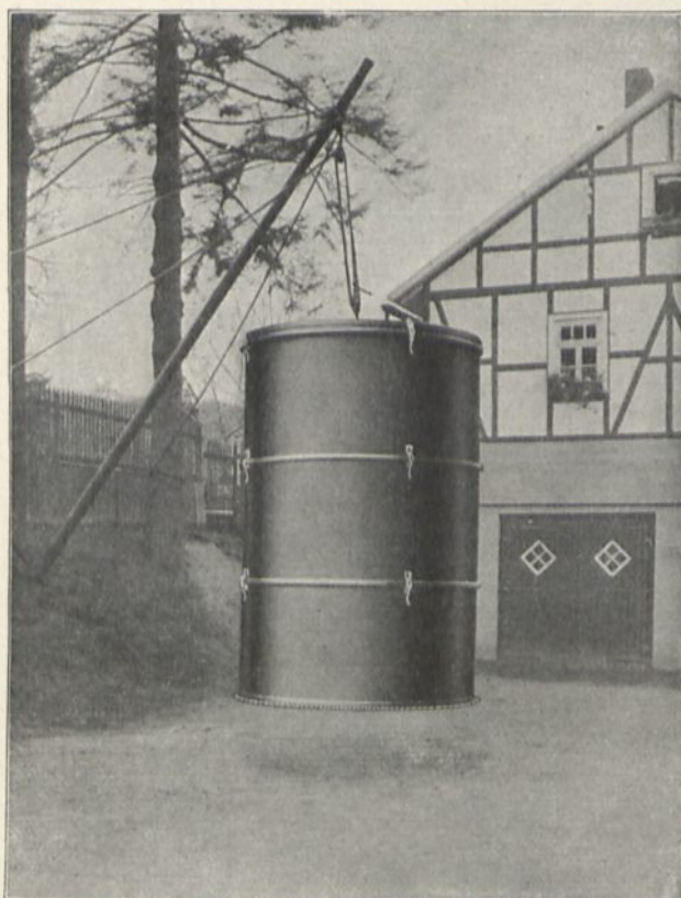
Abb. 344. Metall-Ring-Silo, System Aurich der Firma: Silo- und Kulturtechnik Richard Aurich, Dresden. Aufeinander- setzung der einzelnen Ringe mittels eines Schwenkkranes.
