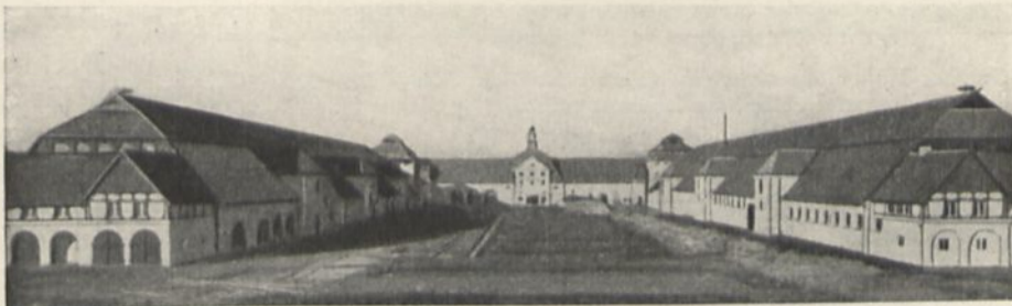
Abb. 15. Gutshof Hahnenmoor. Ansicht des Wirtschaftshofes vom Verwaltungsgebäude aus. Rechts Rindviehstallungen, links Pferdestallungen usw., in den Ecken Dreschtürme, als Querabschluß Scheunen und Torgebäude.
