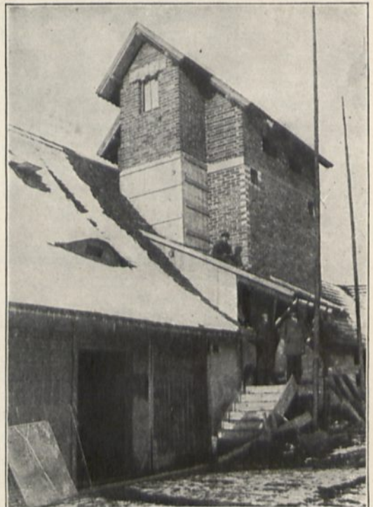
Abb. 292. Eingebautes Ranksches Lüftsilo der Gutsverwaltung Sobětice.
