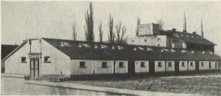
Abb. 129. Stallgebäude Kehidai von außen gesehen, hinten Kornspeicher mit anschließender Scheune.
