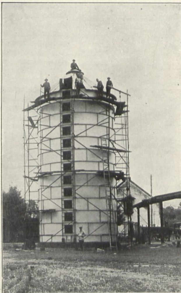
Abb. 351. „Deutschland“-Stahlhochsilo im Bau.
