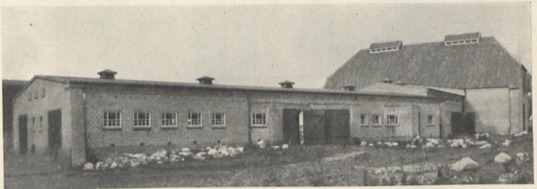
Abb. 91. Laufstallanlage Domäne Gr. Niendorf. Teilansicht gegen den Jungviehstall, von der Straße aus.
