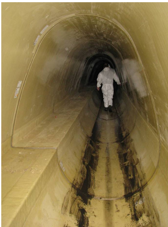
Rys. 3.8. Widok wnętrza kanału po odnowie z zastosowaniem linera z GRP
