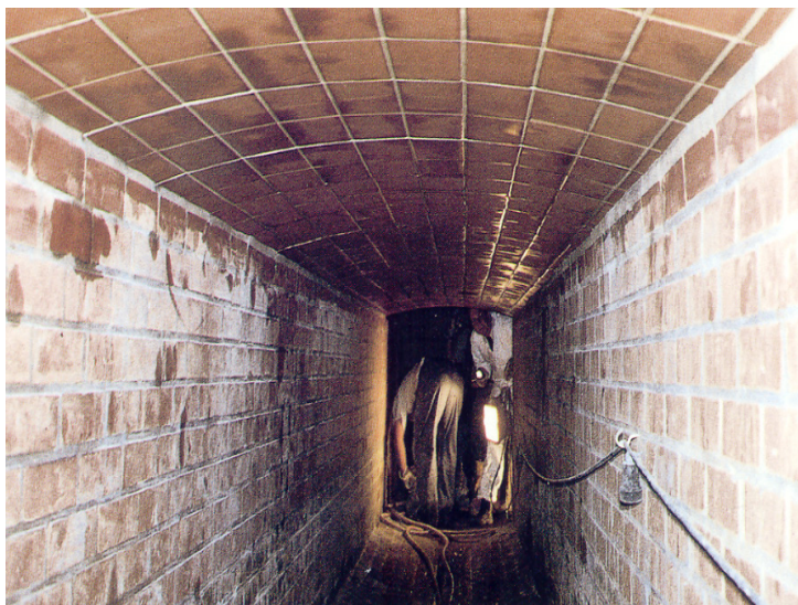
Rys. 3.3. Rewaloryzacja konstrukcji stropu kanału murowanego przy użyciu płytek ceramicznych
