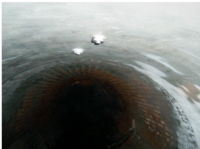
Rys. 3.2. Powierzchnia kanału w trakcie nanoszenia warstwy ochronnej z modyfikowanej zaprawy cementowej (fot. autorska)
