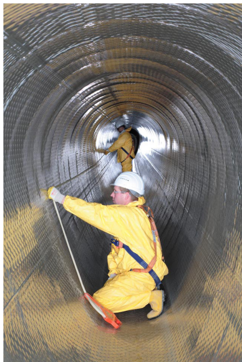
Rys. 3.30. Montaż linera w systemie Maxi-TroLining [3.15]
