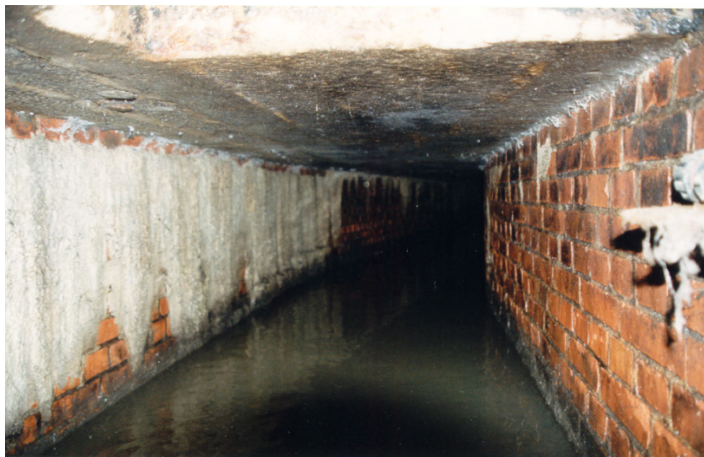
Rys. 3.9. Widok wnętrza kolektora o konstrukcji ceglano-granitowej (fot. autorska)
