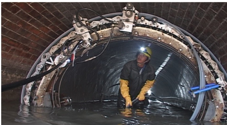
Rys. 3.33. Odnowa kanału murowanego systemem SPR (Szczecin)
