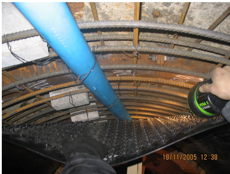
Rys. 3.29. Wprowadzanie iniektu [3.13]
