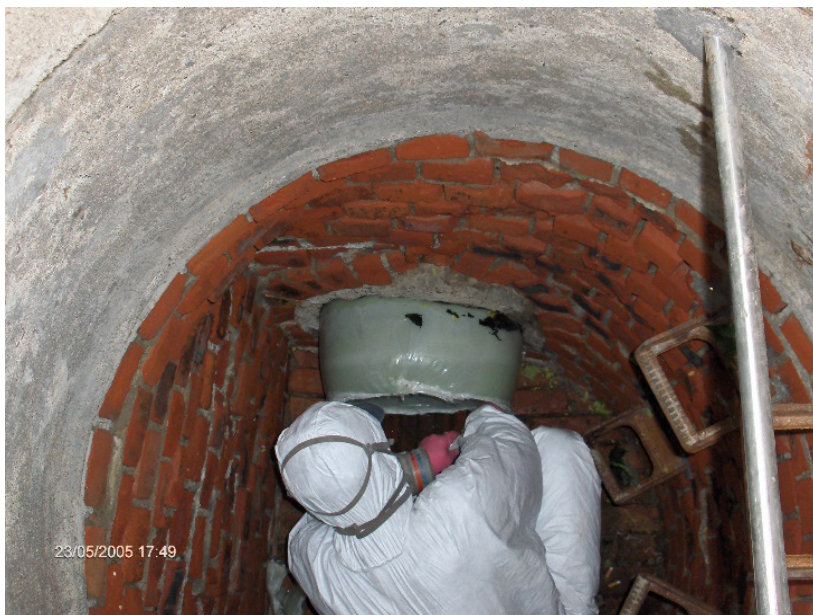
Rys. 3.34. Widok częściowo odnowionej studzienki rewizyjnej
