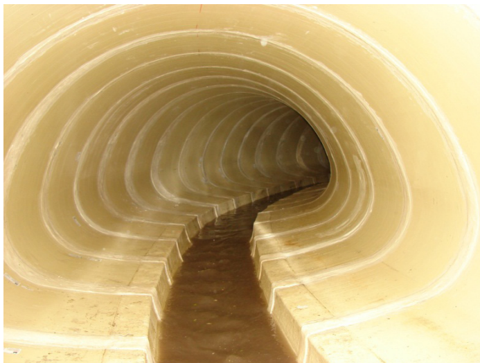
Rys. 3.7. Widok wnętrza kanału po odnowie z zastosowaniem linera z GRP
