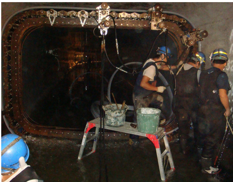
Rys. 3.34. Odnowa kanału o przekroju prostokątnym systemem SPR (Kawasaki) (fot. autorska)
