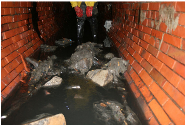
Rys. 4.7. Zanieczyszczenie kinety (fot. autorska)
