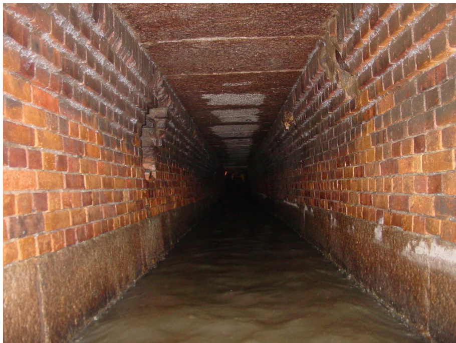
Rys. 1.3. Widok kanału o przekroju zbliżonym do kwadratowego
