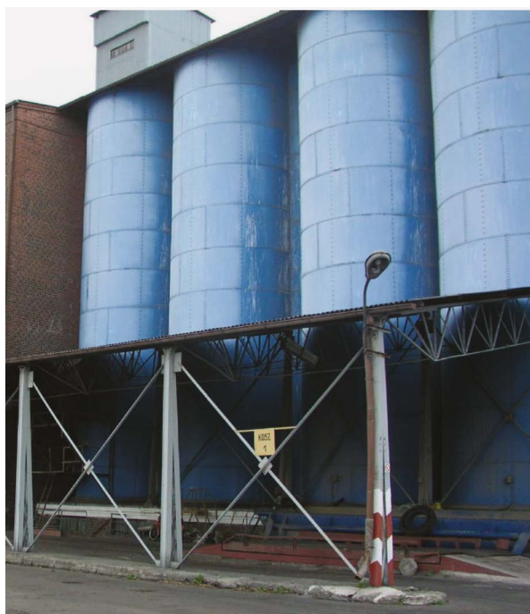
Fot. 1. Widok zewnętrzny elewatora PZZ „Opole – Port”
