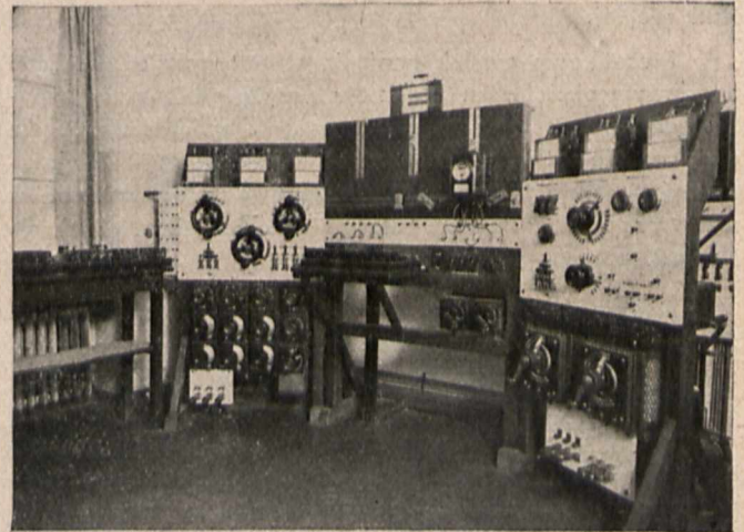
Rys. 12. Duża tablica rozdzielcza prądu trójfazowego.
