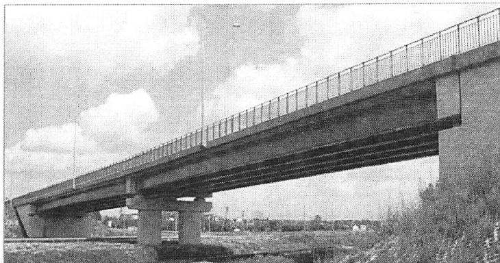
Rys. 2. Wiadukt z dźwigarów zespolonych typu VFT w miejscowości Kije jako przykład obiektu mostowego z przeszłami o konstrukcji zespolonej [23]
