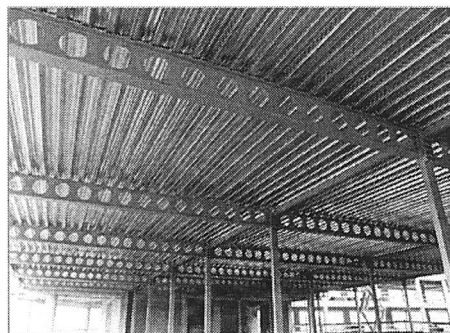
Rys. 4. Strop zespolony na belkach walcowanych oraz jego wersja z belkami ażurowymi (M. Haller, ArcelorMittal)
