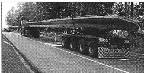
Rys. 7. Technologia budowy obiektu z dźwigarów VFT-VIB® (wiadukt w Pöcking):
