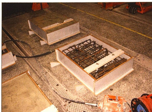
Rys. 89. Realizacja elementów do badań – betonowanie pierwszej płyty
