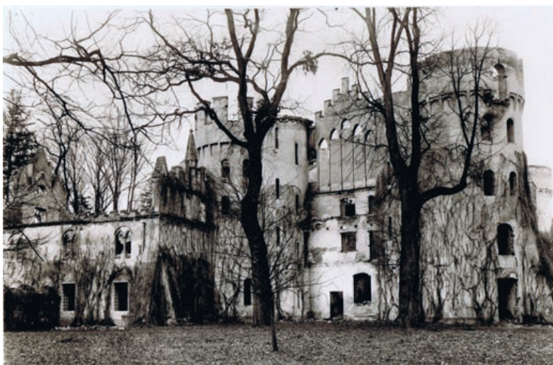
Il. 79. Elewacja południowa zamku w Zawadzkie po pożarze w 1914 r. Fot. Tadeusz Szydłowski, 1915
