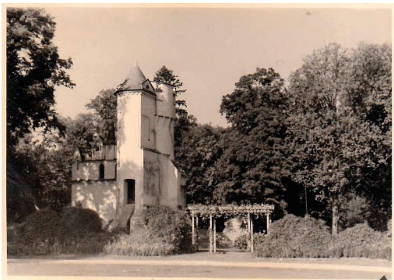
Il. 83. Zabezpieczone ruiny zamku w Zawadzie. Fot. nieznanego autora, 10 września 1939
