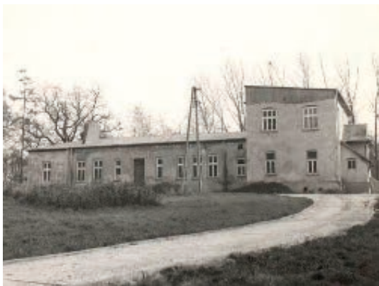
Il. 281. Dawny dwór w Przyborowie, widok od strony frontowej. Fot. nieznanego autora, 1977
