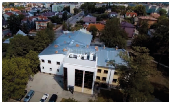
Il. 430. Efekt rozbudowy dawnej siedziby Towarzystwa Gimnastycznego „Sokół”. Kadr z filmu nieznanego autora
