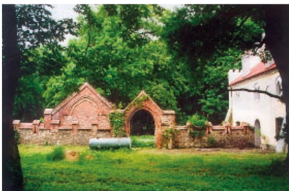
Il. 107. Mur łączący kaplicę i basztę zamku w Zawadzie ze starą pralnią. Fot. Tomasz Rożowski, 2002
