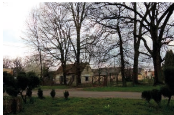
Il. 326. Widok na zabudowania po zachodniej stronie alei dojazdowej do dworu w Przyborowie. Fot. Sabina Leska, 2014
