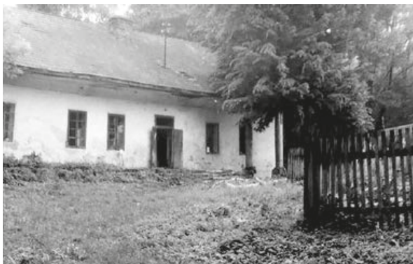
Il. 159. Zachodnia elewacja południowej części dworu w Januszkowicach. Fot. Jan Olech, 1984
