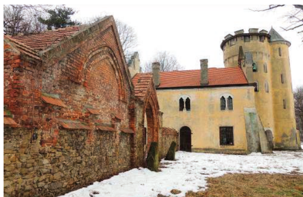
Il. 110. Widok na mur łączący pralnię z kaplicą i basztą od południa. Fot. Sabina Leska, 2014
