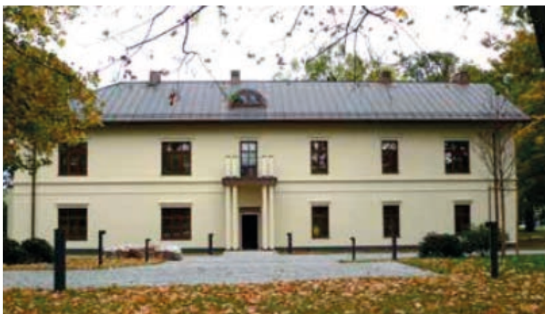
Il. 524. Dwór w Nagawczynie po kapitalnym remoncie. Fot. nieznanego autora, b.d.
