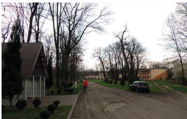
Il. 325. Widok z drogi dojazdowej do dworu w Przyborowie w kierunku południowym, w oddali północna fasada zrujnowanego dworu, z prawej strony zabudowania mieszkalne. Fot. Sabina Leska, 2014
