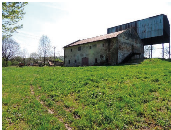
Il. 401. Spichlerz w Strzegocicach widziany od północnego wschodu. Fot. Sabina Leska, 2018
