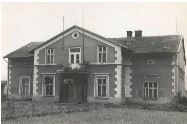
Il. 353. Elewacja budynku dawnej pralni i służby dworskiej, obecnie mieszkania administracji Rolniczej Spółdzielni Produkcyjnej w Kleciu. Fot. Jerzy Dziewolski, 1985
