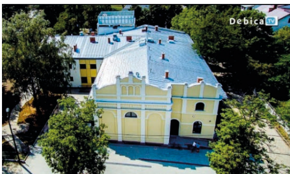
Il. 429. Dom Kultury „Śnieżka”, dawna siedziba Towarzystwa Gimnastycznego „Sokół”. Stan po remoncie przeprowadzonym w 2017 r. Kadr z filmu nieznanego autora
