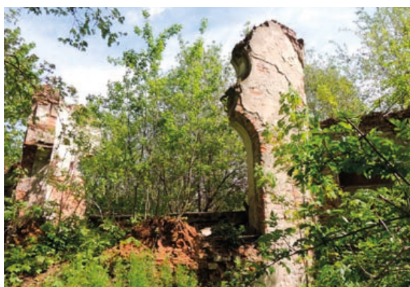
Il. 612. Ruiny dworu w Zwierniku I. Fot. Sabina Leska, 2019
