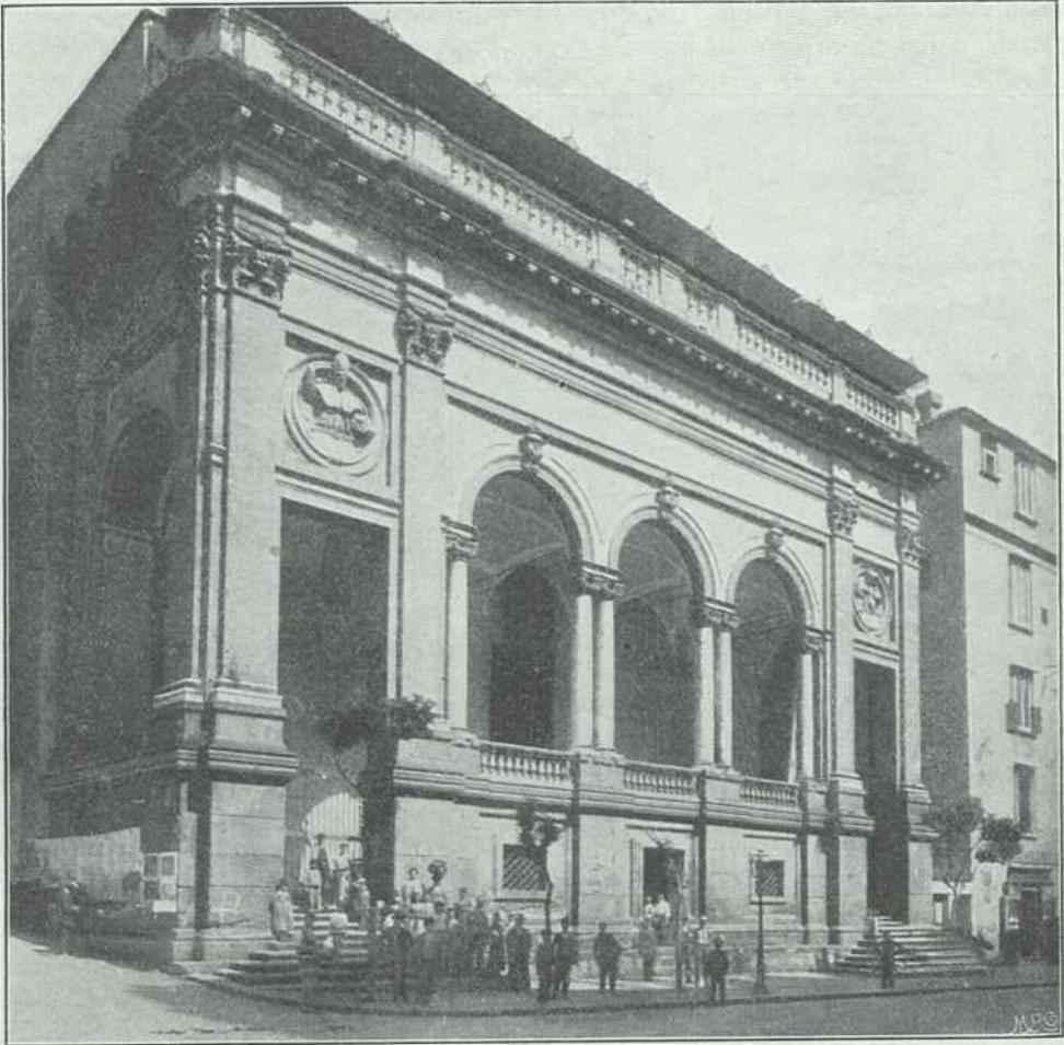
Vorhalle der Sapienza in Neapel.
