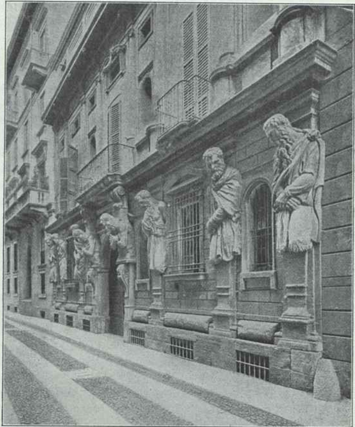
Fassade des Palazzo Lioni ( Omenoni ) in Mailand.
