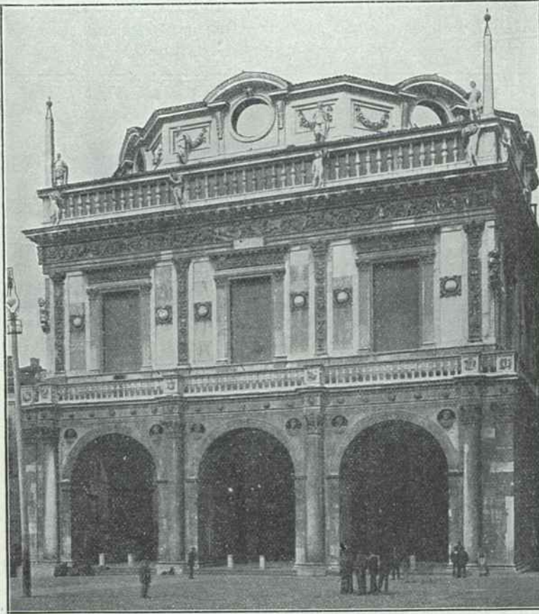
Fassade des Rathauses in Brescia.
