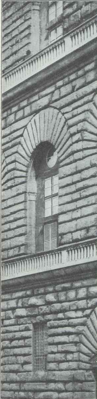
Quaderföichtung am Palazzo Pitti in Florenz.
