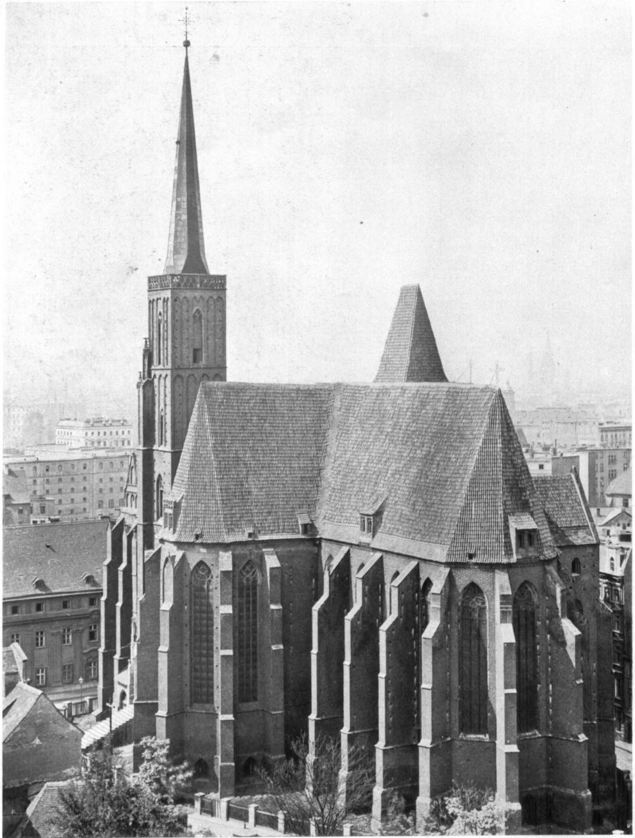
105. Kreuzkirche. Ansicht von OSO vom nordwestl. Domturm
