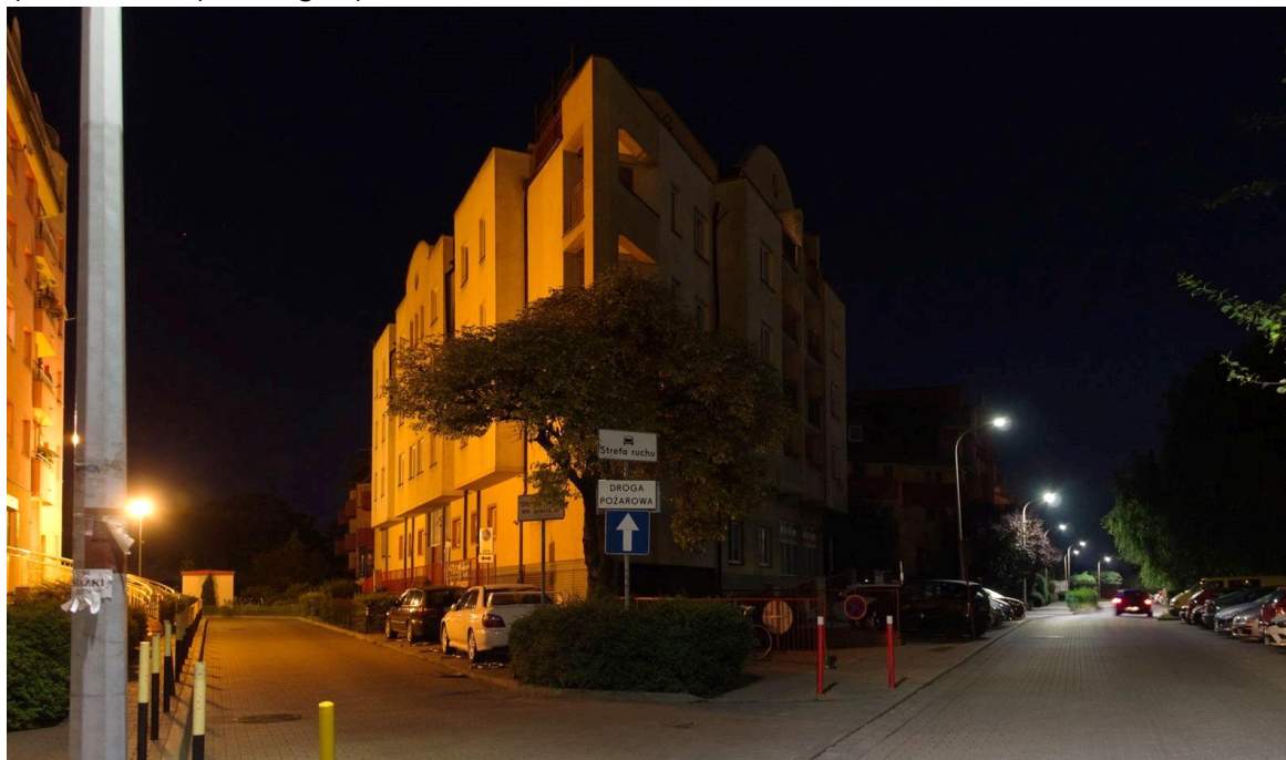
Fot. 3. Widoczna ucieczka światła na elewacje budynków mieszkalnych przy ul. Jaracza we Wrocławiu. Po prawej nowe oprawy, oświetlające tylko jezdnię i chodnik. Aut. Dominik Gronkiewicz, 2019.
