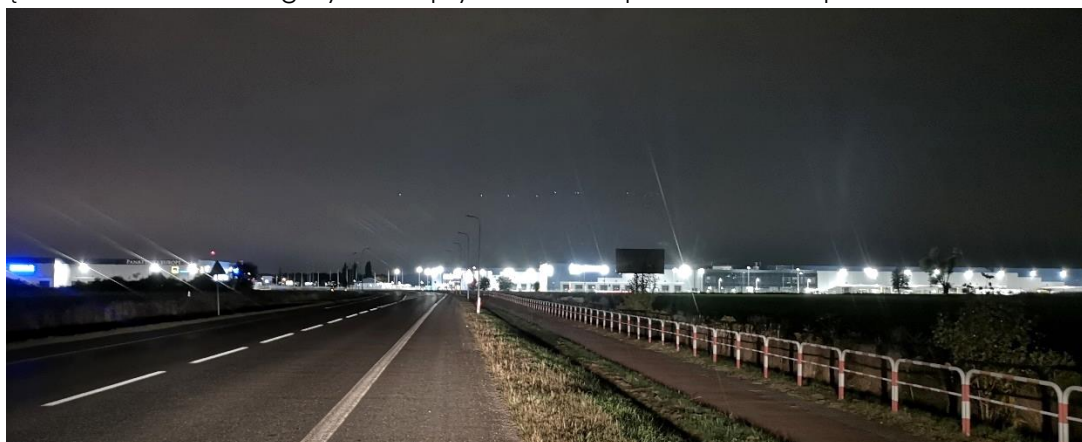
Fot. 4. Oświetlenie nowych terenów magazynowych na terenie niezabudowanym, 4 km od granicy Wrocławia. Białe, nieosłonięte źródła powodują olśnienie, a rozsyłane we wszystkich kierunkach światło rozjaśnia całą okolicę. Aut. Agata Łopuszyńska, 2021.
