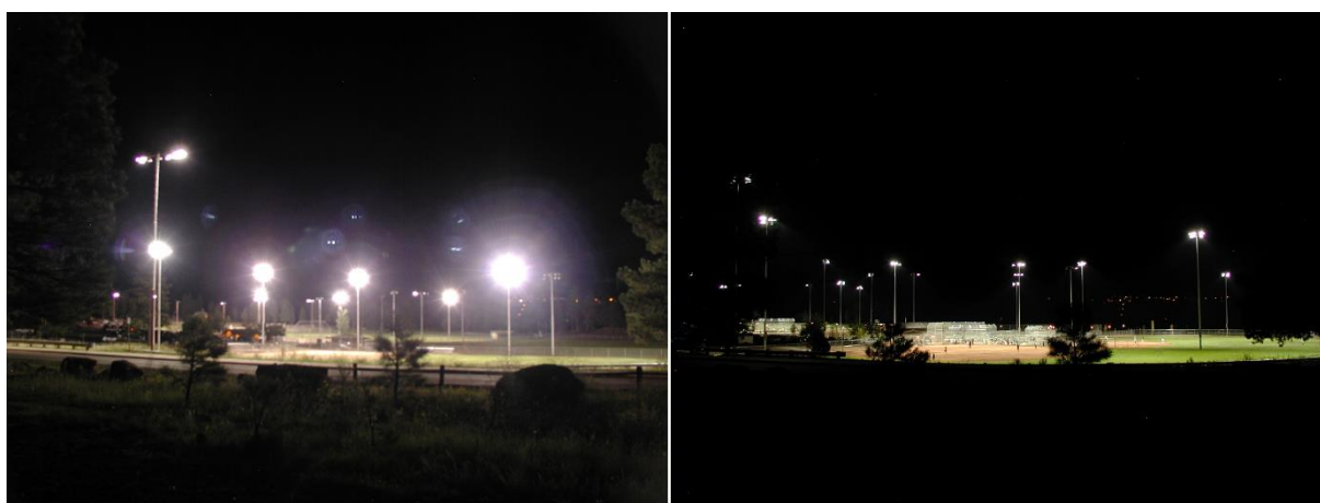
Fot. 24. Przykład rozwiązania dla oświetlenia sportowego Thorpe Park. Poziom oświetlenia pola gry jest dwukrotnie wyższy niż przed modernizacją w 2013 r., przy jednoczesnym braku uciążliwości dla otoczenia.
