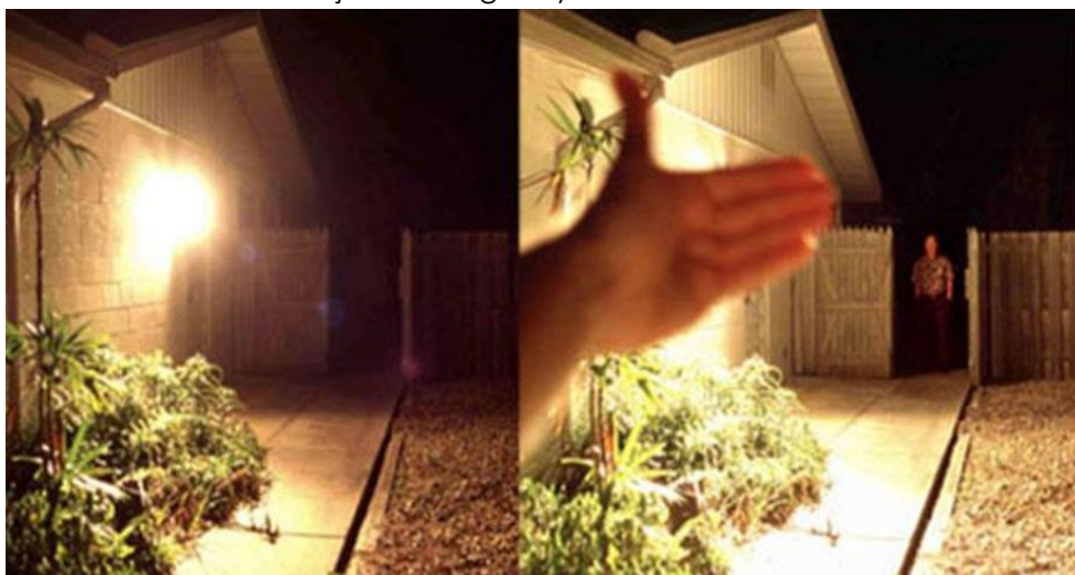
Fot. 8. Ograniczenie widoczności na prywatnej posesji poprzez oświetlenie zalewowe. Nieosłonięte źródło światła i zbyt duże natężenie oświetlenia powodują oślnienie. Źródło: IDA Texas Chapter, www.idatexas.org/
