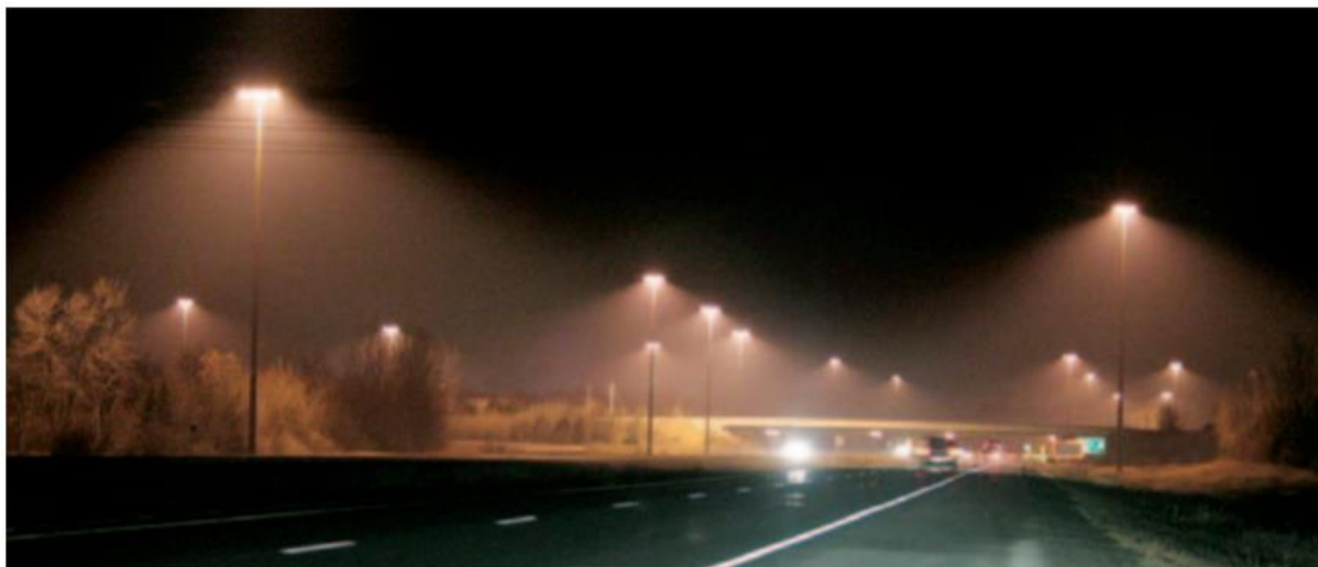
Fot. 30. Oświetlenie skrzyżowania w zachodniej części Ottawy. Zauważalna bursztynowa barwa oraz odcięcie rozsyłu światła poniżej linii horyzontu. Źródło: Dick R., Weeks A., 1997. Fighting.... Dz. cyt.
