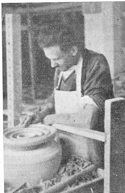
Rys. 6. Wytaczanie izolatora K3
