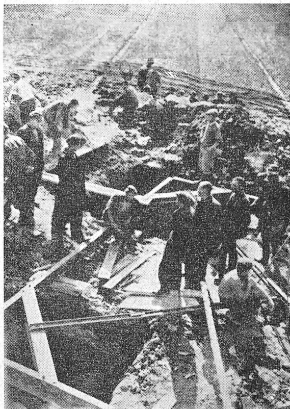
Rys. 5. Ustawianie kotew przy pomocy ramy montażowej (szablonu)
