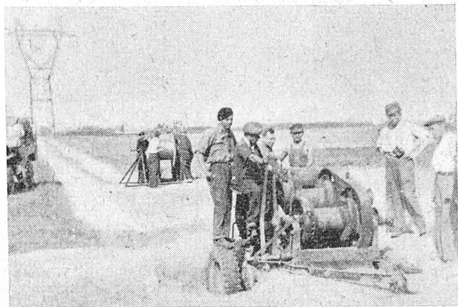
Rys. 5. Stanowisko windy motorowej B
