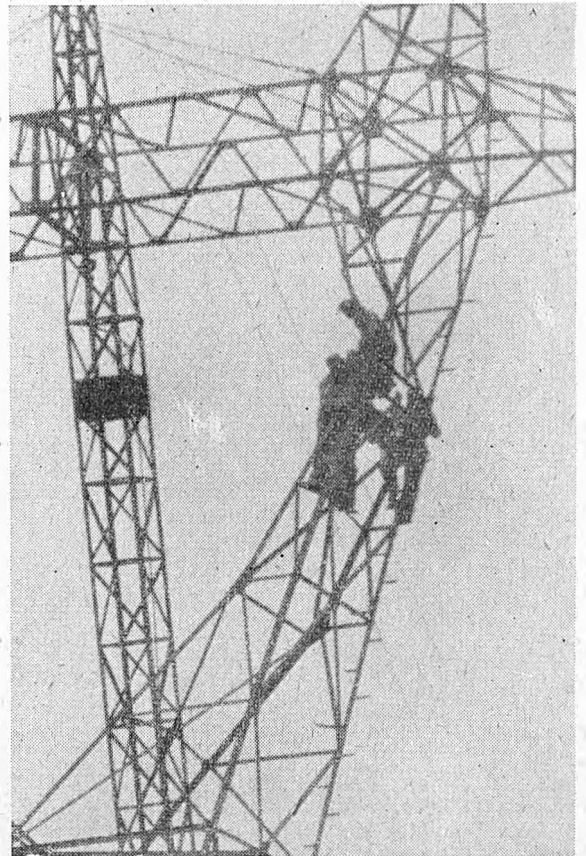
Rys. 20. Łączenie poprzeczki z rozgałęzieniem
