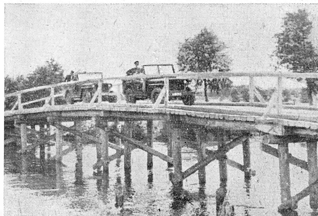
Rys. 3. Most na Warcie zbudowany przez „Mostostal“
