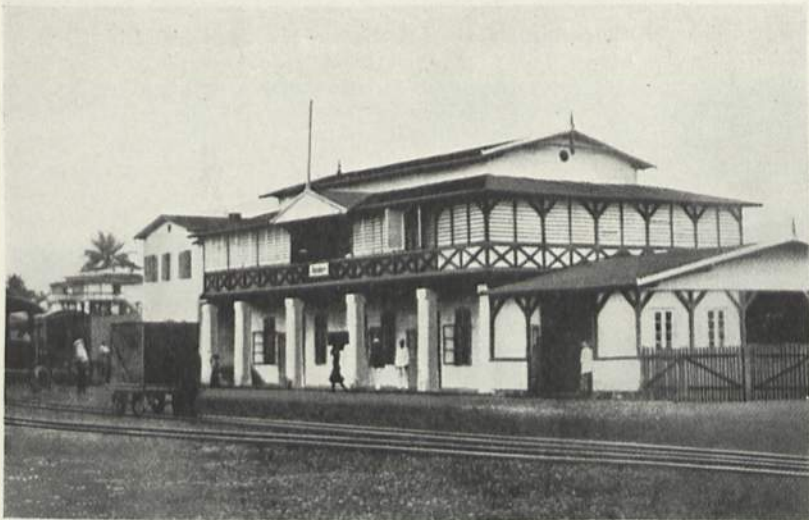
Abb. 24. Deutsches Empfangsgebäude in Bonaberi in Kamerun (Aufnahme Lenz & Co).
