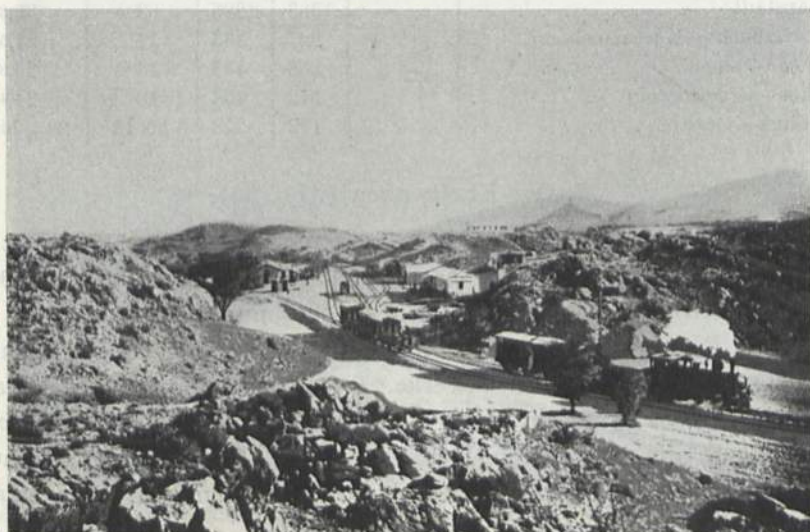
Abb. 42. Bahnhof Aus bei km 40 der Strecke Lüderitzbucht—Keetmanshoop in DSW (Aufnahme Lenz & Co.).
