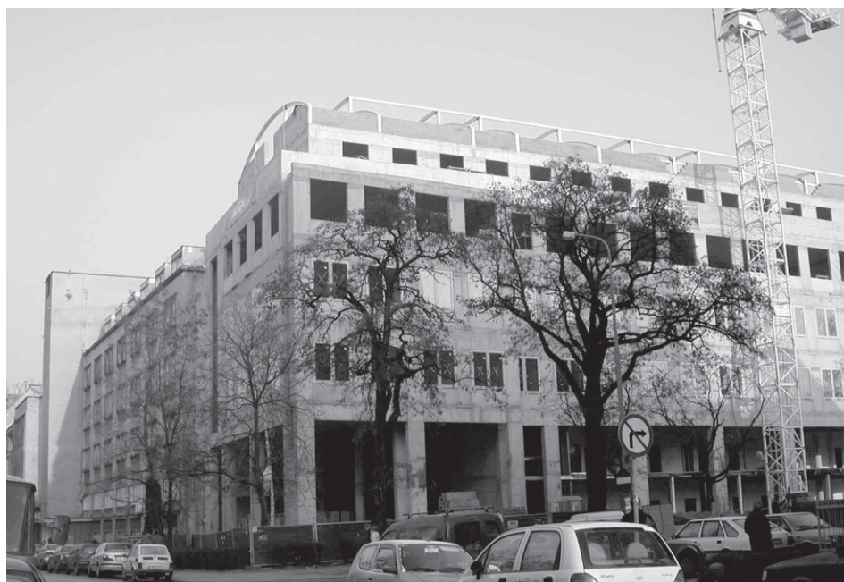
Grudzień 2002. Budynek B-4 w budowie (fot. Wojciech Wieleba)
