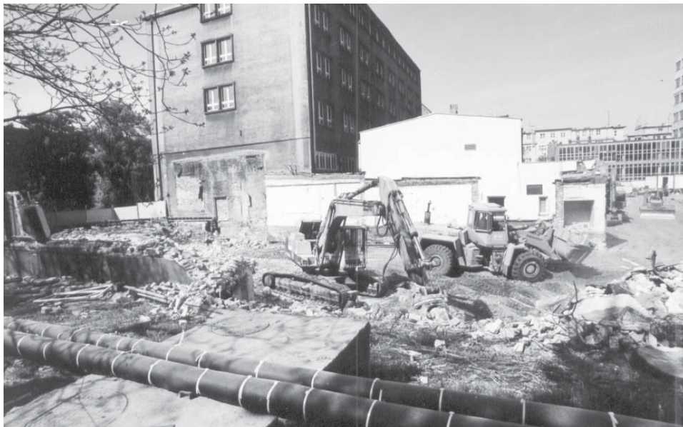
Czerwiec 2002. Rozpoczęcie budowy budynku B-4 na miejscu po pawilonie Instytutu Technologii Maszyn i Automatykacji Wydziału Mechanicznego (fot. Wojciech Wieleba)
