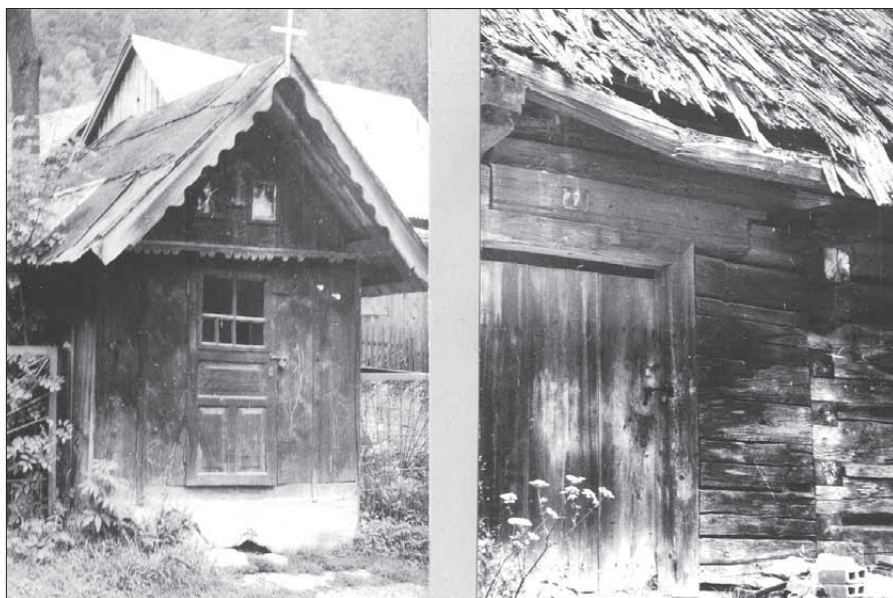
Kapliczka i wejście do chaty w miejscowości Sól koło Rajczy. Fot. z inwentaryzacji budowlanej zabytkowych obiektów w miejscowości Sól koło Rajczy, 1987
